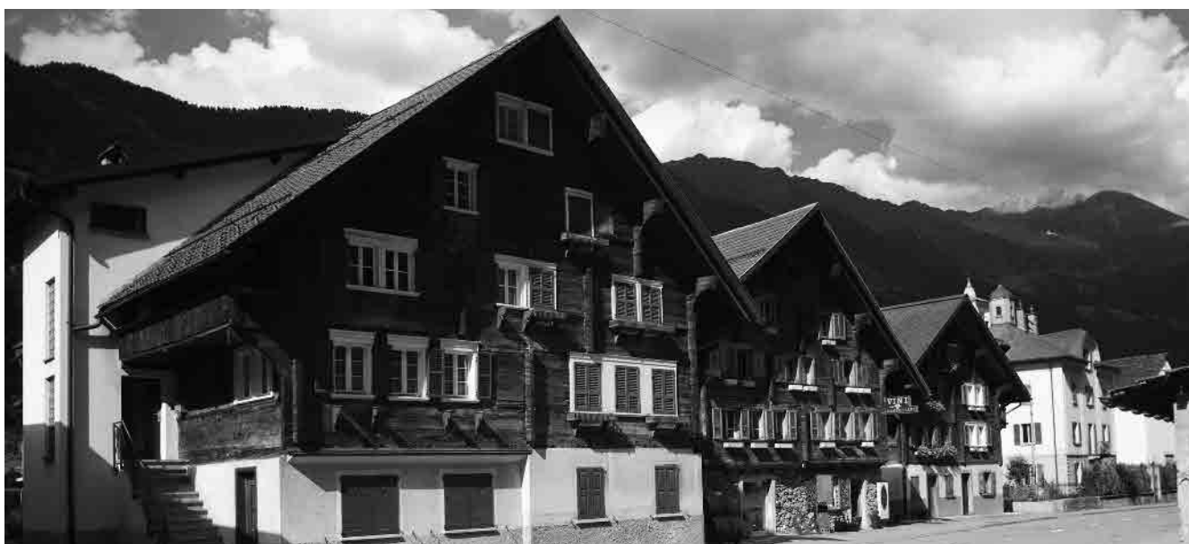
6 La via di attraversamento
