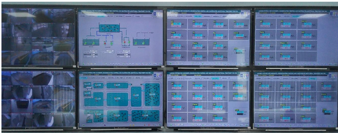
Màn hình điều khiển tại Nhà điều hành hệ thống hồ sinh học
