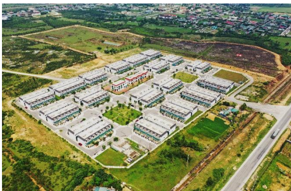
Xây dựng 304 căn nhà liền kề 2 tầng ở Hộ gia đình.
