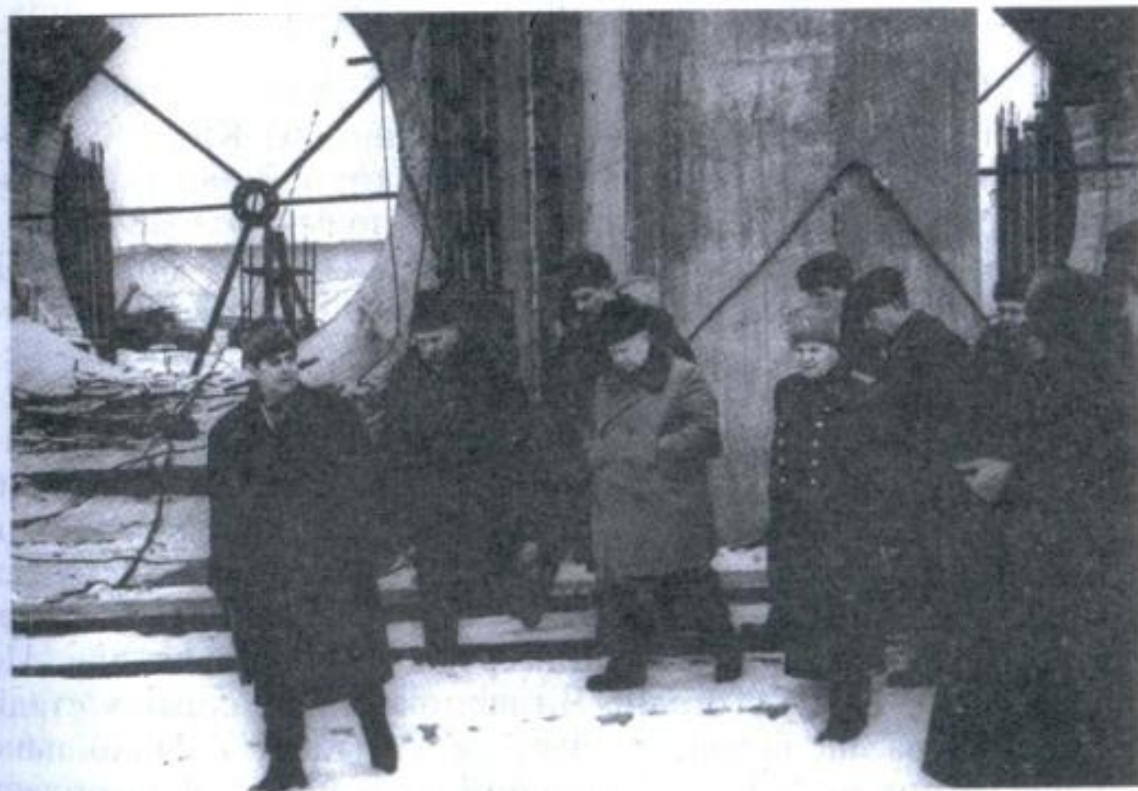
М. С. Хрущов на будівництві Київської ГЕС.
