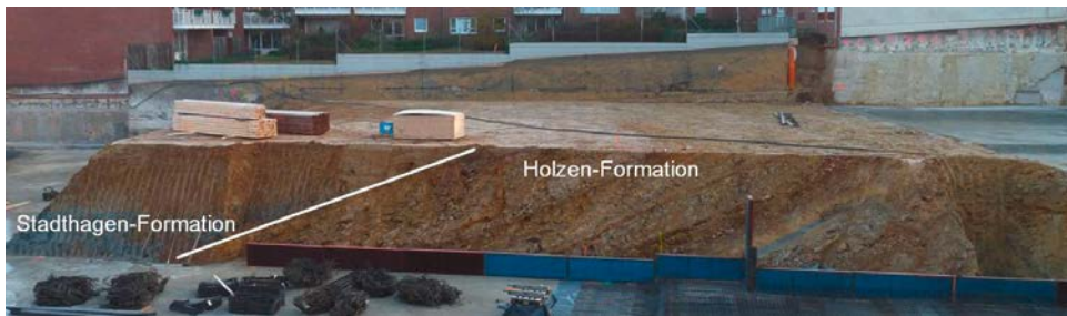
Abb. 22 Ostwand der Baugrube Friedrich-Heller-Straße 2008 mit konkordanter Auflagerung plastischer Tonsteine der Stadthagen-Formation (Unterkreide) auf dünnbankige Kalk- und Kalkmergelbänke der Holzen-Formation. Foto: F. W. Luppold 2008.
