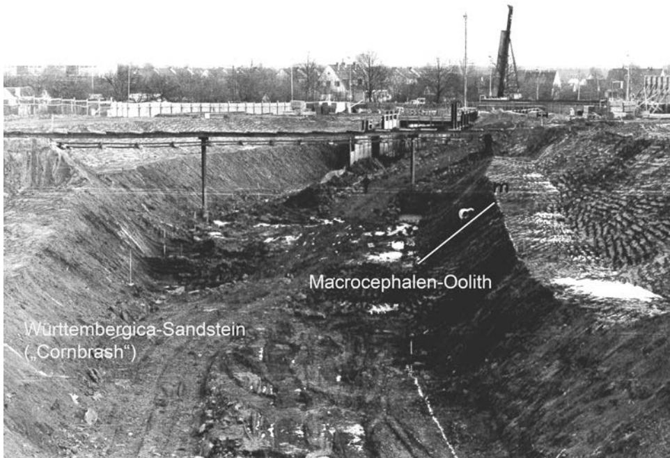
Abb. 9 U-Bahn-Baugrube am Mühlenberg 1975 in Bathonium-Callovium Schichtenfolge; im Hintergrund Hamelner Chaussee/Wallensteinstraße. Rechte Bildhälfte: fossilreicher Macrocephalen-
