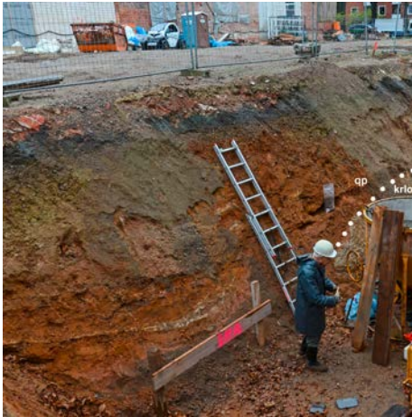
Abb. 4 Baugrube in Hannover-Kirchrode. Großer Hillen 2, Hofbereich. Blick auf die Nordwand, Blickrichtung nach NE.
