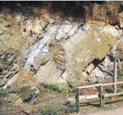
Abb. 9: Im linken Bilddrittel die Ruschelzone von rechts oben nach links unten verlaufend. Die Pfeile geben die Bewegungsrichtung der Blöcke an.
