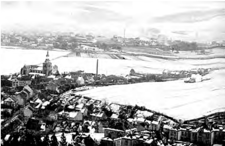
Wackenberganlage vor der Bebauung aus: Wackenbergecho
