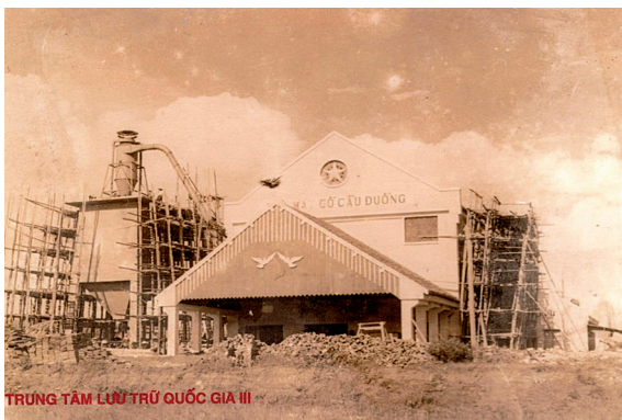
Cảnh Nhà máy Gỗ cầu Đường sắp hoàn thành
