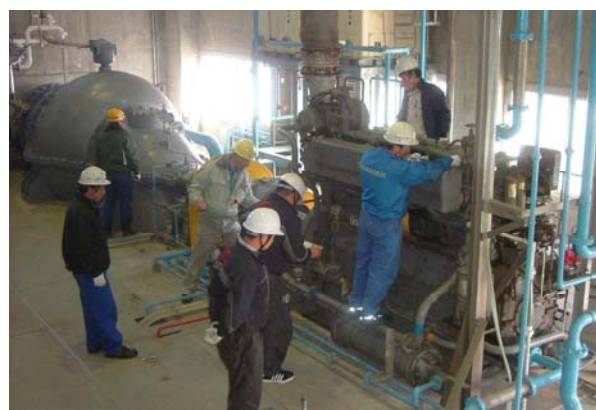
排水ポンプ場（排水機場）の点検
