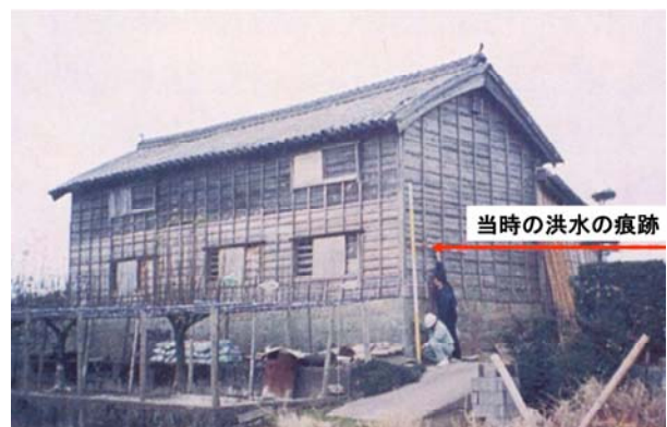
民家に残る大正元年9月洪水の痕跡(北島町新喜来 しんきらい )
