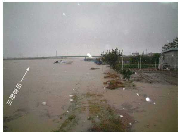
平成16年10月洪水による無堤地区の 旧吉野川はん氾濫(鳴門市大麻町) 旧吉野川右岸の河口より7.6km付近
