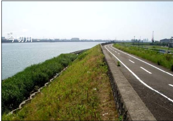
景観に配慮した護岸の整備事例 今切川右岸河口より4km付近
