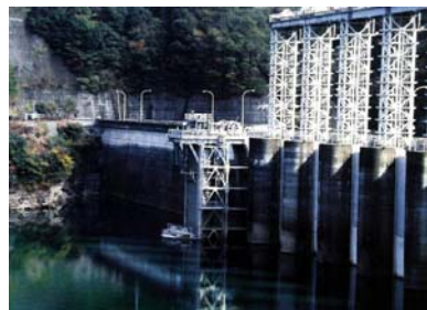
選択取水設備（早明浦ダム）
