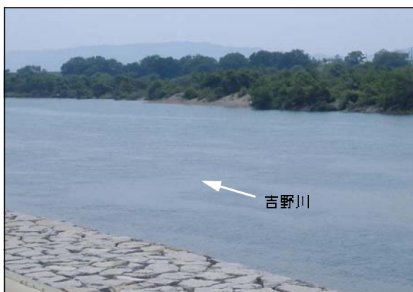
ヤナギ類等の樹木繁茂(上板町) 吉野川河口より20km付近
