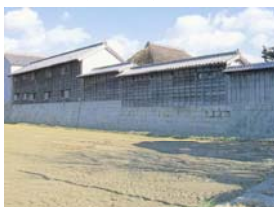
↑高石垣(たかいしがき) (家屋の浸水を防ぐ石垣)
