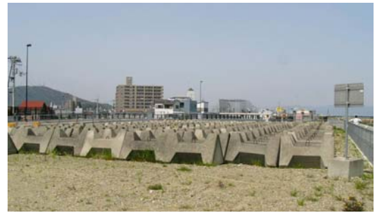
水防資材（根固めブロック）の備蓄状況
