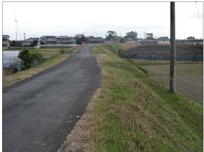
鳴門市大麻町津慈の旧堤防
