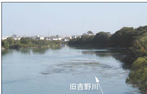
湛水区間の水域環境（藍住町） 旧吉野川右岸河口より15km付近
