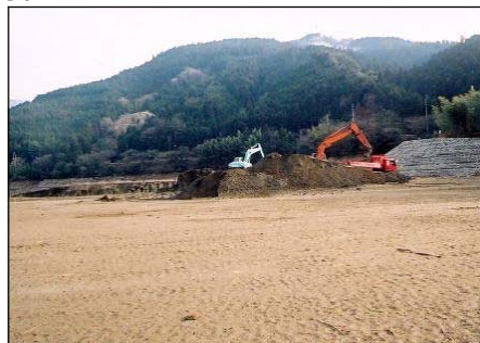
堆砂除去の状況（柳瀬ダム）
