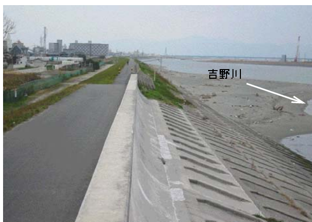
現状の堤防写真
