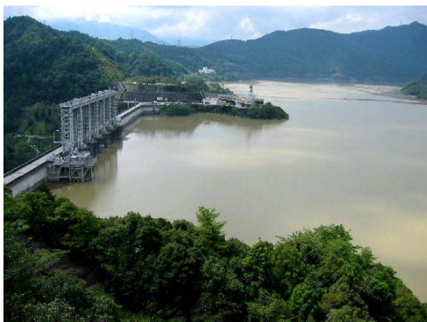
早明浦ダムの濁水発生状況 (平成17年9月)
