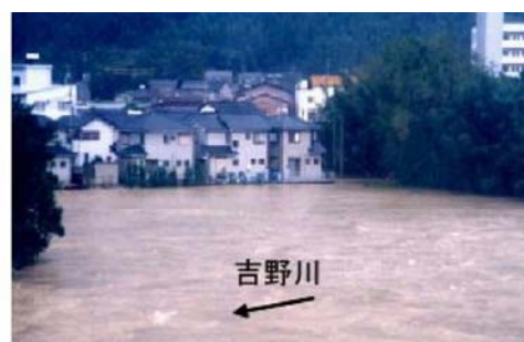
平成16年10月洪水による無堤地区へのはん濫（東みよし町）
