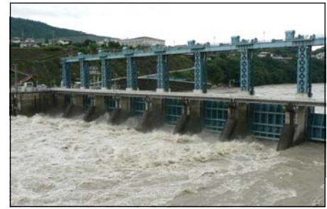
池田ダム (平成17年9月洪水)
