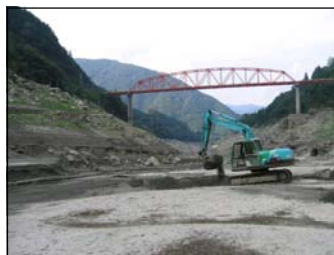
底泥除去（早明浦ダム）
