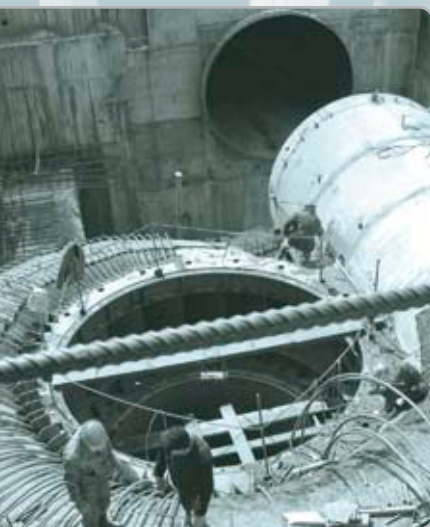
Монтаж турбины Зарамагской ГЭС
