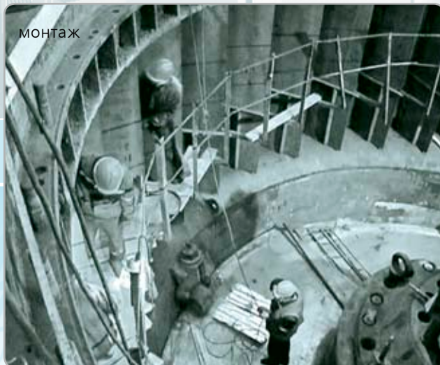
Монтаж статора гидроагрегата на Новосибирской ГЭС
