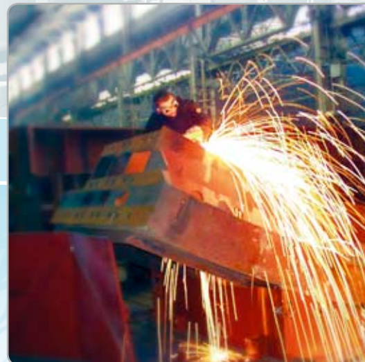
Обрезка старых клиновых полос на секторе Саратовского гидрогенератора
