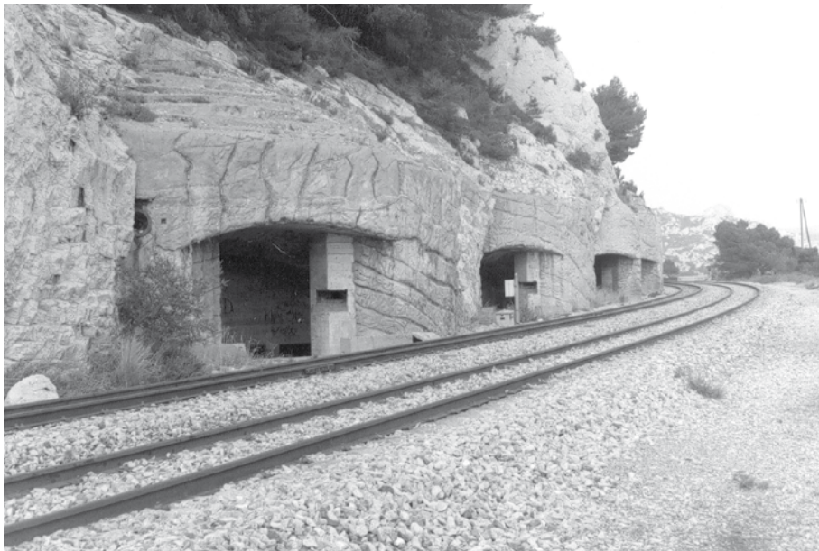
Ouvrages allemands près du chemin ferré de l'Estaque © Coll. Charles Jansana
