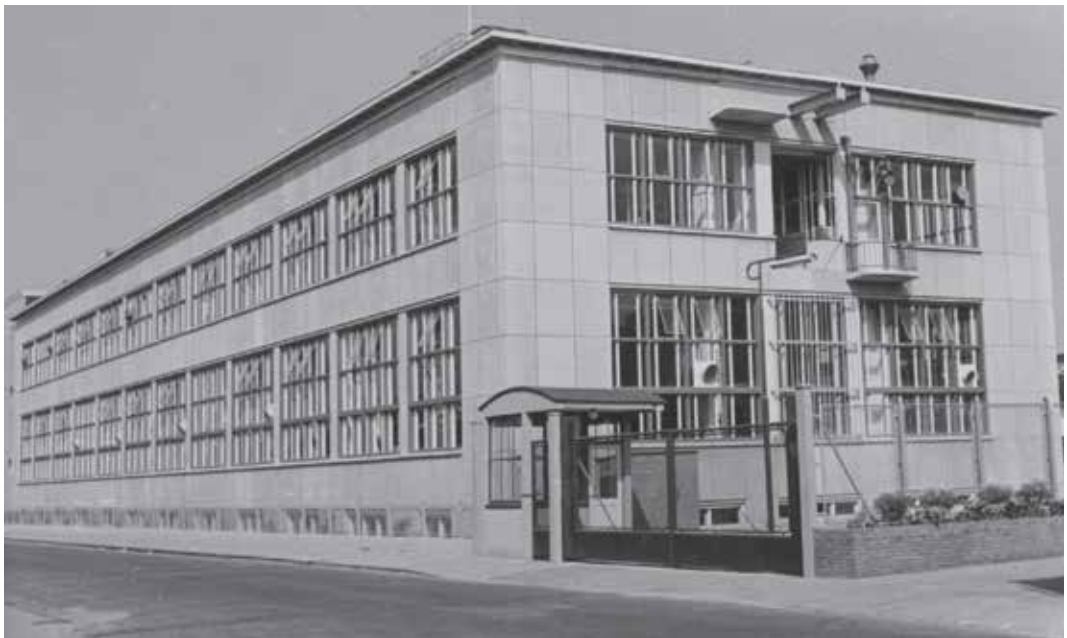
In 1956 werd aan de Binnenhoek deze boilerfabriek van Daalderop gebouwd. Het storten van beton met een persleiding was een novum voor Tiel en trok tot in de nachtelijke uren veel bekijks. (Collectie De Vree en Sliepen)
