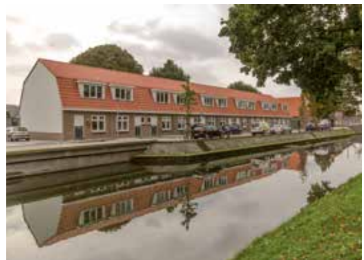
Gerenoveerde vooroorlogse woningen voor woningcorporatie SCW aan de Sint-Walburgbuitensingel (Collectie De Vree en Sliepen)
