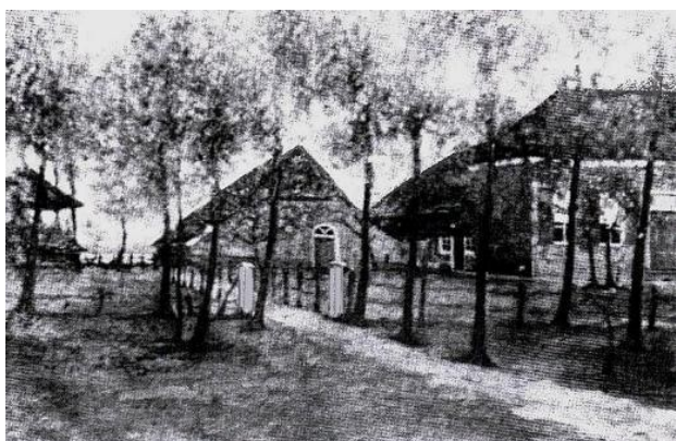
Geheel links staat de vier-roedige hooiberg. Halfweg de inrit staan de pijlers van een inrijpoort
