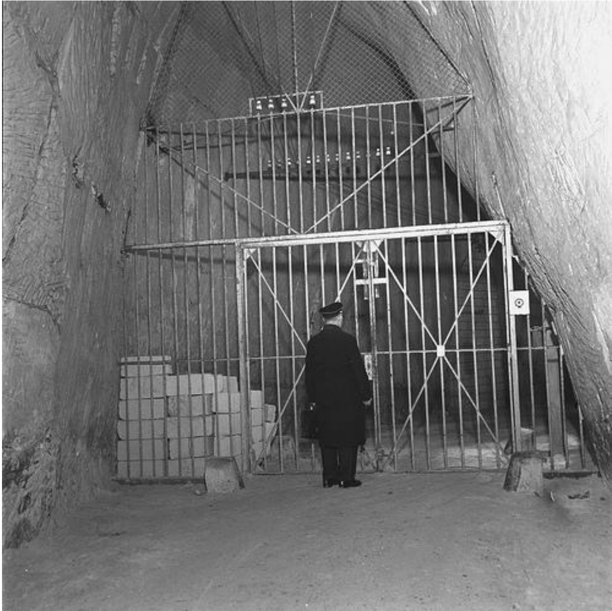
Figuur 14: Één van de ijzeren traliehekken in de Van Schaik tunnel
