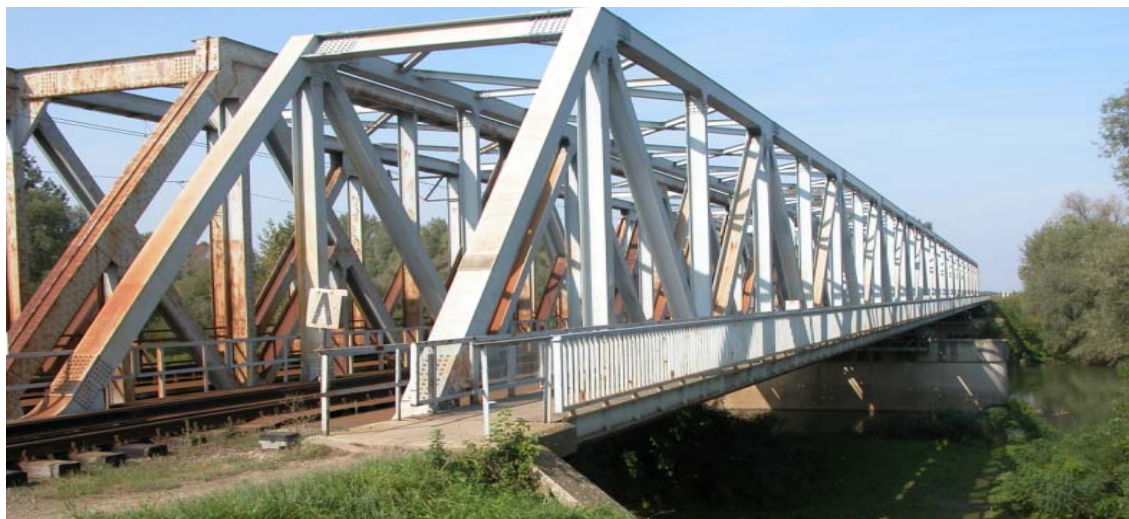
9. ábra: A Gyoma–Dévaványa közti vasúti híd ma
