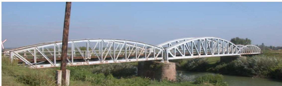
24. ábra: A mai vasúti híd a Fehér-Körösön
