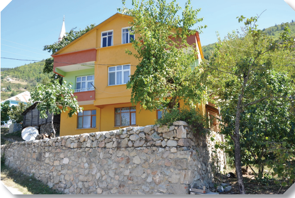
Fotoğraf 4: Taşluca Köyü-Merkez Mahalle-Tarihi Zaviyenin Yerine İnşa Edilen Bina
