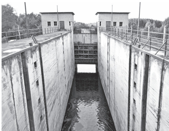
Рис. 9. Камера и нижняя голова шлюза Зандхоф
