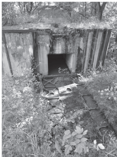
Рис. 7. Откидные ворота в судоходном пролете верхней головы шлюза Кляйн Байорен (открыты)
