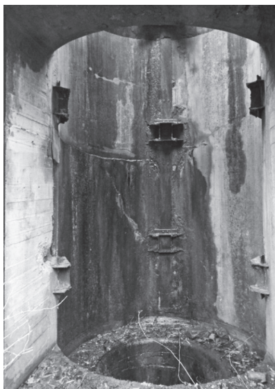
Рис. 12. Шахта и затворный узел ЦПЗ (вид через водозаборное окно)
