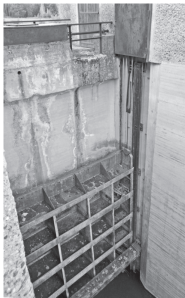
Рис. 6. Подъемно-опускные ворота шлюза Зандхоф
