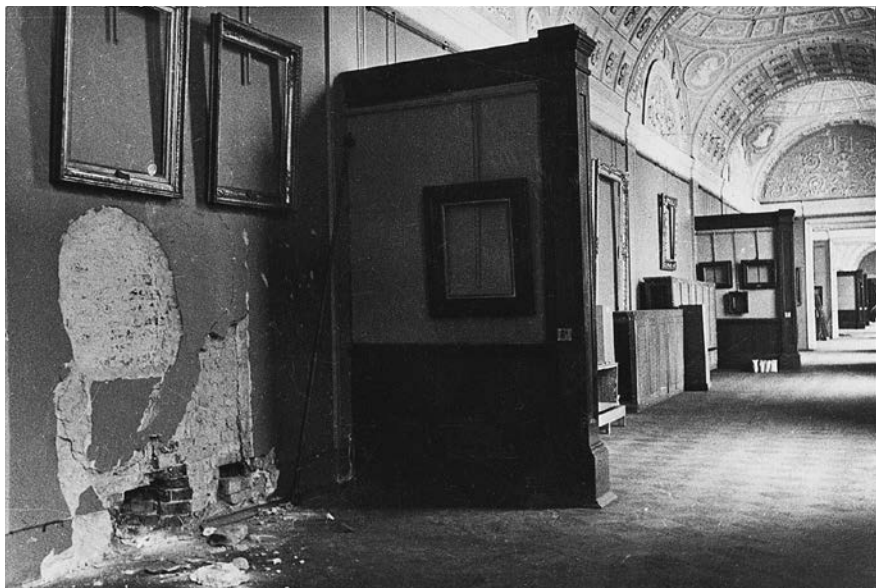
Разрушенная стена в Романовской галерее. 1942 г. Фотография Б. П. Кудоярова
