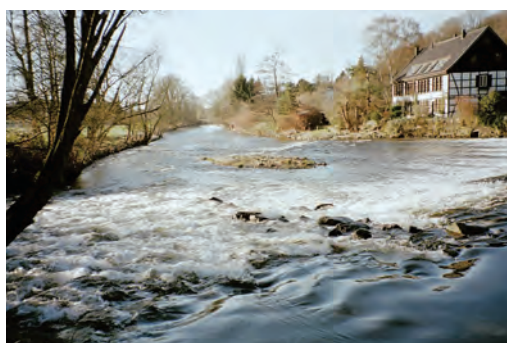
Abb. 2.1.3.3-3 Wupper am Wipperkotten bei Solingen (Flusskilometer 16). Historischer Schleifkotten mit altem Wehr (rechts) und neu angelegter rauer Rampe als Fischaufstiegsanlage. Beispiel für Strukturgüteklasse 5 (stark verändert)
