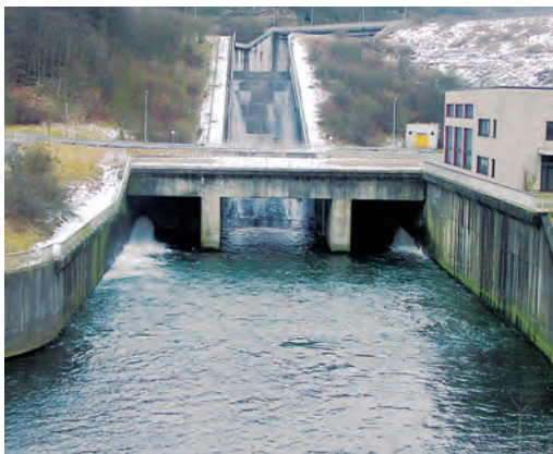
Abb. 4.2-1 Staudamm der Wuppertalsperre [Foto: M. Knippenberg]
