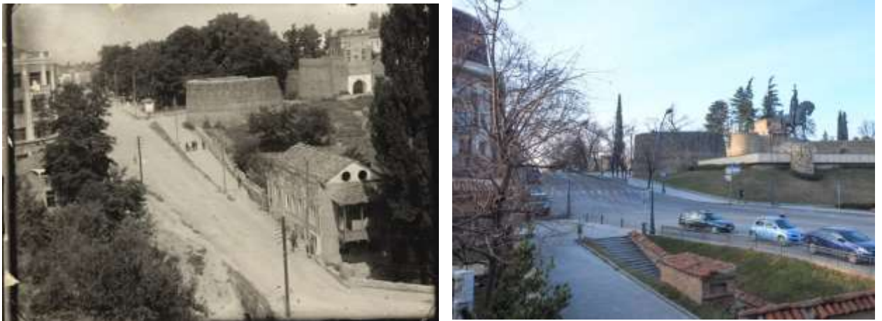
ილ. 20. საზარბაზნე ბურჯი, საარქივო ფოტო, საზარბაზნე ბურჯი, თანამედროვე ფოტო
