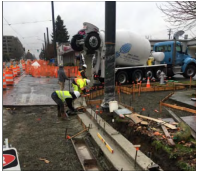
Curb & Gutter Pour – MLK & 14th – H3
