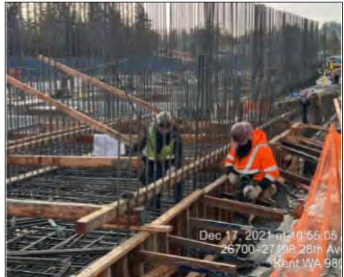
WA 2.4 SL.03 Rebar Placement W
