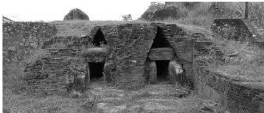
Maduru oya sluice
