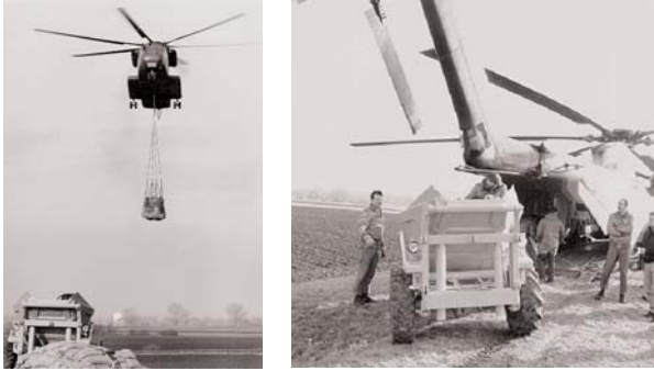
Abb. 70: Transport von Sandsäcken
