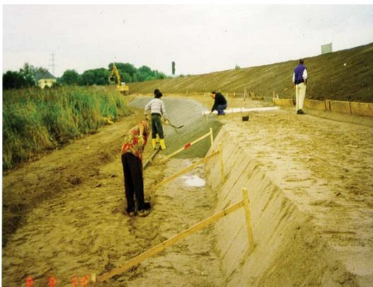
Abb. 20: Einbau des Fußfilters aus Porenbeton
