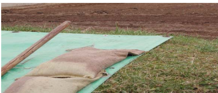
Abb. 58: Befestigung des Lecksegels
