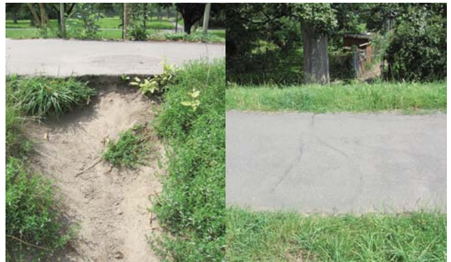
Abb. 75: Zu naher Bewuchs und Durchwurzelung können zu einer stärkeren Durchsickerung und zu Materialaustrag führen.
