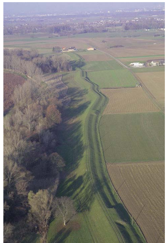
Abb. 14: Zu sanierender Deich bei Trebur
