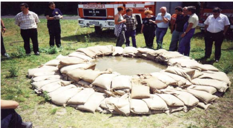
Abb. 53: Ringdamm aus Sandsäcken bei einer Übung
