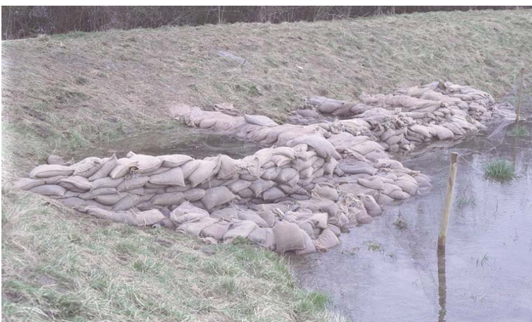
Abb. 46: Reihe mehrerer Quellsacke am landseitigen Deichfuß
