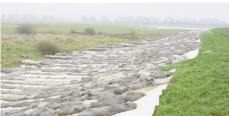
Abb. 51: Stützung der landseitigen Böschung durch Filtermatte mit Sandsackauflast (Auflastfilter)
