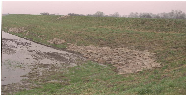
Abb. 50: Sandsackauflast zur Sicherung des landseitigen Böschungsfußes
