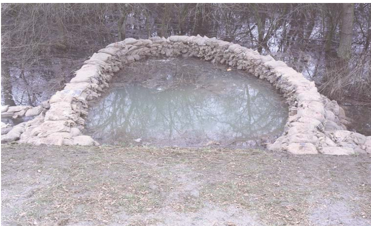
Abb. 45: Einzelner Fangedamm an einer lokalen Austrittsstelle
