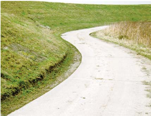
Abb. 18: Deichverteidigungsweg aus Stahlbeton
