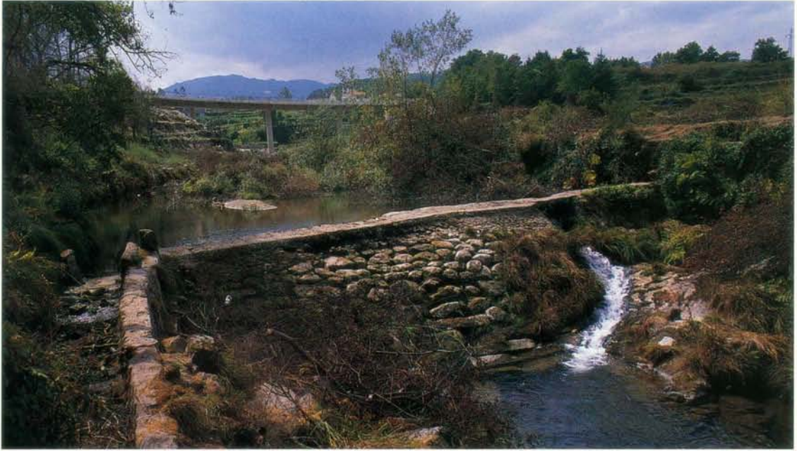
Açude do Cabrão. Vista geral de jusante, com descarga por orifício junto da margem esquerda e levada na margem direita
