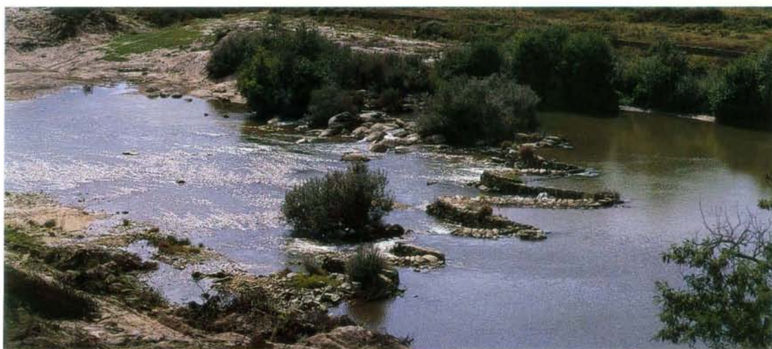
Açude da Várzea, em labirinto. Vista geral de montante
