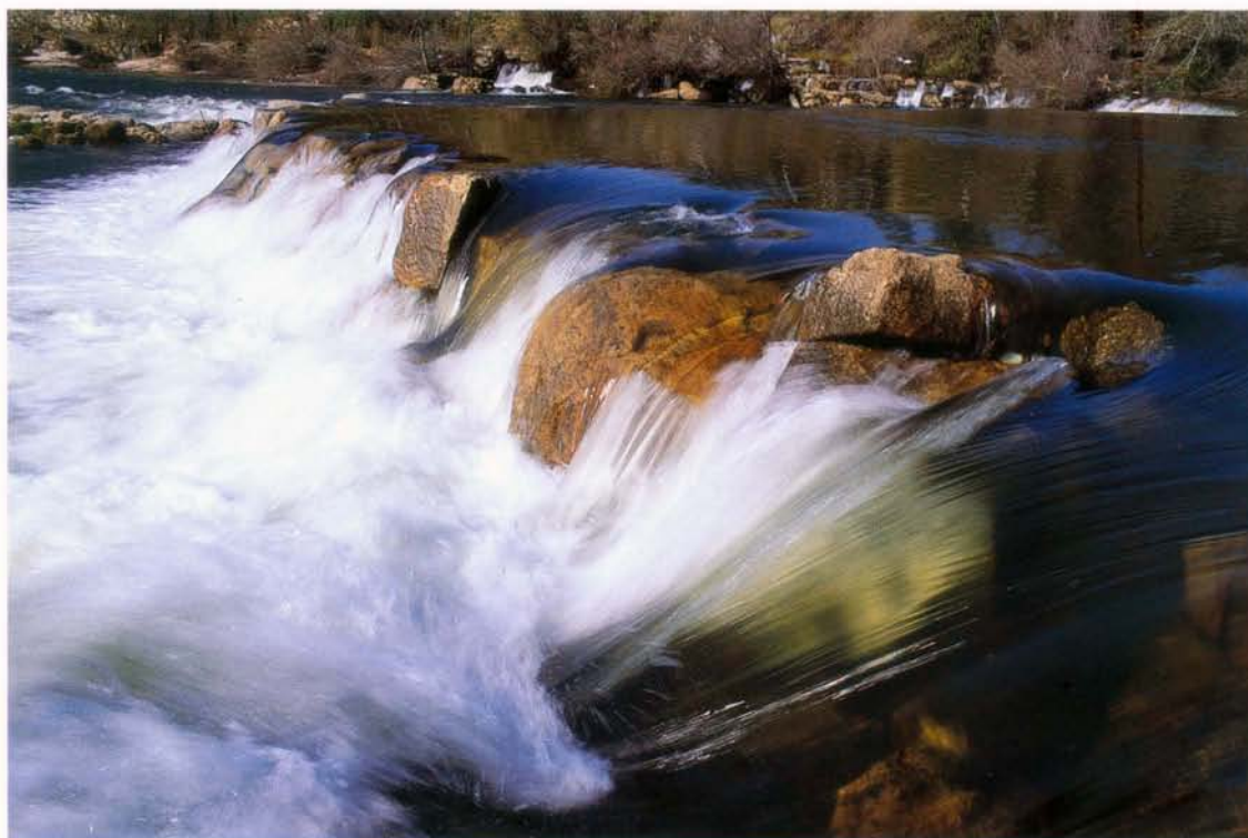
Água tranquila a montante e turbulenta a jusante de um açude em labirinto, construído de grande blocos graníticos justapostos
