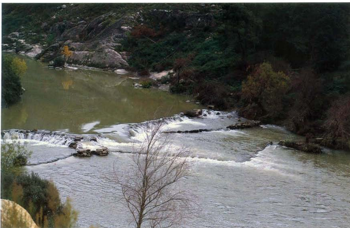
Açude múltiplo da Ramada. Vista geral de jusante
