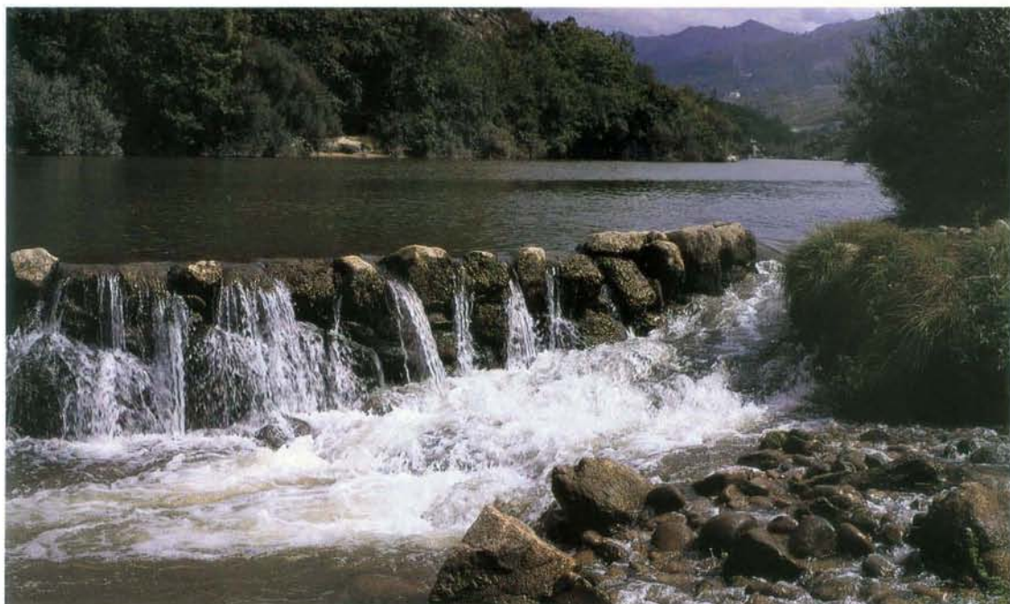
Açude da Curveira, em labirinto. Pormenor do bocal, junto da margem esquerda
