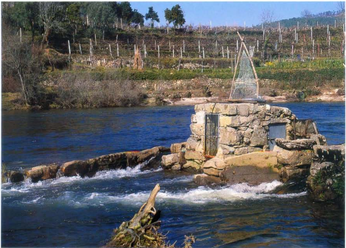
Guarita para instalação do engenho de peixe da pesqueira fabriqueira da igreja de Touvedo (S. Lourenço). No tecto da guarita pode observar-se uma nassa
