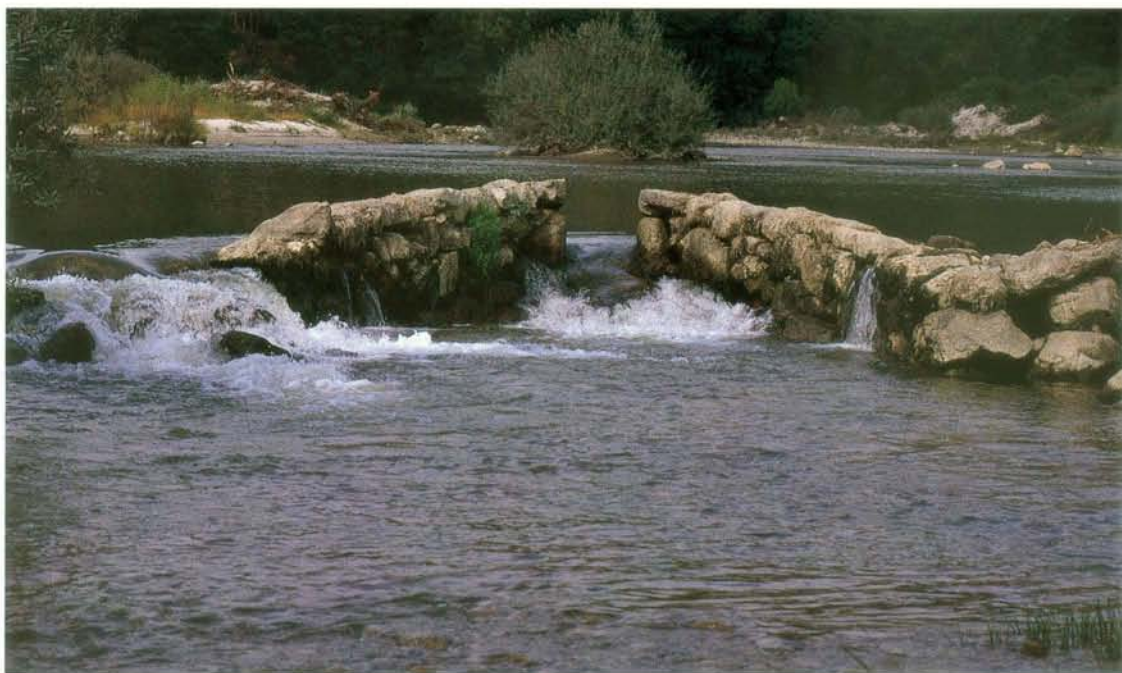
Açude da Várzea, em labirinto. Bocal de pesqueira num vértice voltado para montante
