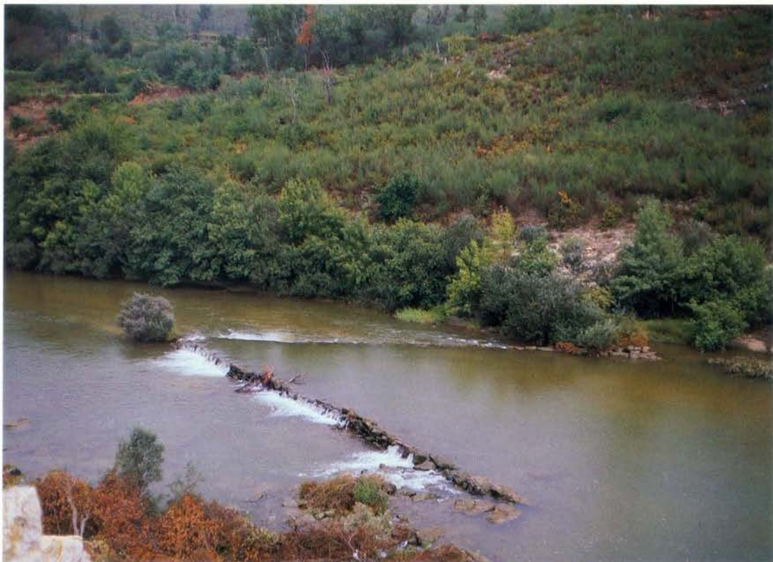
Açude do Gama, em labirinto. Vista geral, mostrando bocal de pesqueira, junto da margem esquerda
