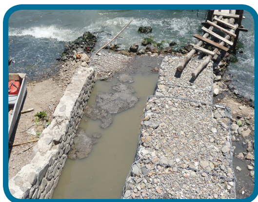
Figura. 6. Afluente de aguas residuales no tratadas en Santa Cruz La Laguna.
