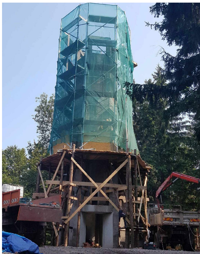
Odbudowa wieży w 2018 roku
