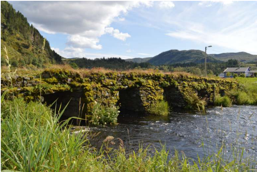
Hålandsbrua på Den trondhjemske postvegen
