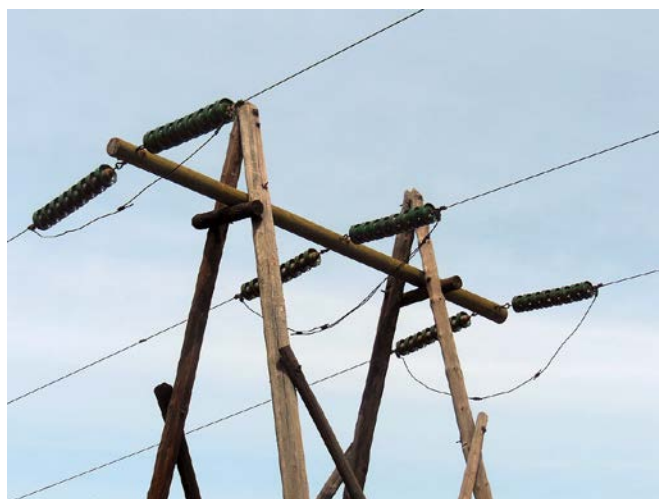
Рис. 6.9: деревянная анкерная и металлические угловые опоры линий НиГРЭС им. Винтера
