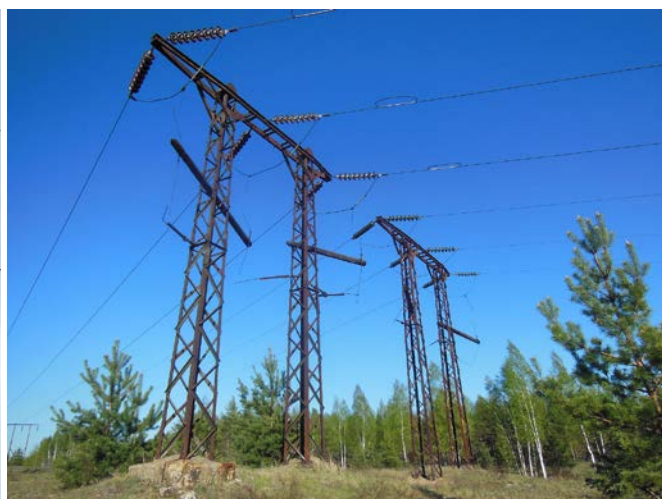
Рис. 6.9: деревянная анкерная и металлические угловые опоры линий НиГРЭС им. Винтера
