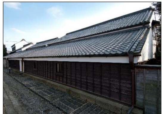
写真 b)-3 油伝味噌土蔵 [明治23年(1890)以前建築《文献》] 国登録文化財・伝統的建造物
