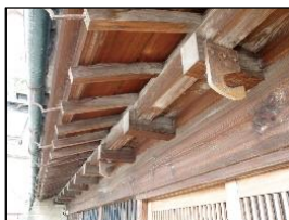
写真 出桁造
