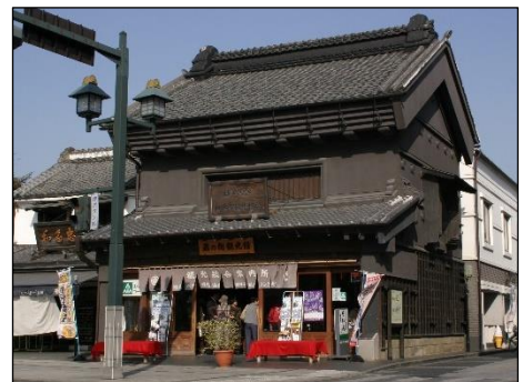
写真 とちぎ蔵の街観光館（旧田村家）
