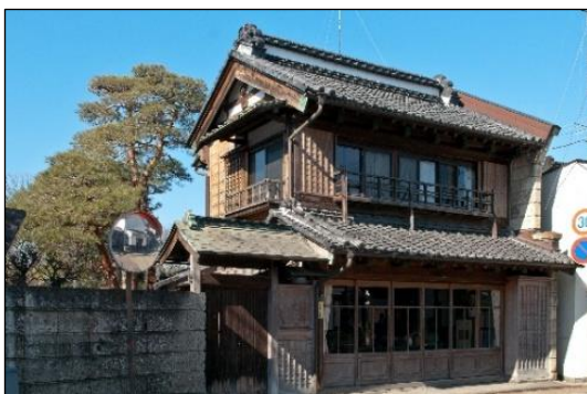
写真 a)-7 あまがい 天海家店舗 [大正12年(1923)建築《建築様式》] 国登録文化財・伝統的建造物
