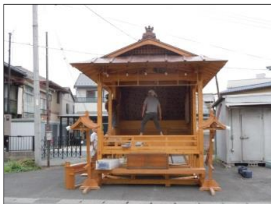
写真 設営された仮殿
