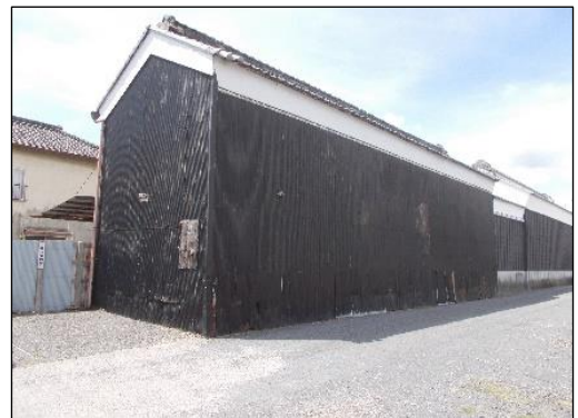
写真 本澤商店土蔵（東側）
