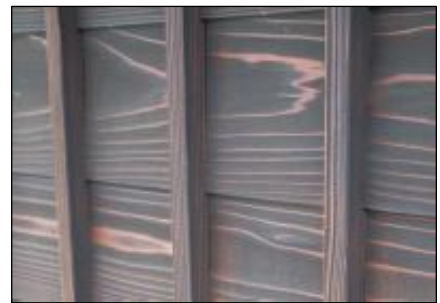
写真 簾子下見板張り
