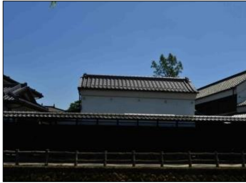
写真 b)-10 塚田家住宅旧米蔵 こめぐら [大正13年(1924)建築《建築様式》] 国登録文化財・景観重要建造物
