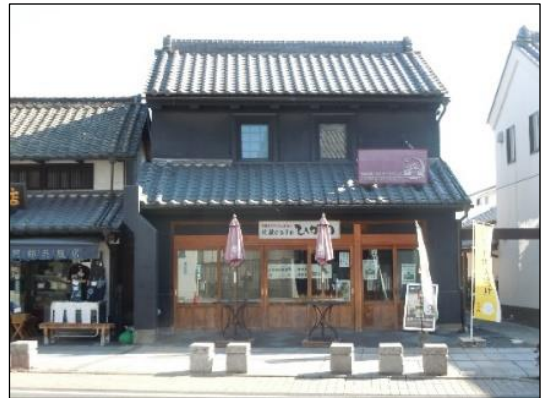
写真 a)-8 北蔵カフェひがの 【 きとう 佐藤家住宅店舗】 [明治中期建築《建築様式》] 国登録文化財
