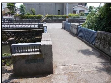
写真 ⑳栃木橋 (昭和44年(1969))
