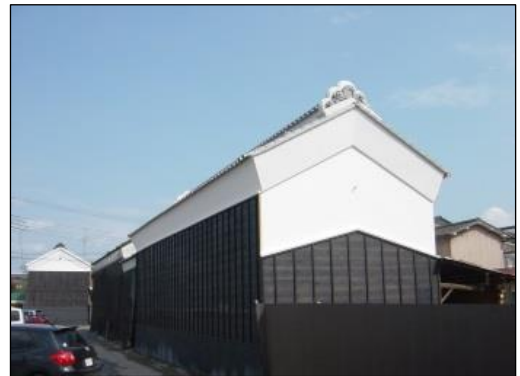
写真 本澤商店土蔵（西側）
