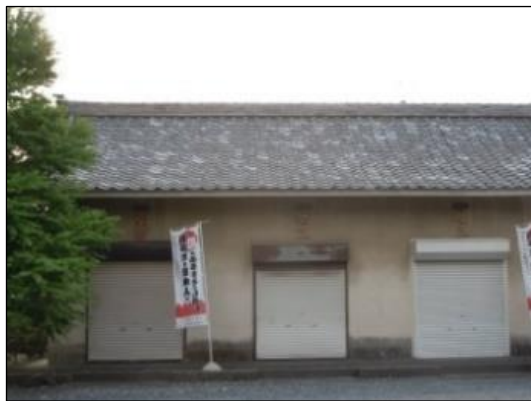
写真 神明宮境内の山車収納庫
