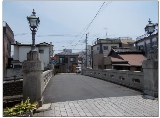
写真 ②倭橋 (昭和5年(1930))
