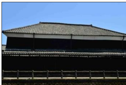
写真 b)-8 塚田歴史伝説館 人形山車・ めいぼく 銘木展示館 (旧荷蔵) [明治42年 (1909) 建築《墨書》] 国登録文化財・景観重要建造物
