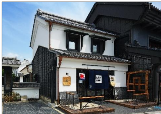
写真 a)-3 日光珈琲蔵ノ街 【綿忠はきもの店店舗】 [安政3年(1856)建築《墨書》] 国登録文化財
