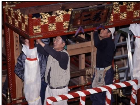
写真 山車の組み立て
