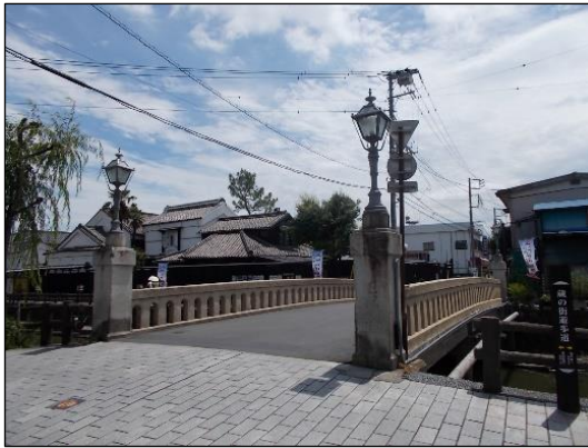
写真 ③巴波川橋 (昭和9年(1934))
