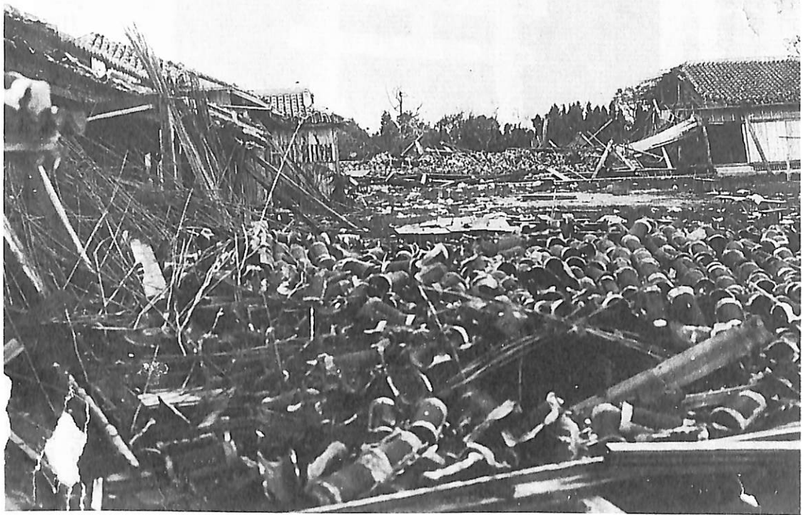
猛烈な風雨で被害を受けた竹富尋常小学校（竹富）
