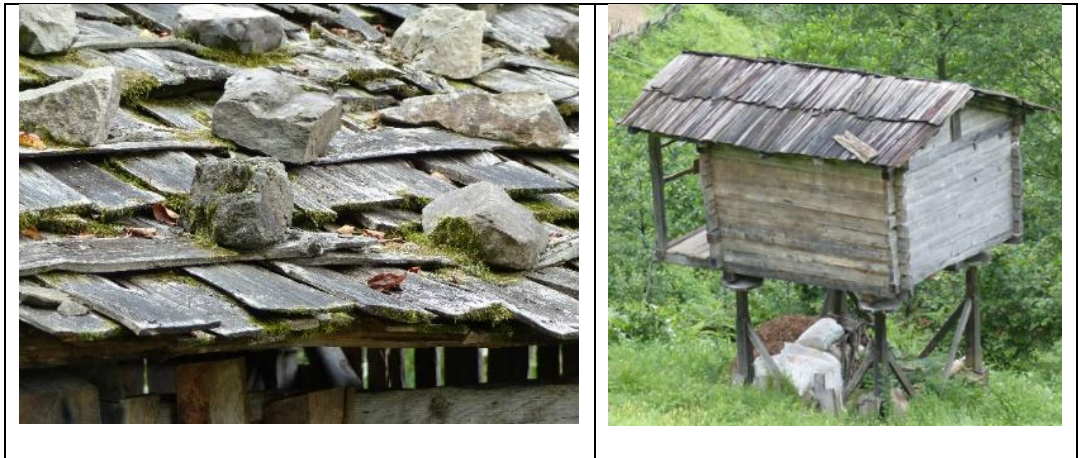
Resim 2.21 Geleneksel ahşap çatı örtüsü (hartama-pedevra).
