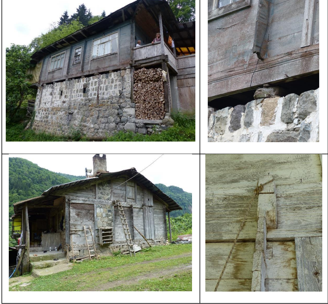
Resim 2.13 İç duvar-cephe duvarı ilişkisi
