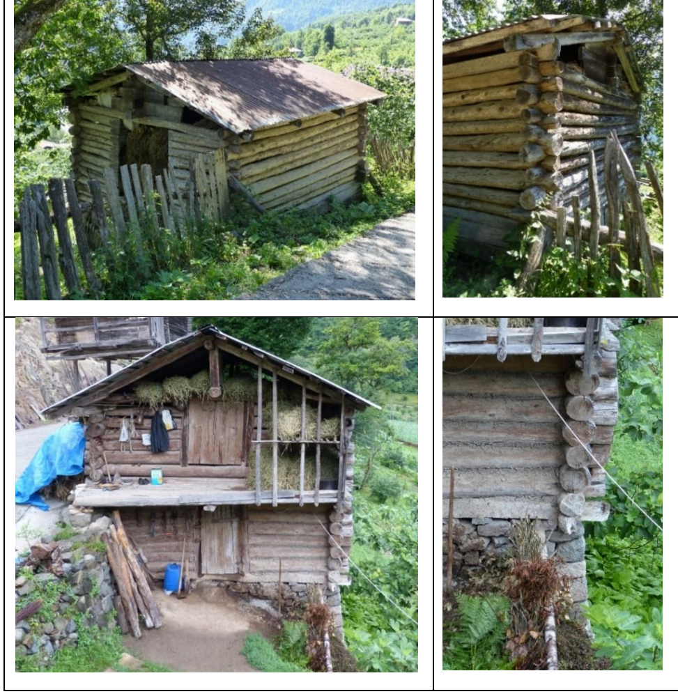
Resim 2.14 Kütük yığma duvarın samanlık ve ahır yapılarında kullanımı.
