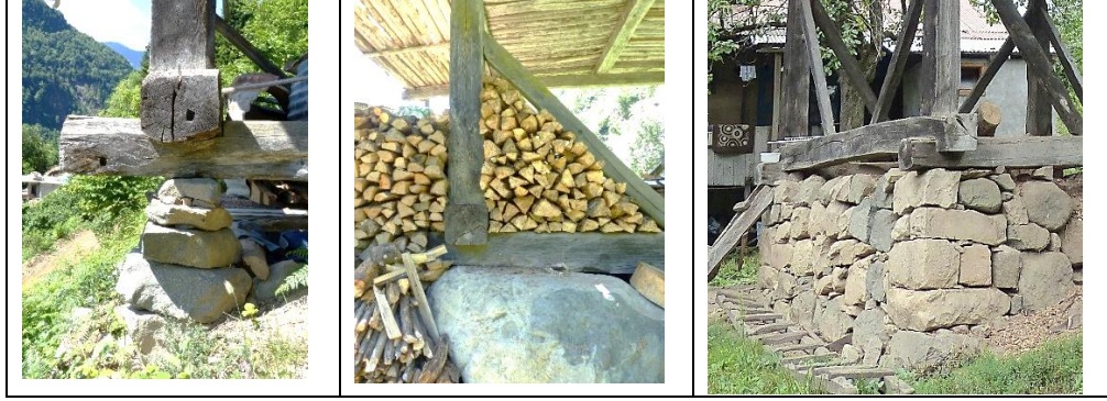
Resim 2.26 Serender alt çatkısının zemin ile ilişkisi.
