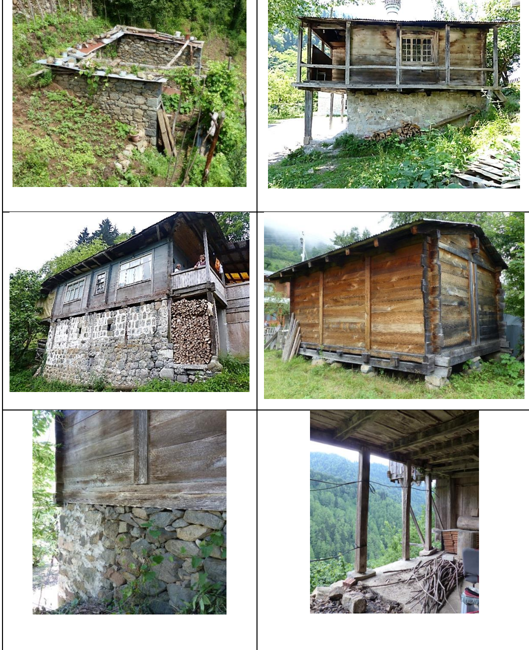
Resim 2.3 Ahşap yapı taş duvar ilişkileri.
