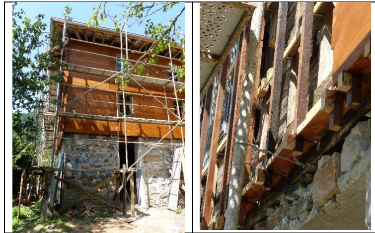
Resim 3.1 Ahşap yapıyı korumak için, kalas duvar üzerine karkas çakılarak lambri kaplanması. İrem Camii / Maral.
