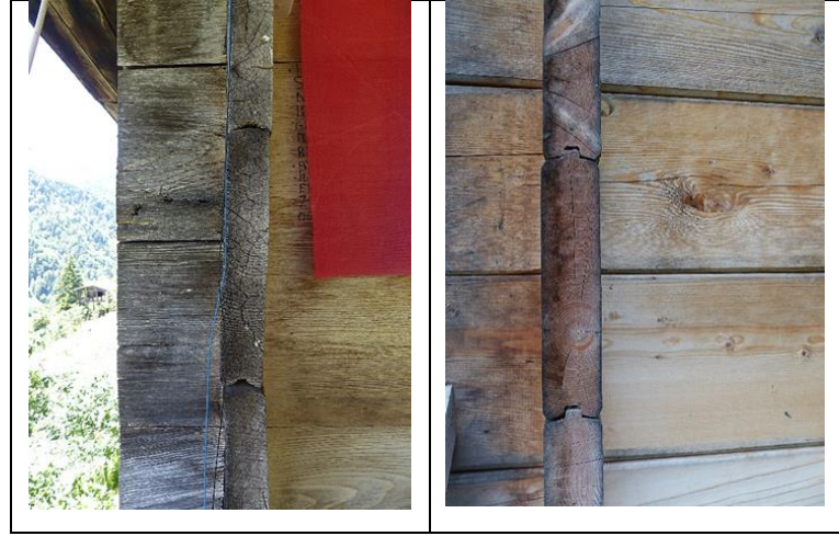
Resim 2.5 Dizilerin eski (solda) ve yeni birleşim (sağda) detayları.
