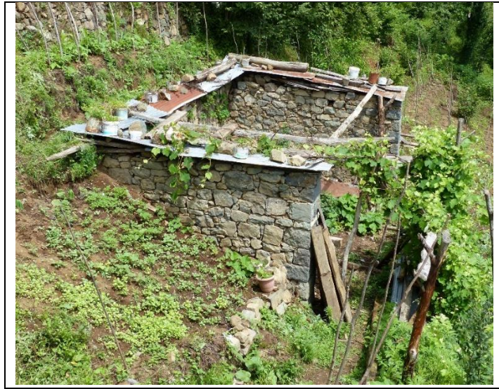
Resim 2.24 Bahçe katını ve temeli oluşturan taş duvarlar.
