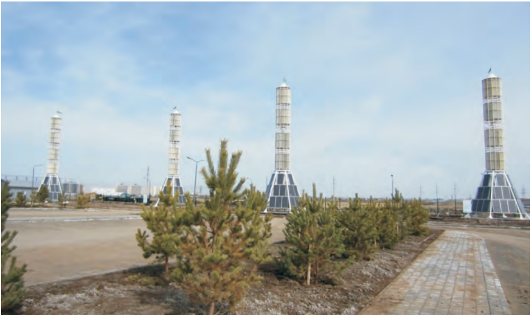
Рисунок 2 – Комплексные энергетические системы ВРТБ – автономные источники энергии на объектах в Республике Казахстан
