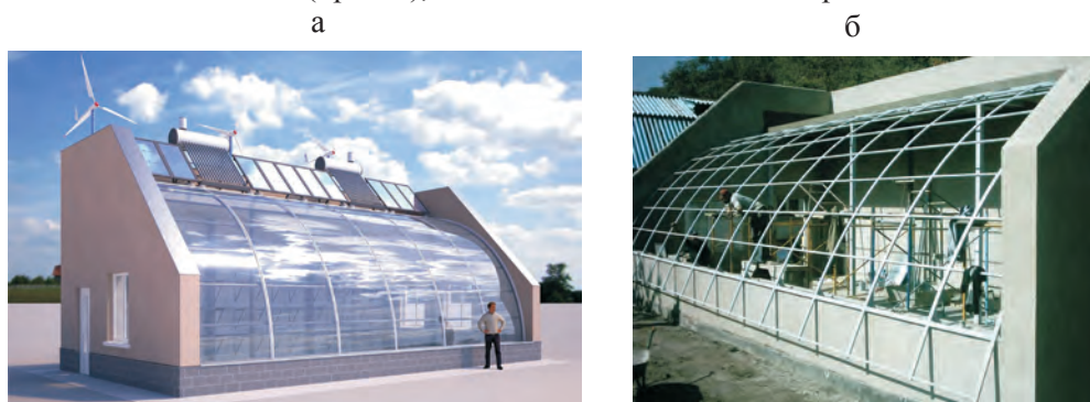
Рисунок 2 – Проект всепогодной теплицы с гибридной системой энергоснабжения (а) и опытный модуль теплицы в состоянии строительства (б)
