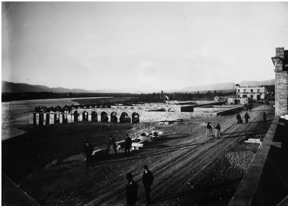
Imatge 1. Vista general dels treballs de construcció dels fonaments de l'escorxador. Es pot observar com el sistema de pilons de maçoneria relligats amb arcs ceràmics es construeix sobre el llit del riu. (Ramon Borrell, 1907.) Fons Ramon Borrell, ACTE.
