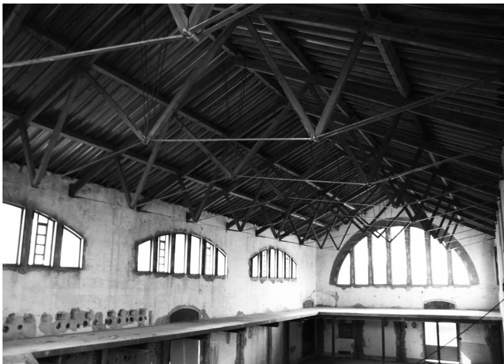
Imatge 5. Sistema d'encavallades mixtes de fusta i ferro de la sala d'aireig. (Jordi March, 2006.)
