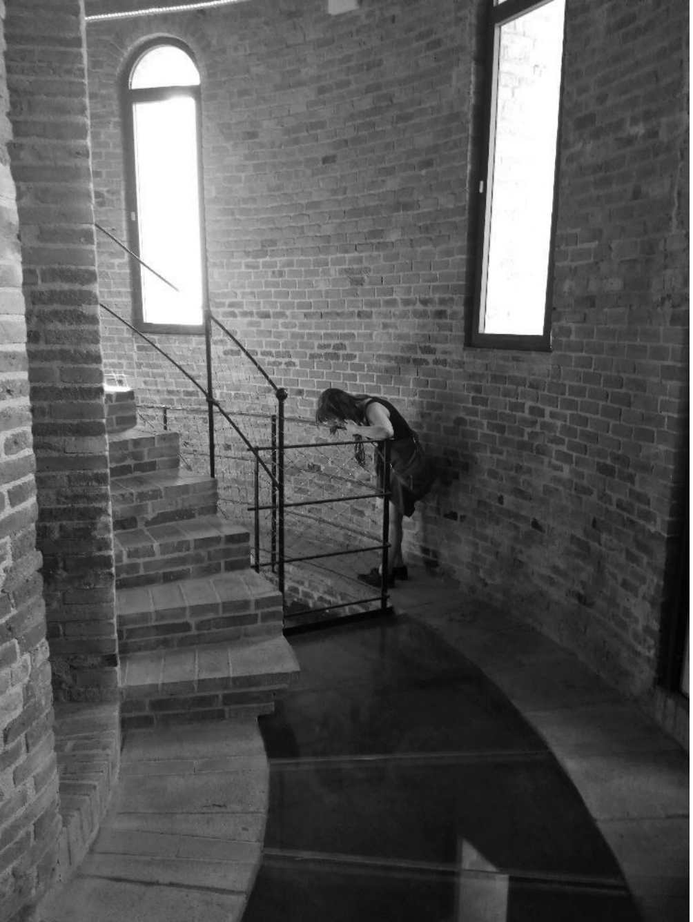
Fig. 2. Espai interior de la Torre de les Aigües.
