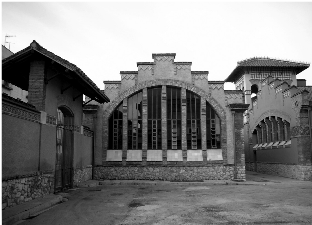
Imatge 2. Façana nord del pavelló d'administració i servei veterinari. (Jordi March, 2006.)
