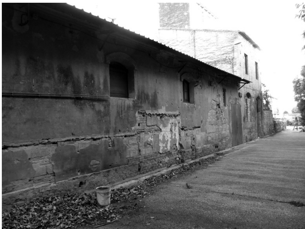
Exterior de les edificacions auxiliars. Fotografia de Didac Gordillo Bel.
