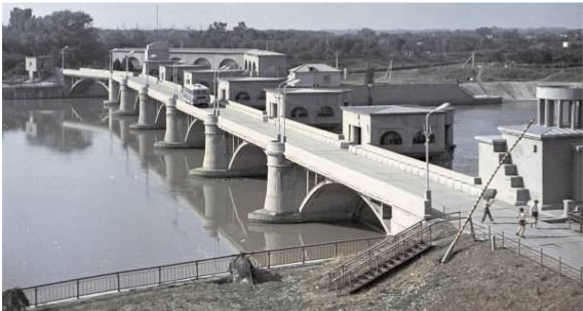
Головной водозаборный гидроузел на реке Кубань
