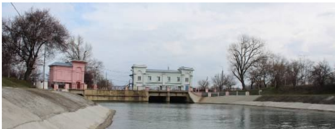
Новотроицкое водохранилище (вид на водосброс с верхнего бьефа)
