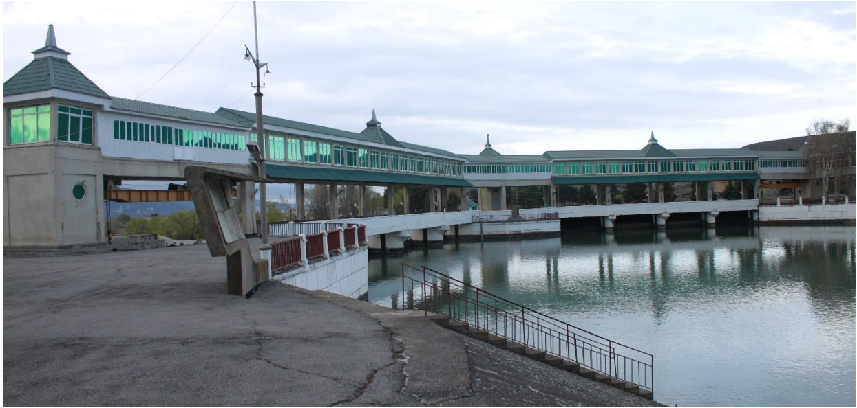
Головной водозаборный узел Большого Ставропольского канала
