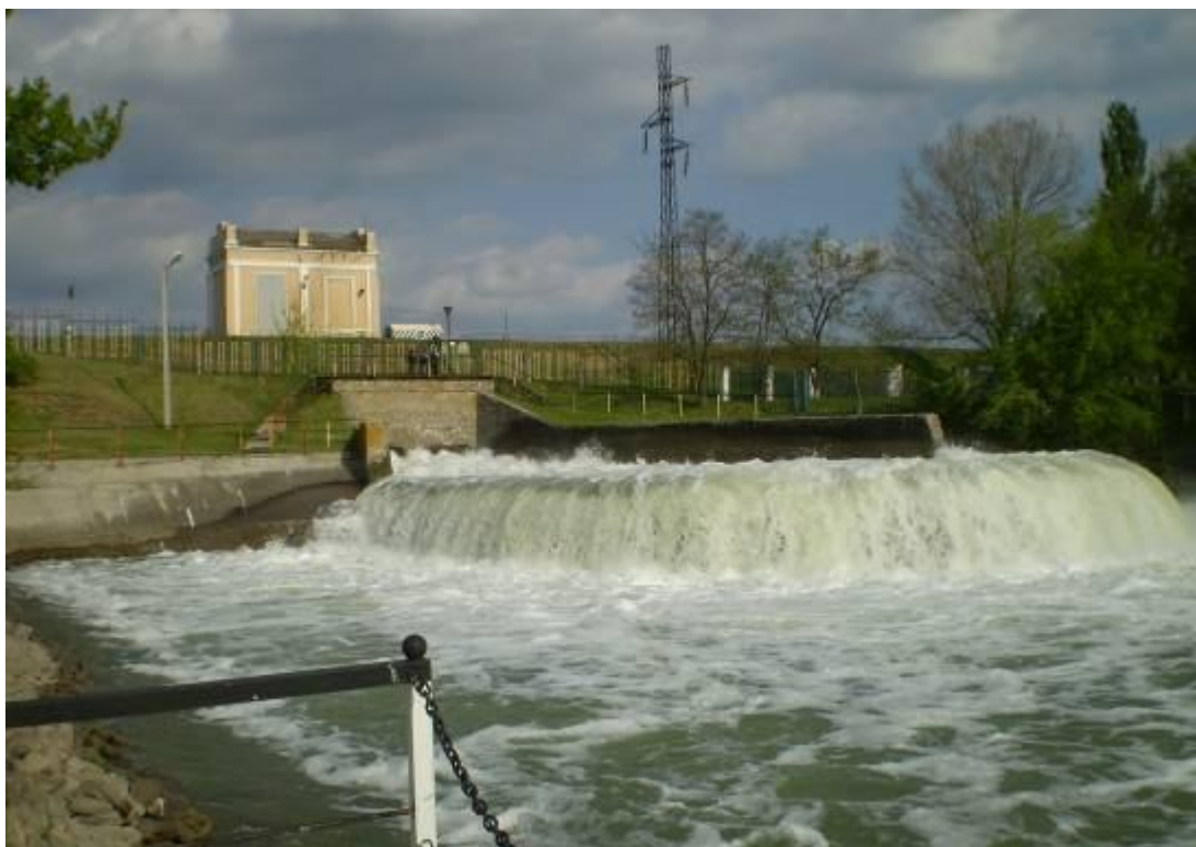
Водосбросное сооружение из Весёловского водохранилища в Ростовской области
