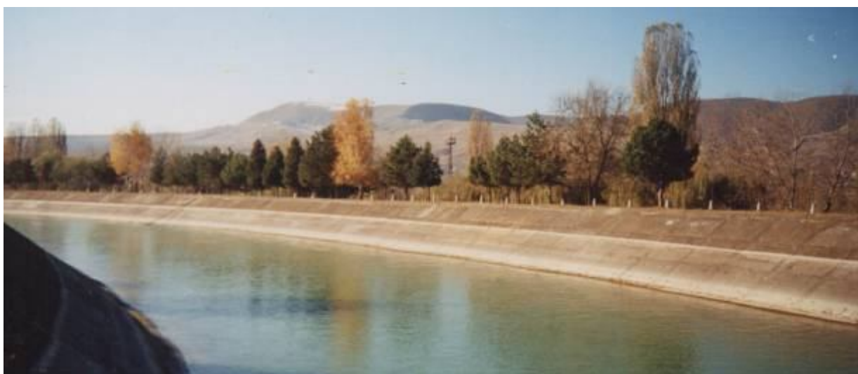
Облицованный участок Большого Ставропольского канала
