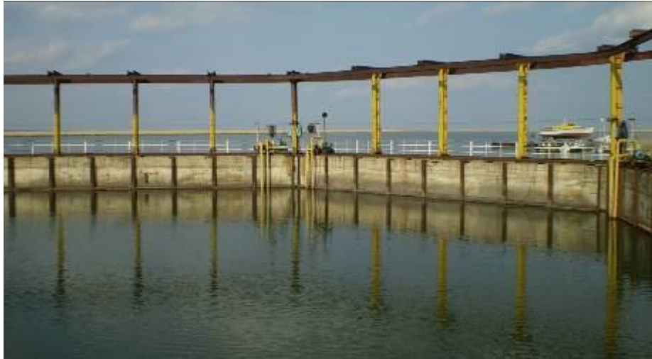
Водозаборное сооружение Азовского магистрального канала
