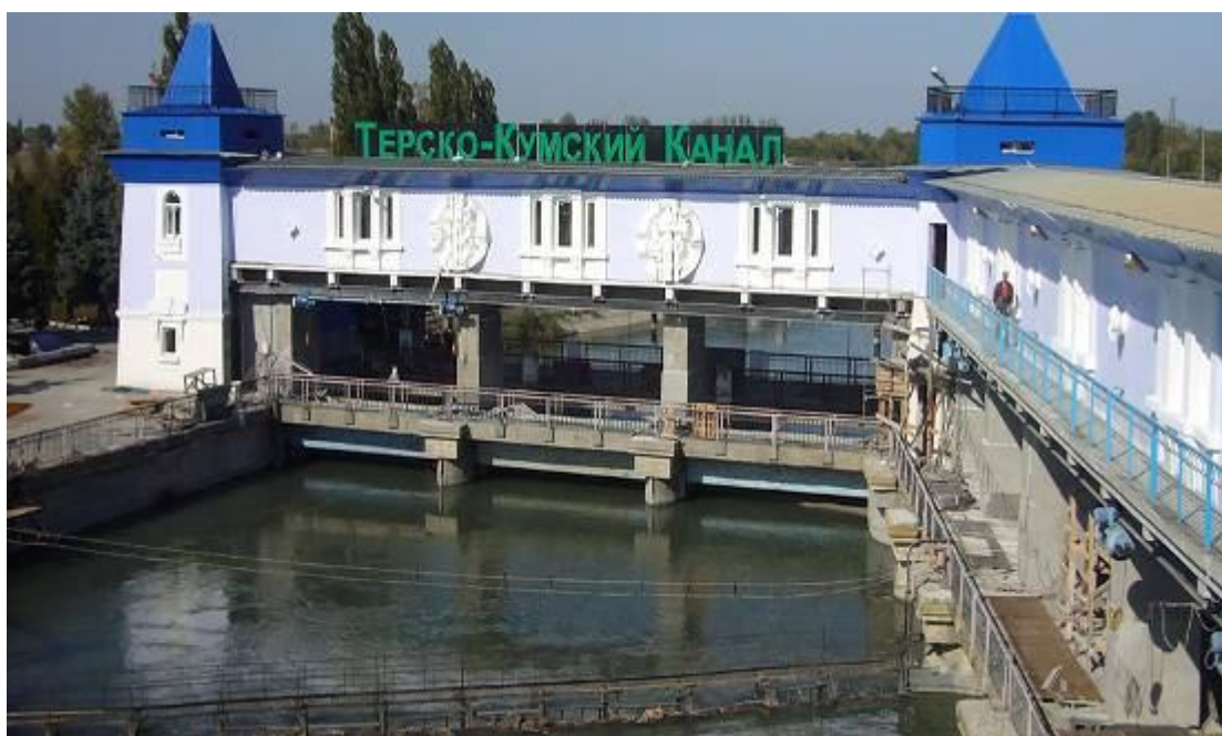
Сооружения Терско-Кумского гидроузла
