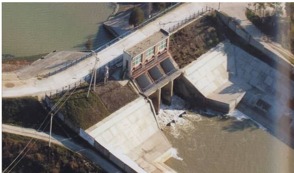
Водосбросное сооружение в составе водохранилищного гидроузла
