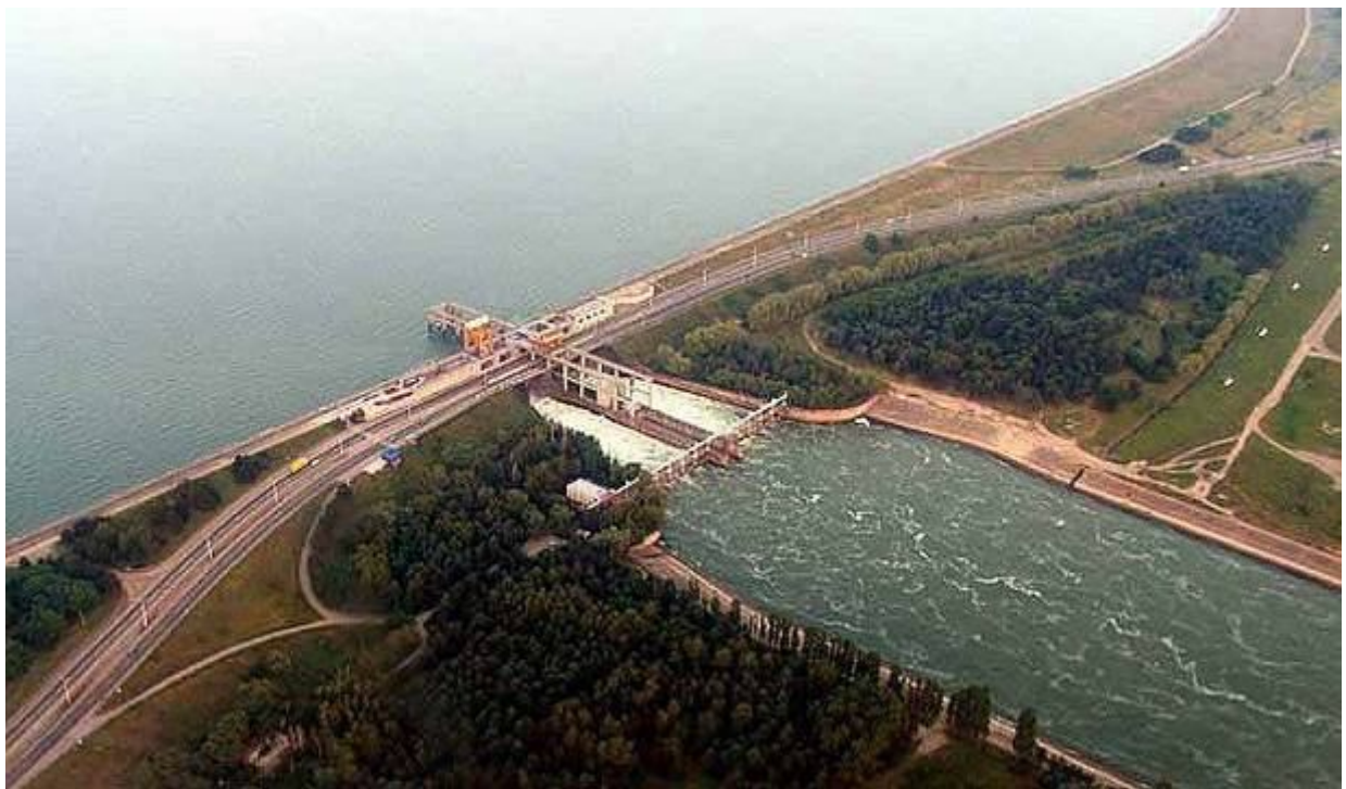
Водосбросное сооружение из Краснодарского водохранилища на реке Кубань
