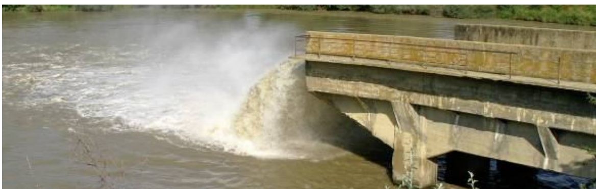
Консольный водосброс из Невинномысского канала
