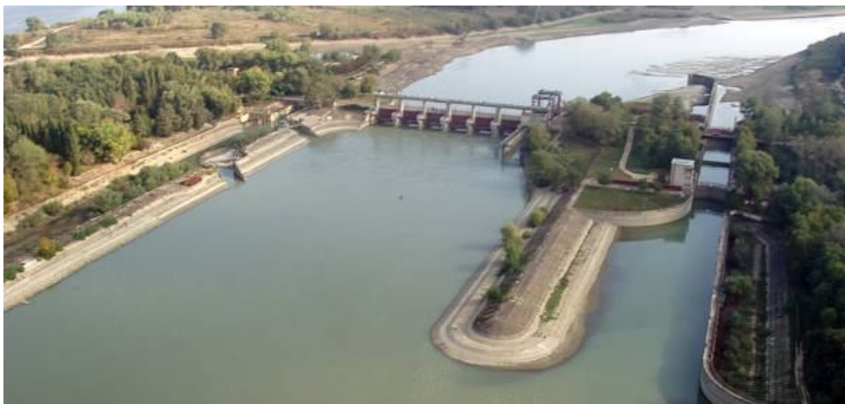
Фёдоровский гидроузел на реке Кубань
