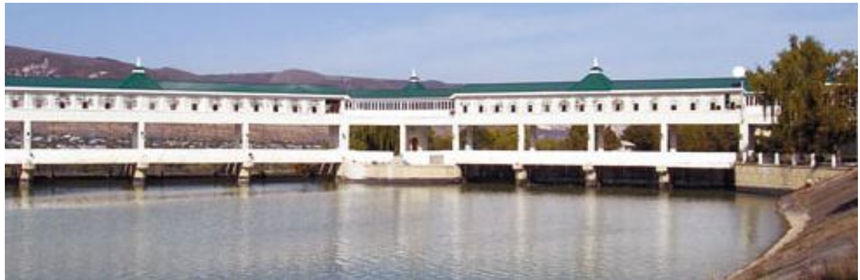
Усть-Джегутинский гидроузел (вид с верхнего бьефа)
