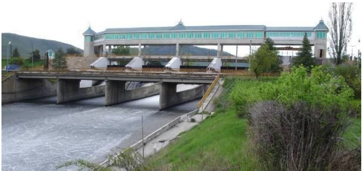
Усть-Джегутинский гидроузел (вид с нижнего бьефа)
