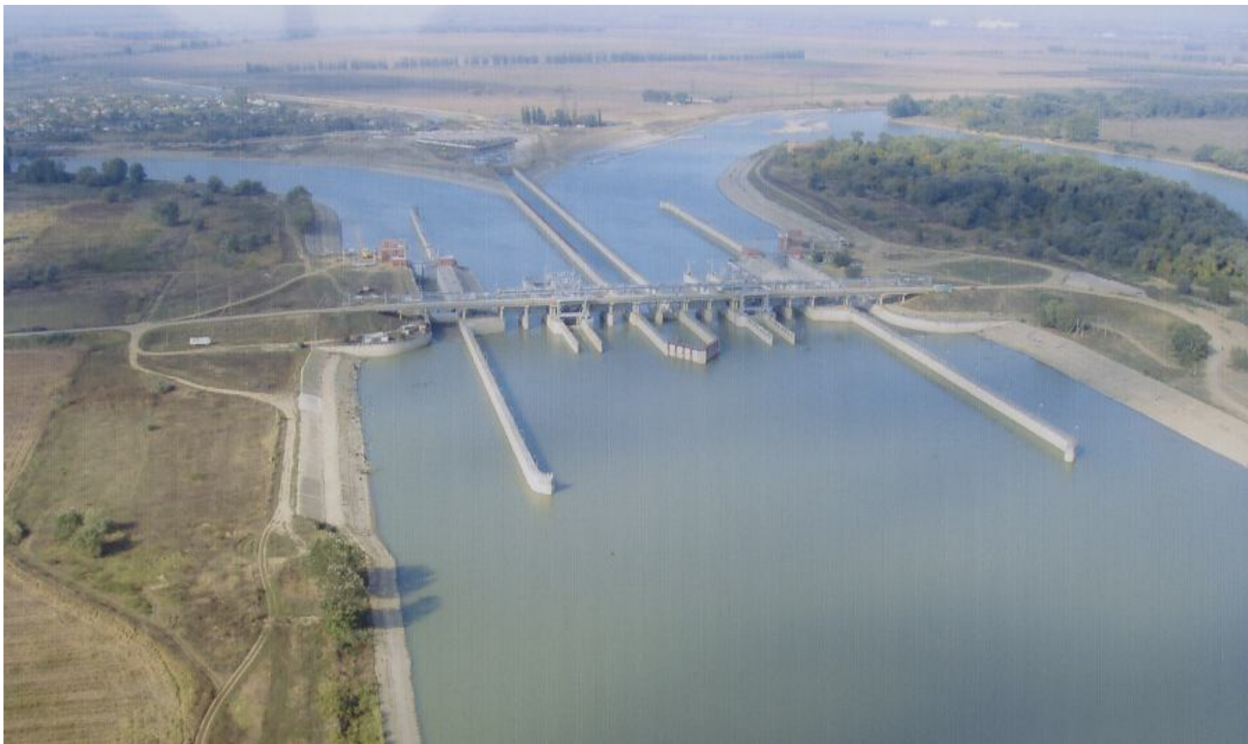
Тиховский гидроузел на реке Кубань
