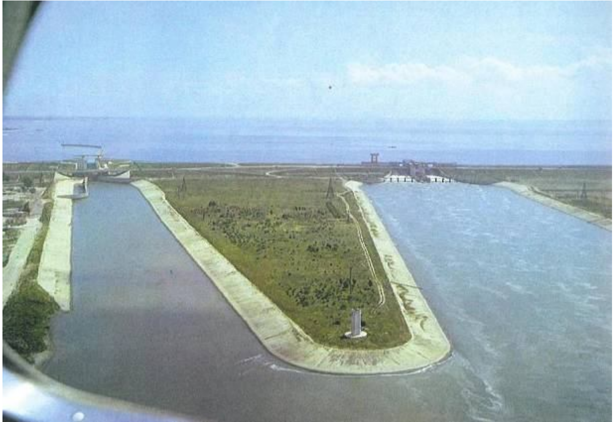
Общий вид Краснодарского гидроузла на реке Кубань
