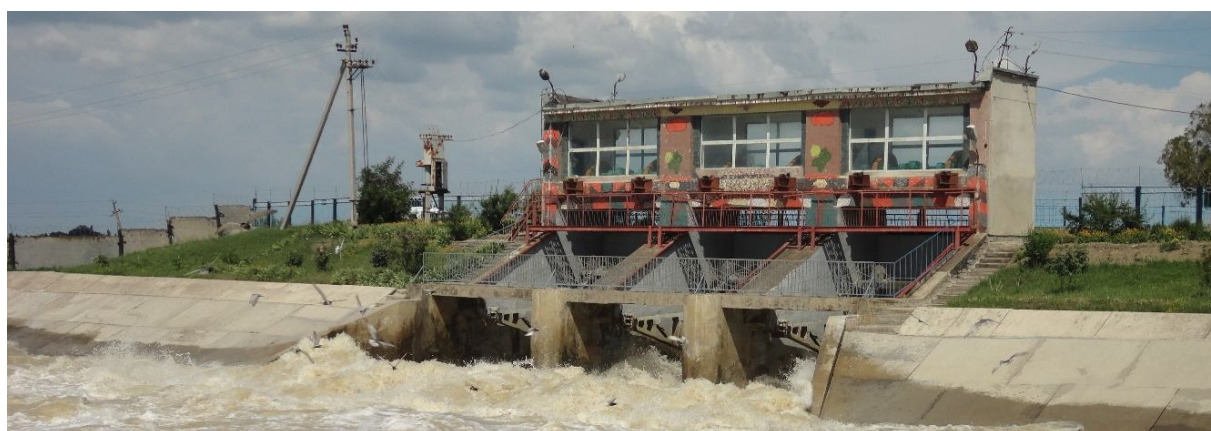
Водосбросное сооружение Варнавинского гидроузла
