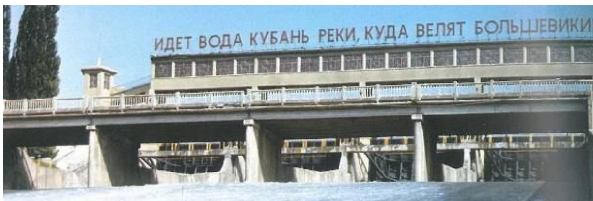
Водосбросное сооружение Усть-Джегутинского гидроузла
