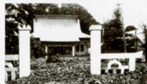
火山泥流・土石流(昭和6年神島寺付近の泥流被害)
