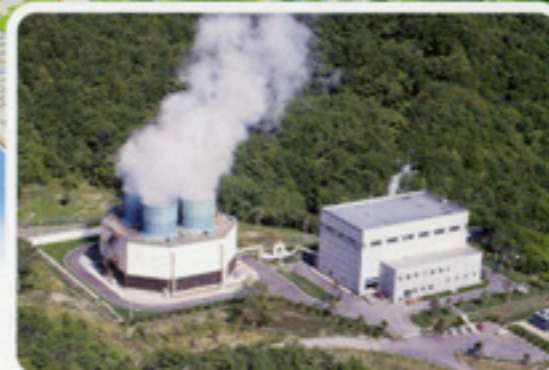
濁川地熱発電所
