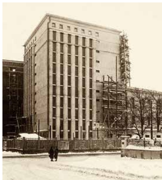
Здание АОР (башня «А») на Большой Пироговской улице в процессе строительства 1930-е
