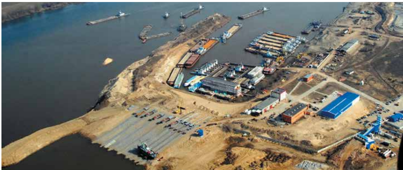
АО «Порт Коломна» 10 лет назад инвестировало средства в строительство слипа, способного поднимать суда весом 2000 тонн и длиной 115 м. Фото: www.portkolomna.ru
