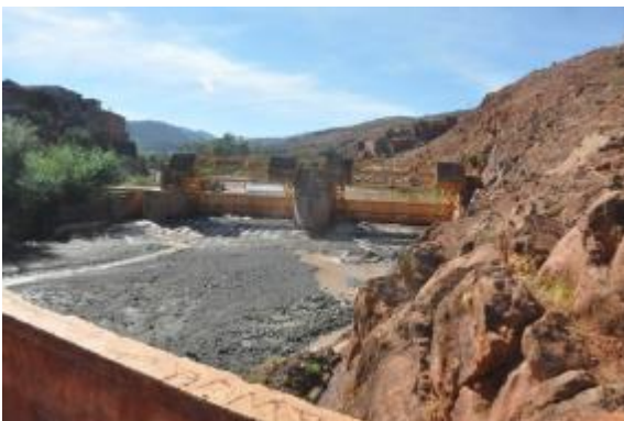
Photo 8 : Barrage de dérivation Bouhouta sur oued Rherhaya Source: AHT-RESING, 2014
