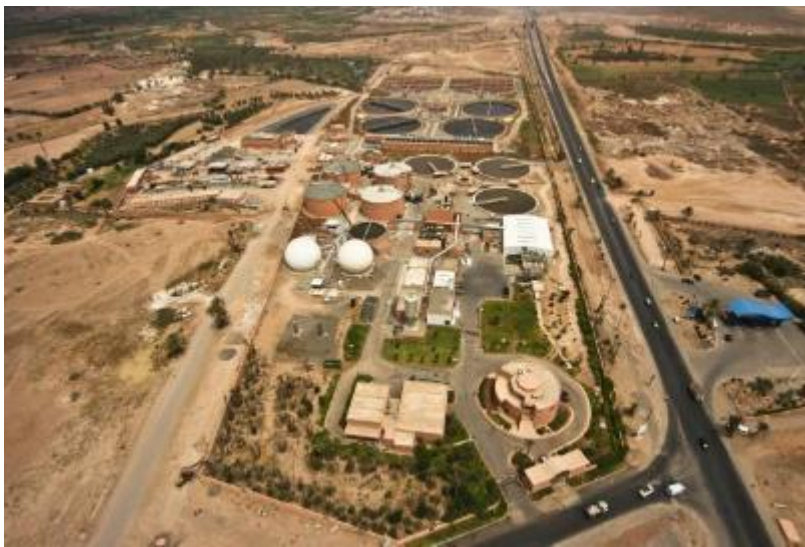
Photo 7 : Vue aérienne de la STEP de Marrakech Source: Présentation de la RADEEMA, 2012
