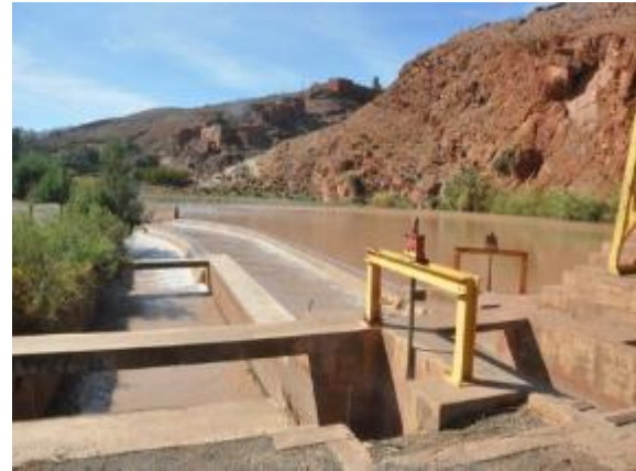
Photo 11 : Barrage Bouhouta, départs des seguias Bachia et Tagouramte
