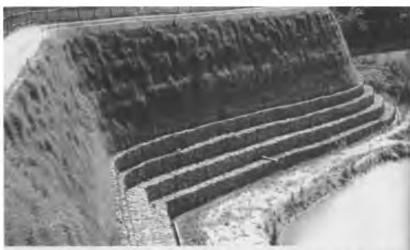
Слика 23 – Заштитно зеленило, каскадно уређење и подзид
