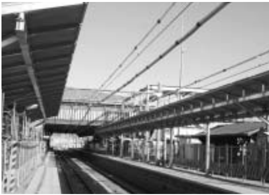
ホームに屋根をかける作業が進む竜王駅。
