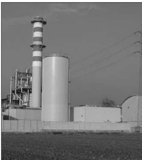
La centrale termica principale del teleriscaldamento
