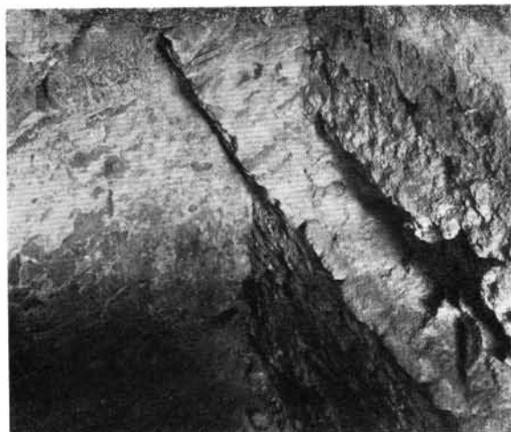
33. Másodlagosan bekötött boltváll a kápolnaszárny északi falában. 33. Gewölbesehle sekundärer Verbindung in der nördlichen Mauer des Kapellenflügels. 33. Retombe scellée ultérieurement dans le mur nord de l'aile de la chapelle. 33. Вторично подогнанная пята свода в северной стене часовенного крыла.
