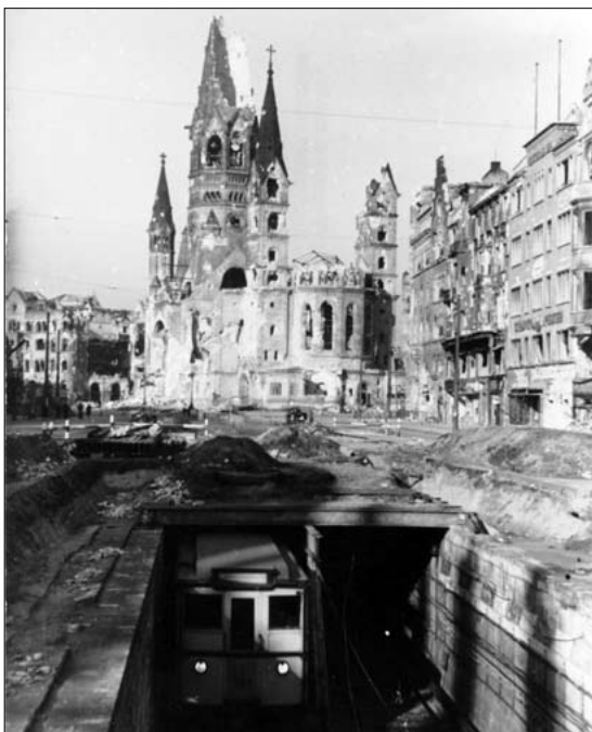
Ein im Zweiten Weltkrieg zerstörter U-Bahn-Schacht in der Berliner Tauentzienstraße. Im Hintergrund die zerstörte Kaiser-Wilhelm-Gedächtniskirche.
