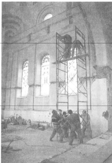
Роботи під час ремонту, травень 1997 року.
