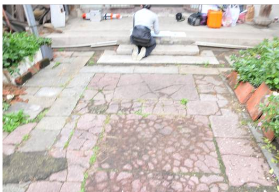
照片 2- 25 第三落天井
