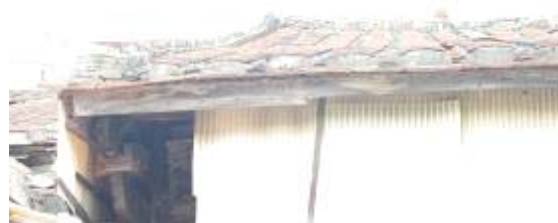
照片 2- 44 神明廳鋪設仰合瓦
