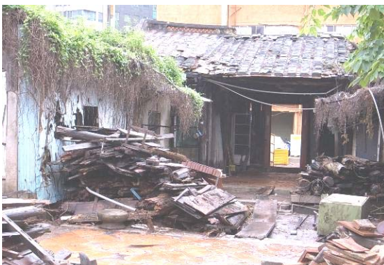
照片 2- 20 第一落與第二落天井
