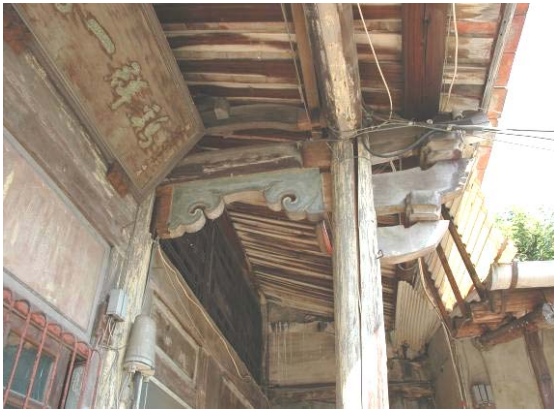
照片 2- 61 後落廳前步口構架
