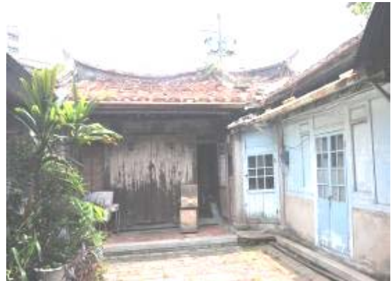
照片 2- 30 後看架地坪為斜鋪尺磚
