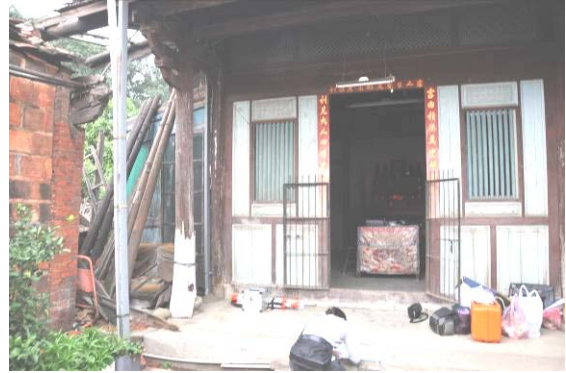
照片 2- 82 正面外牆木作隔屏
