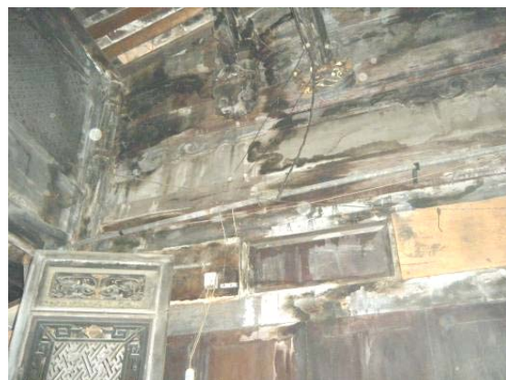
照片 3- 49 第二落神明廳構件有面狀水漬
