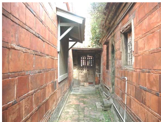
照片 2- 70 斗子砌外牆
