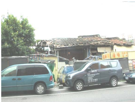
照片 3- 25 吉利第大門入口處有諸多雜物堆積
