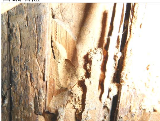
照片 3- 45 第二落檐柱遭蛀蟲危害，遺留粉末狀排遺
