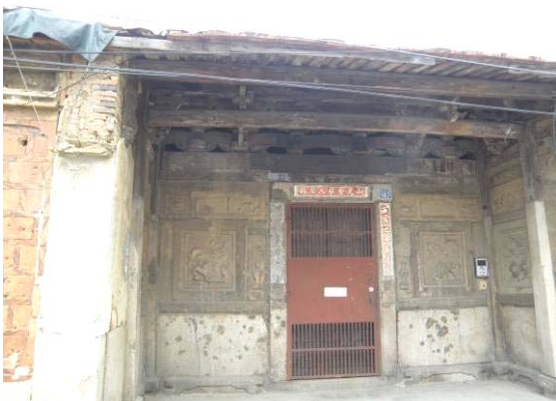
照片 2- 47 明間外牆為花崗石構造
