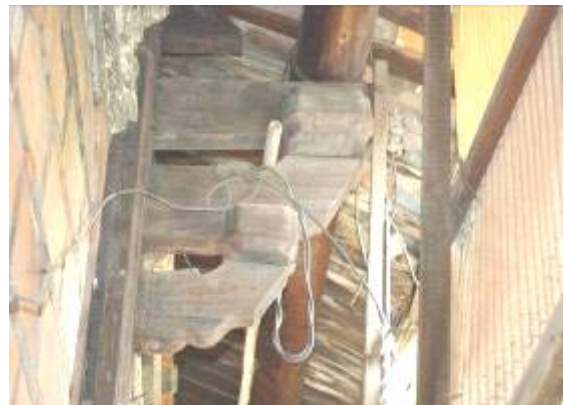
照片 2- 42 神明廳後步口構架
