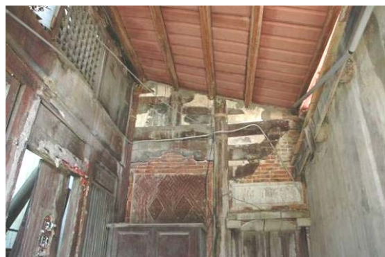
照片 2- 14 第二落巷頭處殘留木構架
