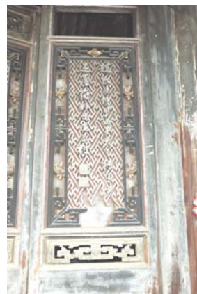
照片 3- 10 大廳版門彩繪剝落、木雕佚失且嚴重腐朽
