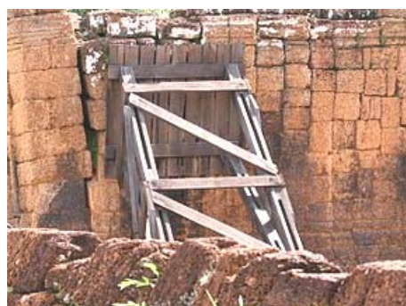
圖 5 牆面支撐示意
