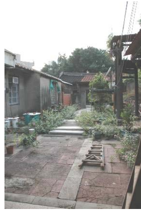
照片 3- 16 尺磚地坪縫隙雜草滋生
