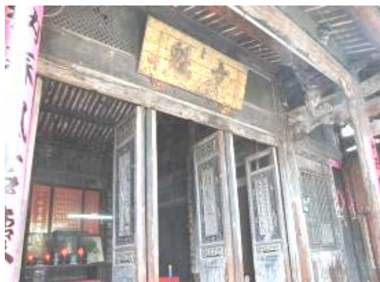
照片 2- 40 神明廳木作隔斷牆
