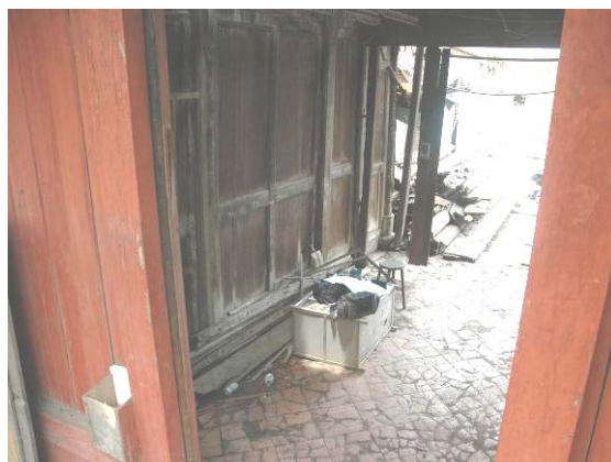
照片 2- 68 明間為尺磚地坪
