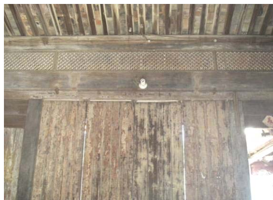
照片 2- 50 橫向隔斷牆為木隔板
