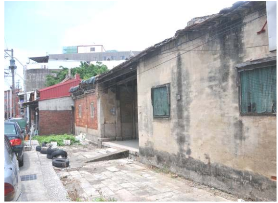
照片 2- 46 外埕地坪高埕較道路低
