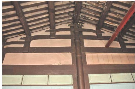
照片 2- 84 後落廳中架構架
