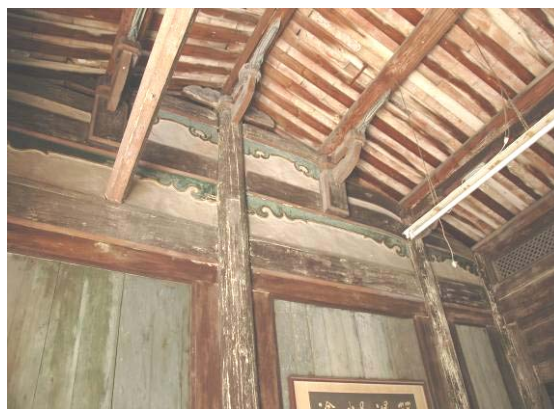
照片 2- 60 後落廳縱向牆身作法
