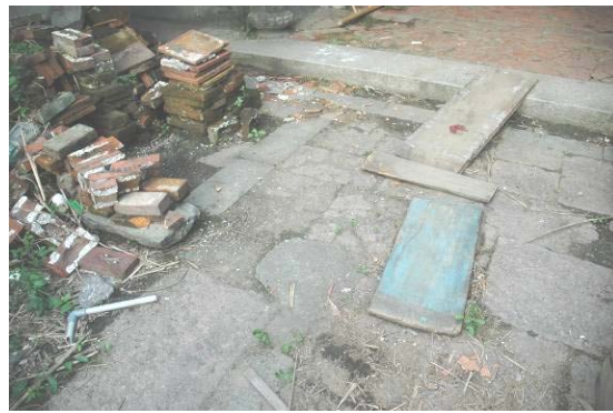
照片 2- 76 天井的花崗石條鋪面
