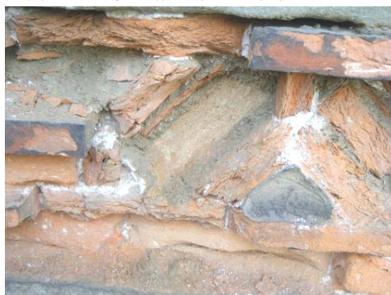
照片 3- 60 第一落前檐牆紅磚風化深度達 1/3
