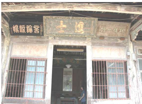
照片 2- 59 後落廳橫向牆面作木作隔屏
