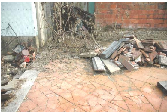
照片 2- 75 第二落清理後的尺磚地坪
