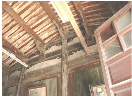
照片 2- 62 後落廳中架構架
