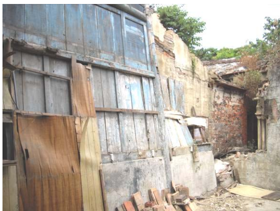
照片 2- 69 右梢間木作外牆傾倒
