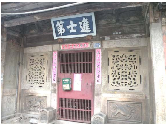
照片 3- 5 花崗石牆身構造現況良好
