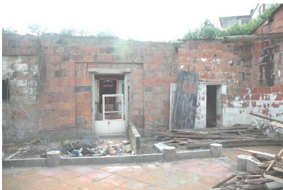
照片 2- 77 第二落僅餘柱珠與牆基位置
