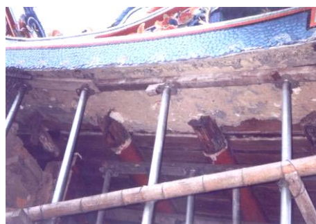
圖 6 屋面支撐建議可以木質材料作為本體與支撐間的防護
