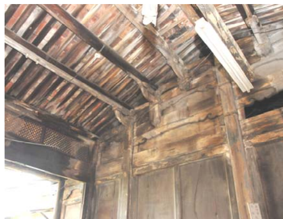
照片 3- 32 大廳前房檐口構架仍留存
