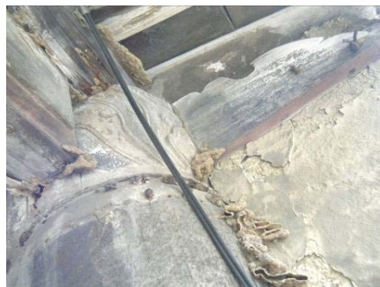
照片 3- 44 於第一落發現之白蟻分飛孔（圓圈處）
