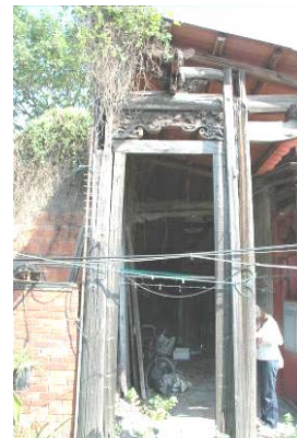
照片 2- 56 大廳僅存部分木構架
