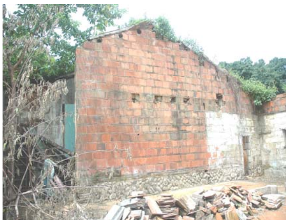
照片 3- 29 斗子砌牆身保留桁洞位置
