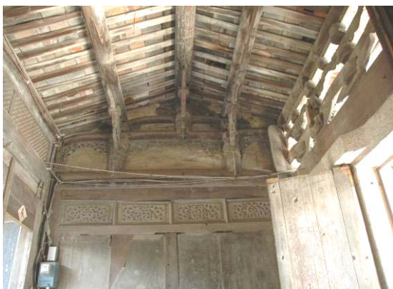
照片 2- 49 縱向隔斷牆作編竹夾泥牆
