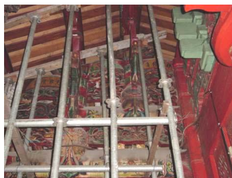
圖 4 原則以框架系統支撐
