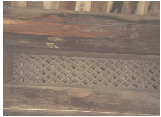
照片 2- 64 在桁與通梁間以花格窗填實
