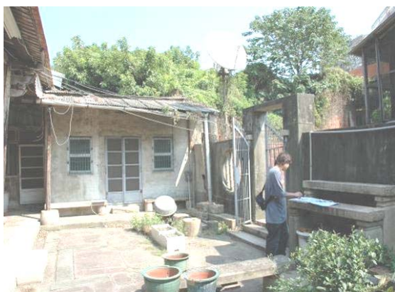
照片 2- 57 外埤地坪為「紅普石」作法
