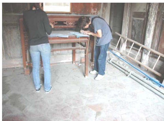
照片 2- 58 內部地坪鋪設六角形尺磚
