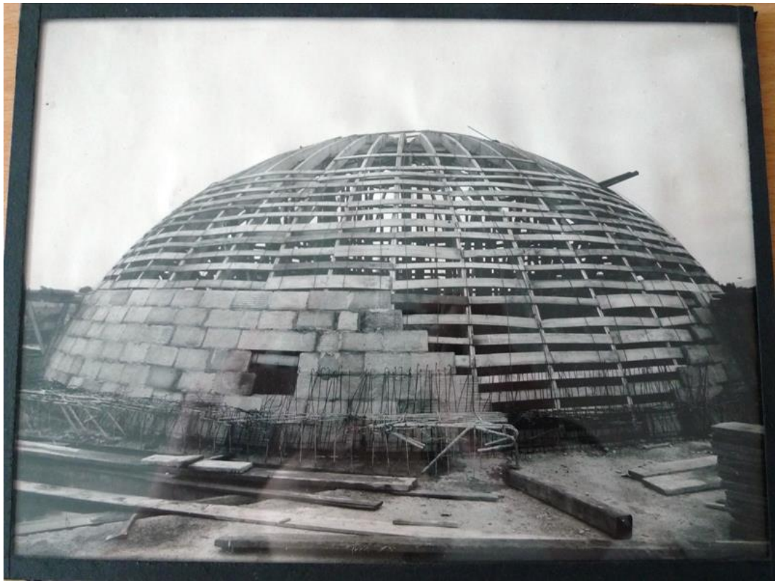
Obr. 19: Stavba kupoly (Štátny archív v Žiline, fond Ing. Žigmund Vavrín (Wertheimer), škatuľa 6, č. 18).
