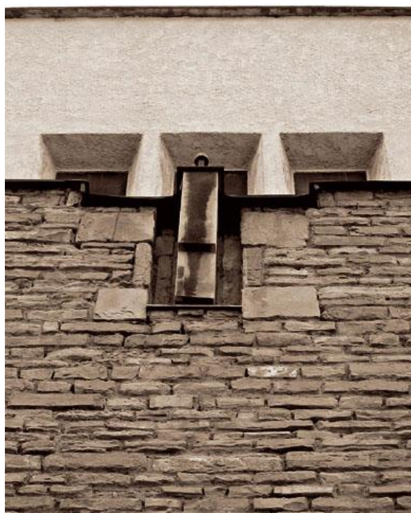
Obr. 32: Detail klinového prvku (Kvasnicová, Magdaléna, Synagóga, Hurbanova 11, Žilina. Architektonicko – historický výskum . Bratislava, 2011).
