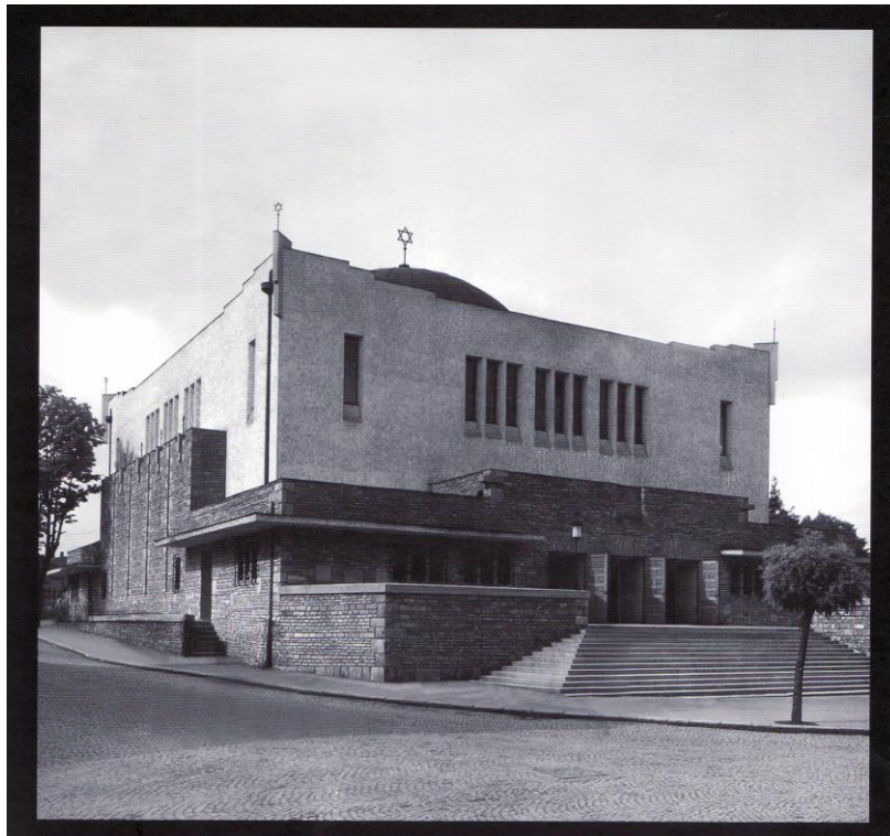
Obr. 27: Pohľad na hlavný vstup a východnú stranu (Kvasnicová, Magdaléna, Synagóga, Hurbanova 11, Žilina. Architektonicko – historický výskum . Bratislava, 2011).
