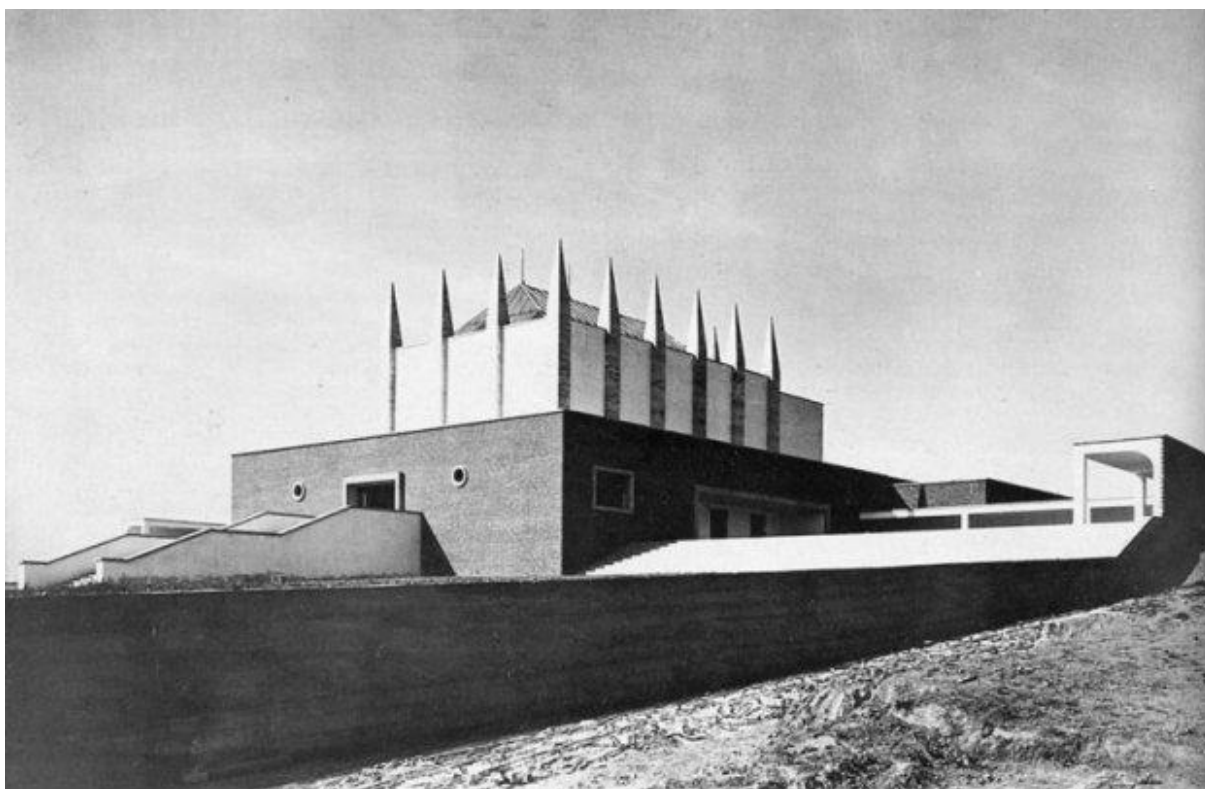
Obr. 51: Krematórium v Brne – bočný pohľad na hlavný vstup (www.bam.brno.cz).
