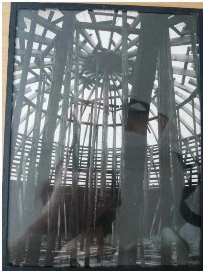
Obr. 17: Stavba kupoly (Štátny archív v Žiline, fond Ing. Žigmund Vavrín (Wertheimer), škatuľa 6, č. 18).
