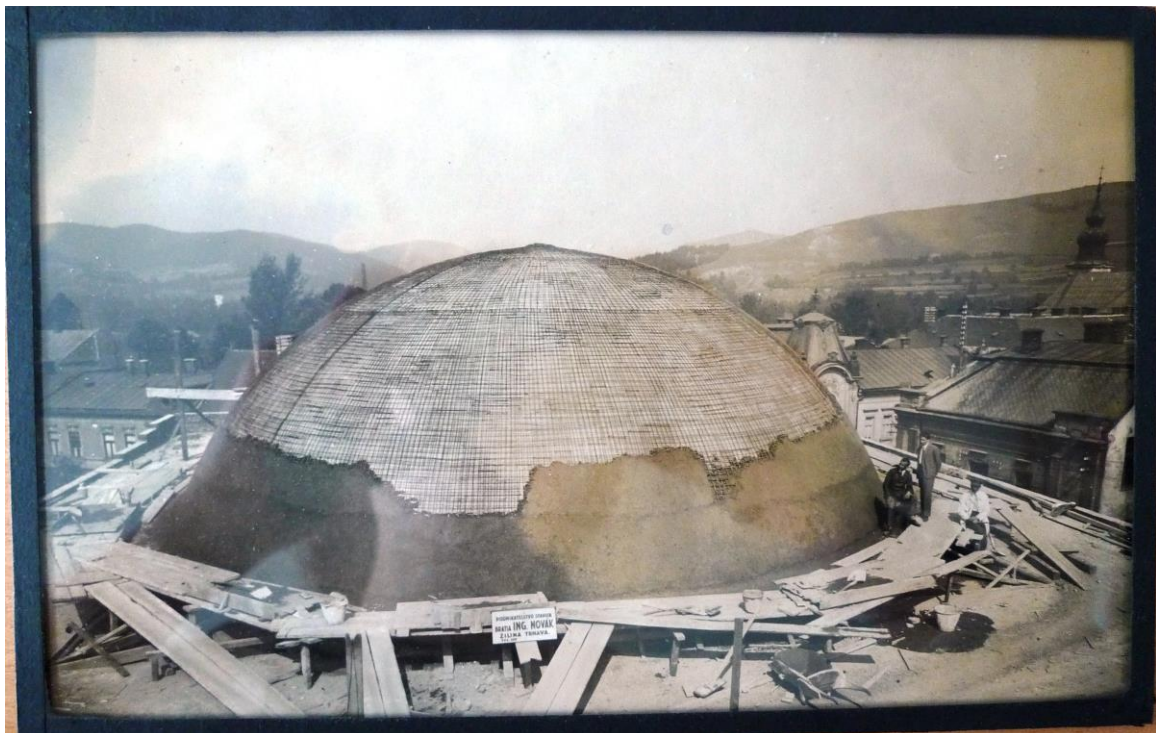
Obr. 19: Stavba kupoly (Štátny archív v Žiline, fond Ing. Žigmund Vavrín (Wertheimer), škatuľa 6, č. 18).
