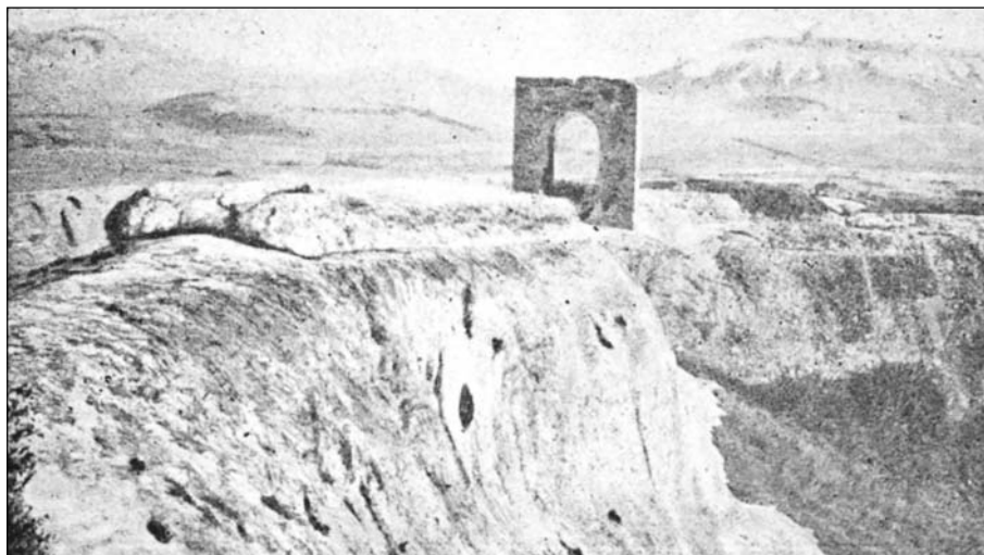
Рис. 45. Башня Кыз-Кулле, вид с юга
