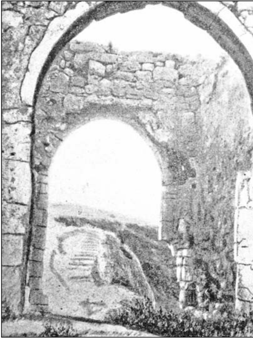
Рис. 47. Внутренность башни, вид с севера
