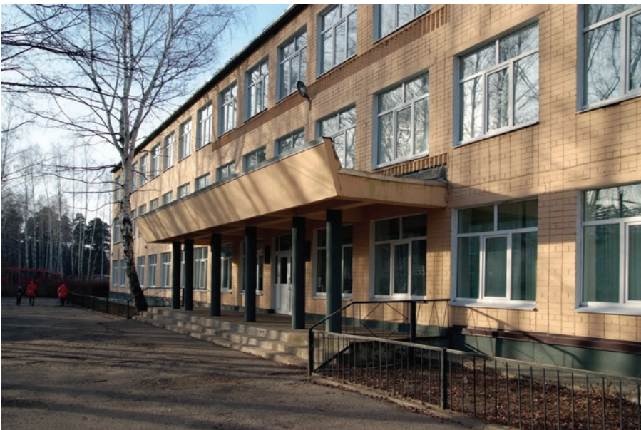
Здание Ново-Юдинской школы
