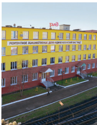
Локомотивное депо станции Юдино
