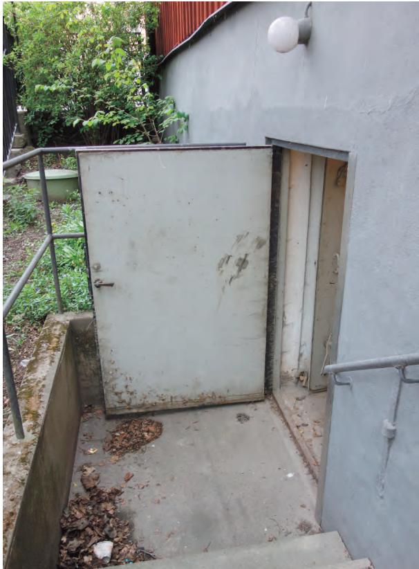
Källarentré på södra sidan mot Kärleksparken. Källardörren är mycket bred, monterad i en stälkarm och troligen från 1970-tal.
