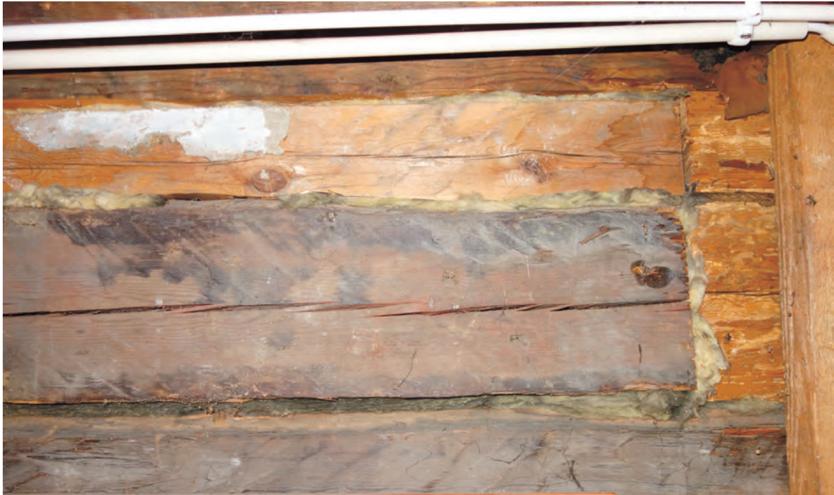
Timmerlagningar utförda 1971 där vissa stockar bytts och drevats med gullfiberisolering.
