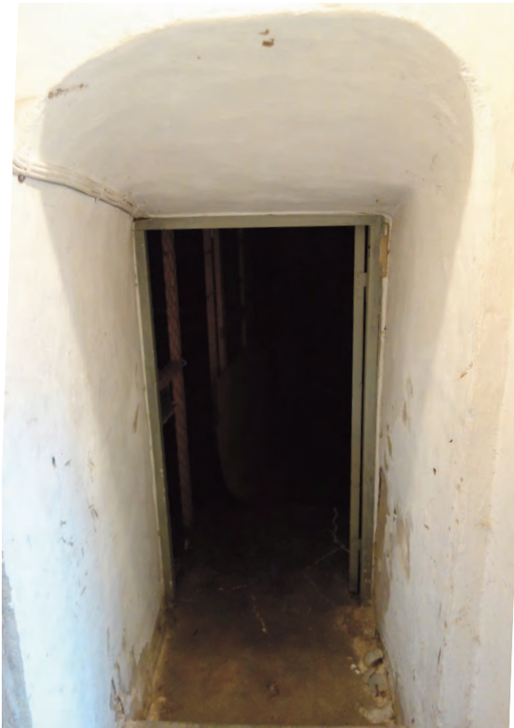
Passagen ned till den äldre källaren har en välvd, putsad ovandel. Två steg leder ned till källaren som tros vara från 1600-talets början.
