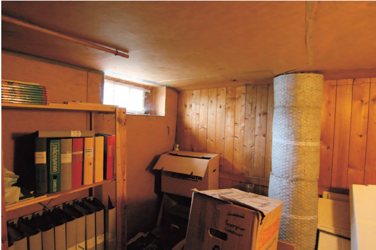
Förrådsrum på vinden mot nordväst. Rummet är klätt med träpanel och delvis av masonit. Delar av träpanelen är från tiden kring 1900.
