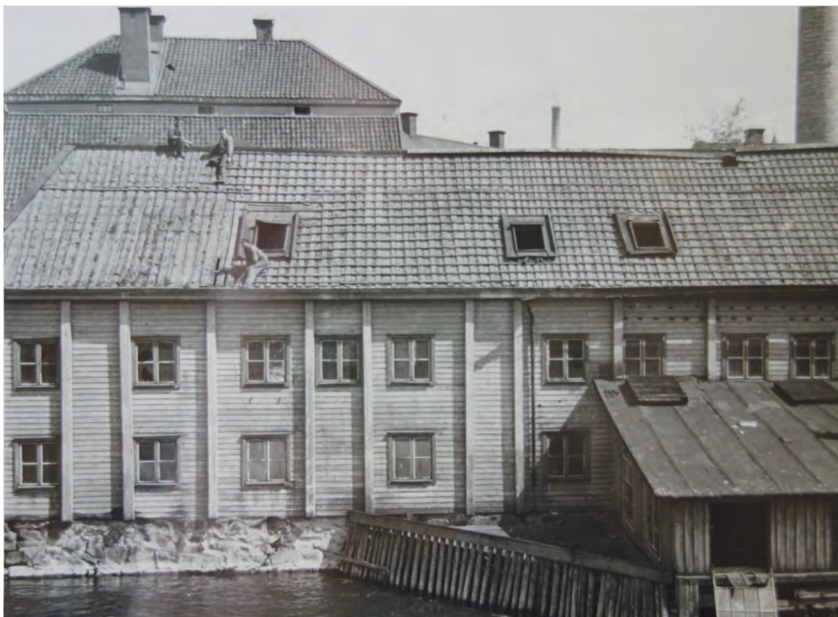
Vid rivningen demonterades byggnaderna och taktegel och fönster verkar ha sparats. Här syns tre män på taket som har plockat ned tegel och nu demonterar bärläkt. Foto av Kurt von Schmalensee 1932. Från Norrköpings stadsarkiv.
