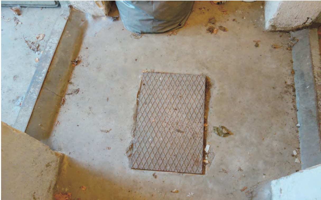
Källarens golv består i sin helhet av cement med karmar av stål och cement från skyddsrumsuppförande.
