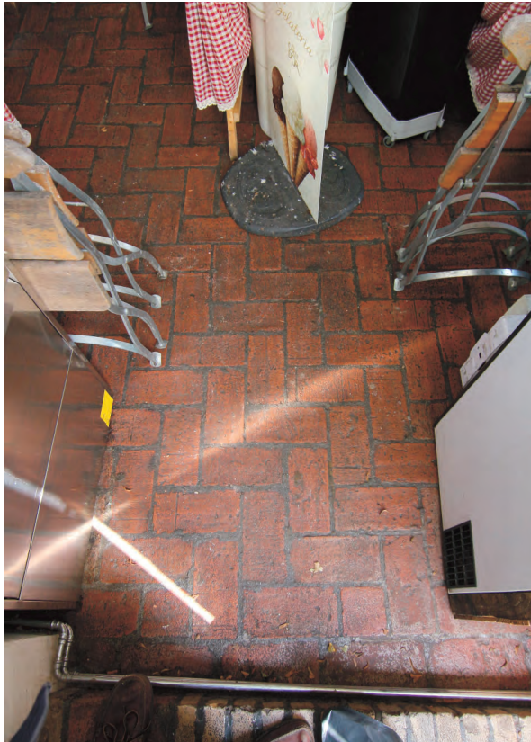
Fiskbenslagt tegelgolv i byggnadens västra, större rum. Utgör golv i större delen av byggnaden.
