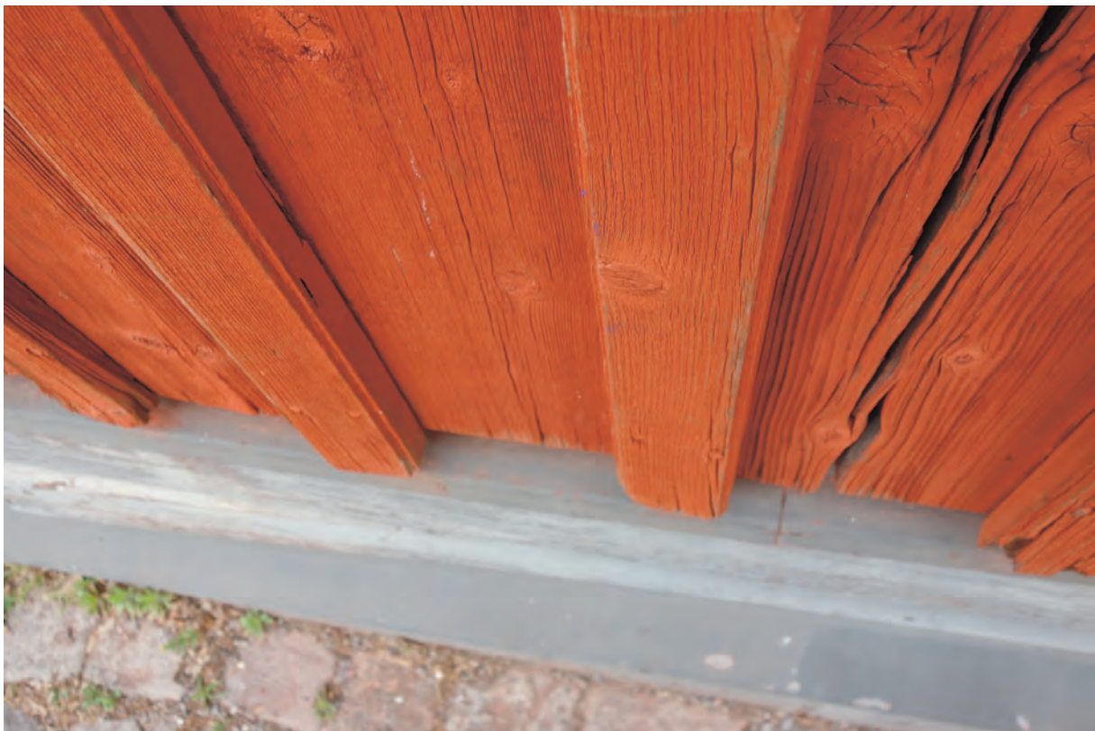
Panel med locklister som har hälkälslyvlade kanter.
