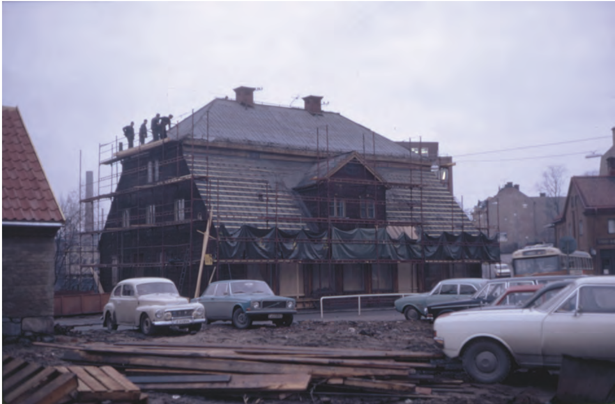
Mjölaren 14 nyttjad som parkeringsplats strax efter rivningarna av tomtens bebyggelse. I bakgrunden syns Bergslagsgårdens renovering under 1971. Foto från Norrköpings stadsmuseums fotoarkiv.
