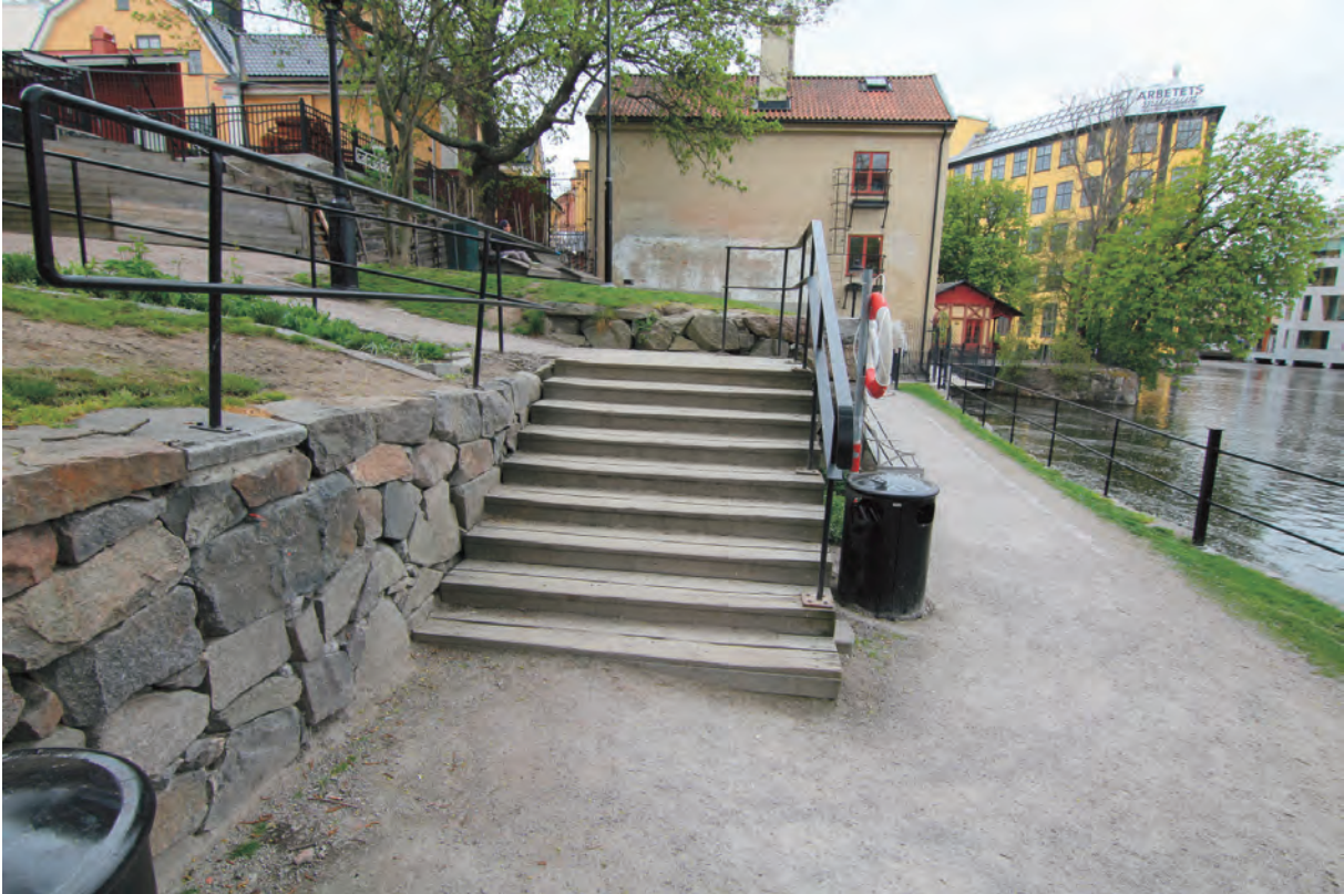
Trätrappa sammanlänkar parkens två olika nivåer. Trappan har en plåtsida som förhindrar att någon vistas under den.
