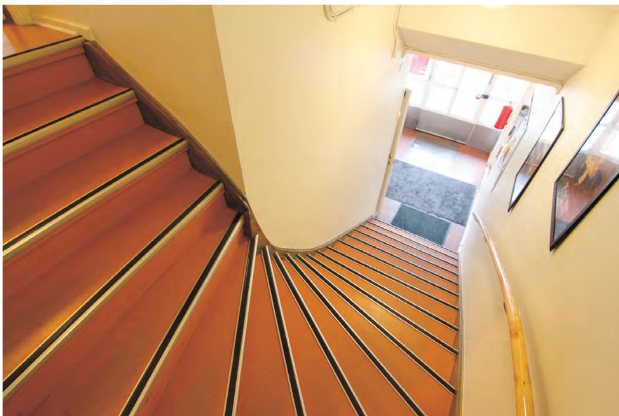
Trappans utformning ändrades 1932 och fick en tvär sväng mot norr. Handledare, trappa och vangstycken är från ombyggnationen av Kooperativa förbundet. Mattäckning och steglister är tillagda senare.
