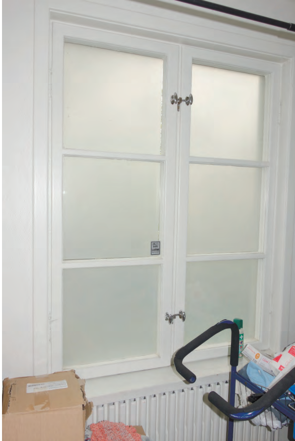
Fönster invändigt i byggnaden. Dessa är inåtgående med beslag från tidigt 1900-tal.
