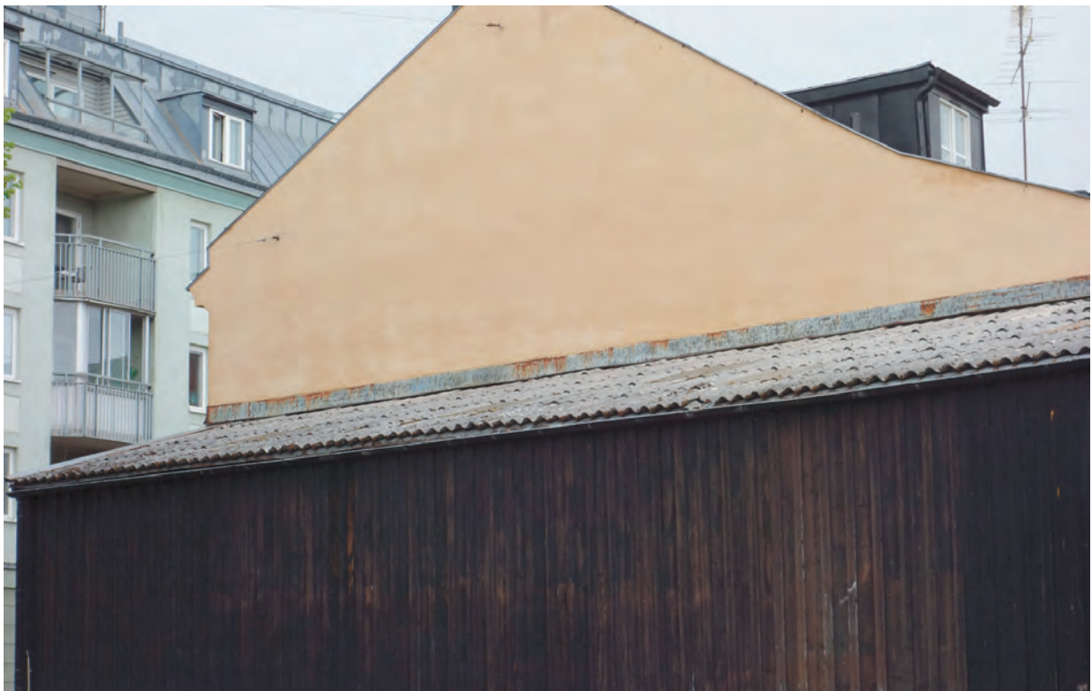
Husets tak är belagt med korrugerade eternitplattor och tätat mot den putsade väggen med galvaniserad plåt.
