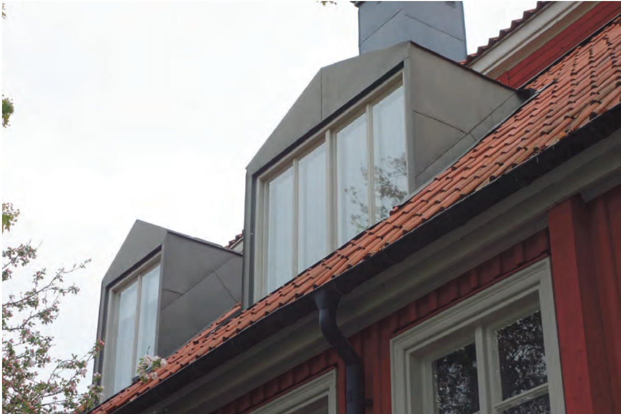
Takkupor av plåt mot söder. Dessa är uppförda med innåtgående bågar och spanjolett. Troligen uppförda under tidigt 1900-tal.
