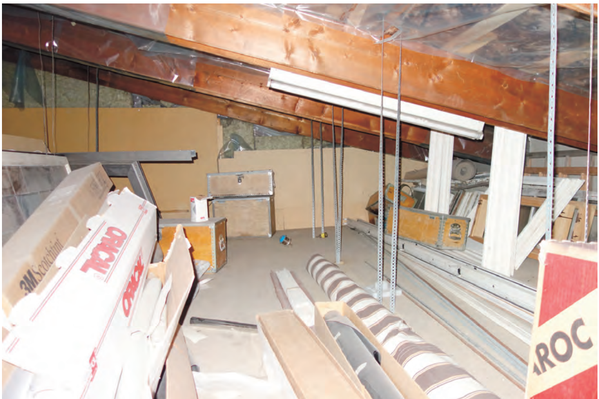
Entresolplan mot söder, låg, knappt beträddbar yta, används för förvaring. Väggar och golv belagda med spånskivor. Takstolar av grova reglar.
