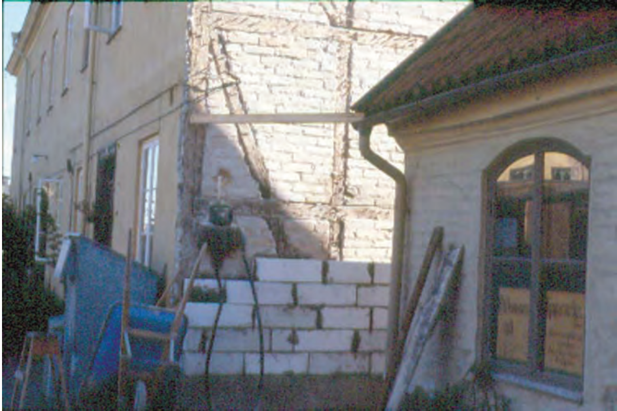
Gavelsidan mellan Sista supen och bostadsbuset på Västgötegatan 28 tilläggsisolerar med lättbetongstenar 1979. Byggnadens fasad avtäcktes helt inför ombyggnationen. I förgrunden syns sista supen. Foto från Norrköpings stadsmuseum.
