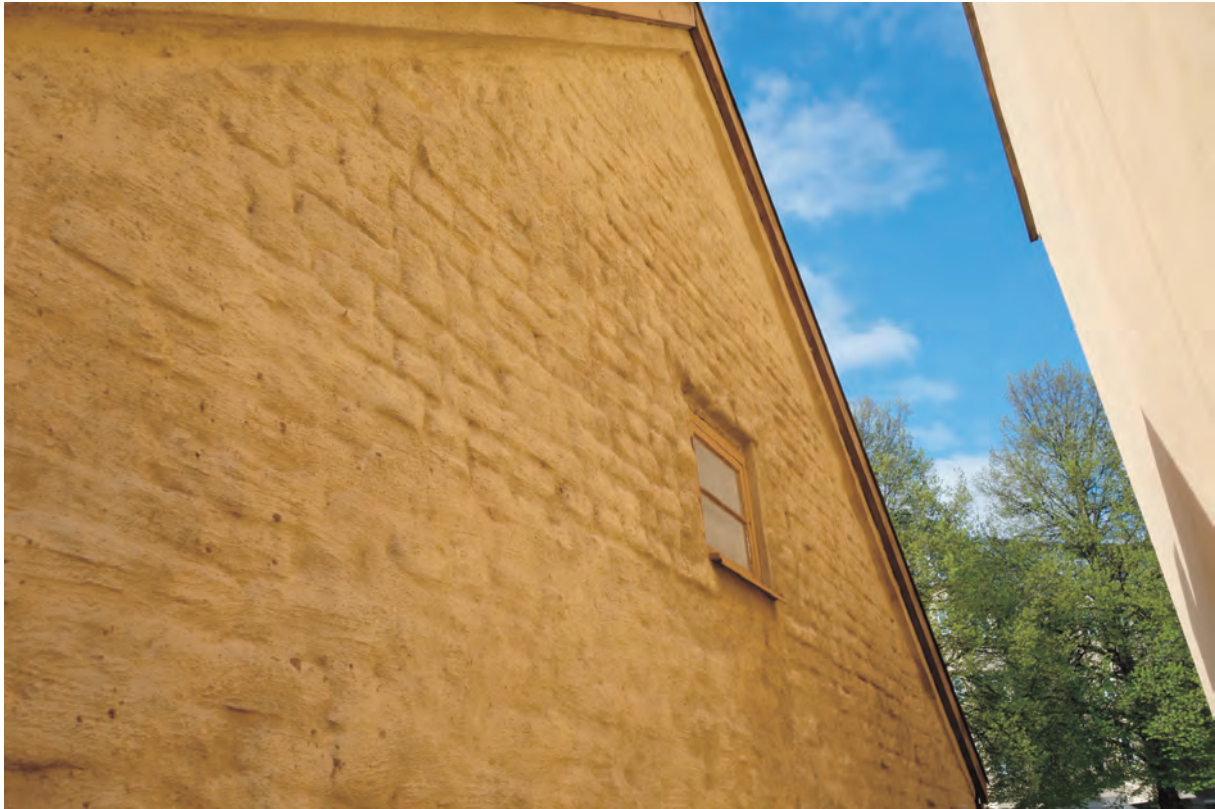
Gavelsida mot öst, nära motstående byggnad. Denna mindre fönsterbåge är den enda som inte är rödmålad.
