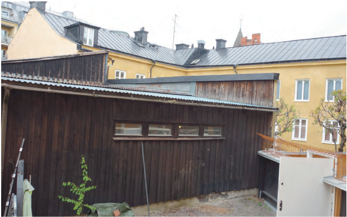
Husdelen som byggdes ut mot söder 1974. Denna byggdes mot ett redan befintligt plank mot angränsande fastighet. Skarven mellan äldre byggnad och det som uppfördes 1974 syns som en grå yta till vänster och stående plankvägg till höger.
