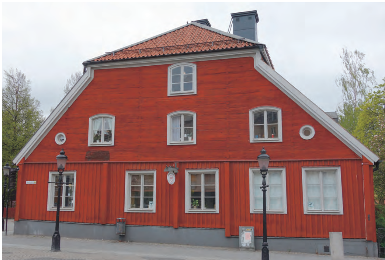
Gavelsida mot väst. Takets valmade del, bred grå sockel, knutbrüdor på bottenplan och synliga släta knutar från intimrade mellanväggar på plan två.
