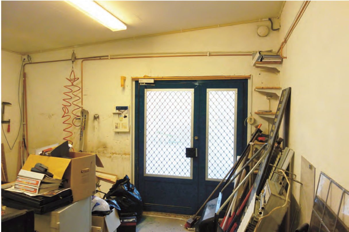
Verkstadsdelen mot söder, tillbyggd 1974. Väggar och tak är klädda med gips. Entréporten är av senare datum.
