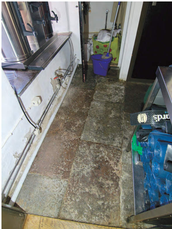
Rum till öster ligger ett steg upp och golvet är belagt med kalksten. Även fönsterbräddor är belagda med kalksten, men av senare tillverkning.
