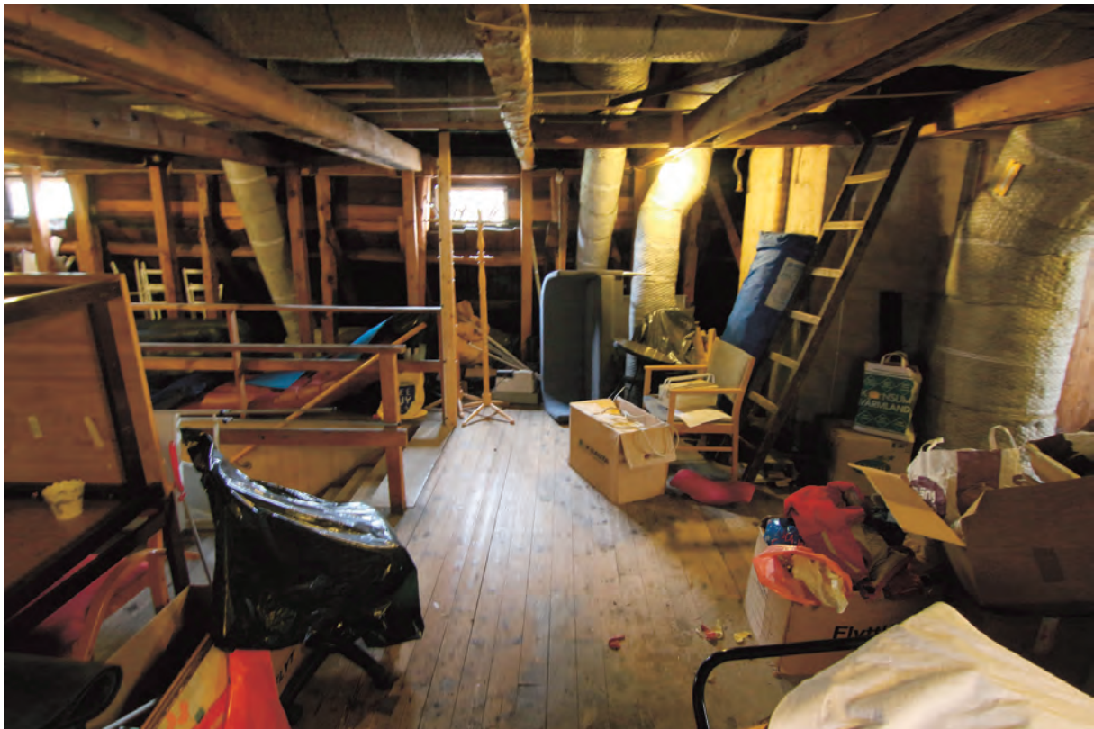
Vinden sedd mot söder. Små fönster i mitten och till vänster är placerade i italianen och också av betydande ålder. Ventilationsdragningar i byggnaden är väl synliga på vinden.
