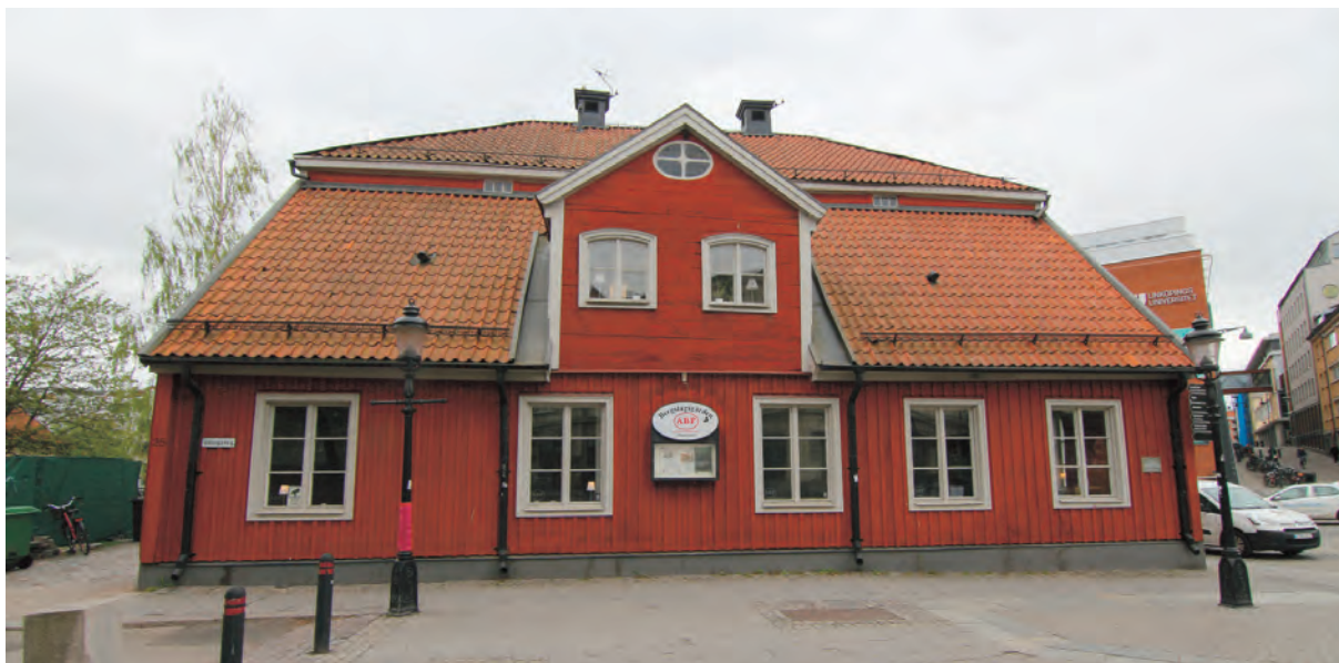
Bergslagsgården sedd från norr. Huset är uppfört på en förböjd grund som motgjutits med betong. Bottenplan är täckt av röd locklistpanel och i hörnen finns knutlådor. Taket är brutet med ett nedre sadeltak och ett övre valmat tak. Små fönster finns i förhöjningen (italianen) i säteritaket.
