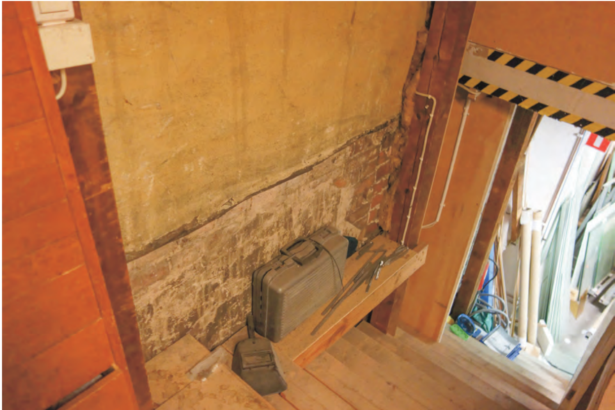
Entresolplan/övervåning sedd nedför trappa. Även här syns äldre övergång mellan puts och naket tegel, samt äldre våd av tjärad papp. Ett tydligt tecken på var äldre byggnad stått.
