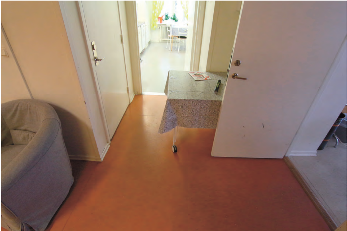
Röd-orange plastmatta på golv. Rumsindelning från 1930-talet är fortsatt rådande, men vissa ändringar har gjorts för att återgå till en äldre utformning med fler rum.
