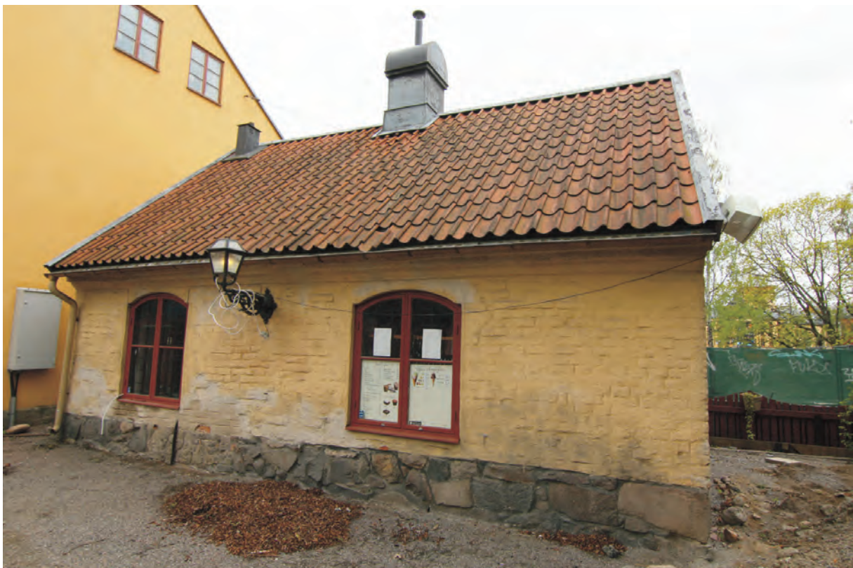
Byggnadens norra långsida, även här med frilagd sockel av natursten och tunn puts. Dock har denna sida en putsad, listdragen gesims mot takfoten.
