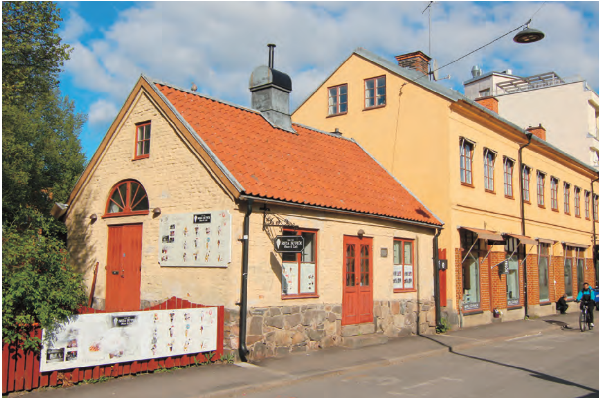
Byggnaden sedd mot nordöst från Västgötegatan.
