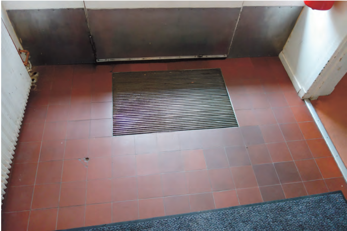
Entrén mot innergården har klinkerbelagt golv och försänkt skrapgaller. Bakom syns entrépartiets sparkeplåt. Trots ändrade ytskikt är entréhallens form bevarad.
