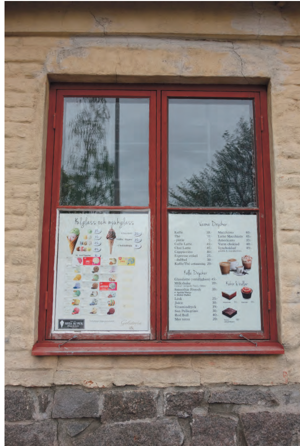
Fönster mot västgötegatan, två lyfter med vardera en horisontellt avdelande spröjs.
