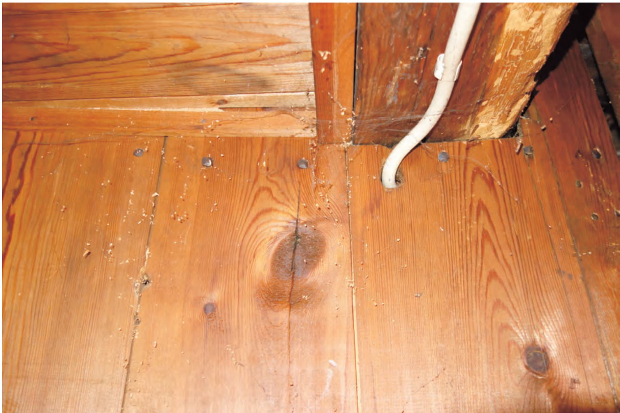
Träpanel från tiden kring sekelskiftet 1900 som är fäst med klippspik. Troligen har små vindskontor varit inredda här.
