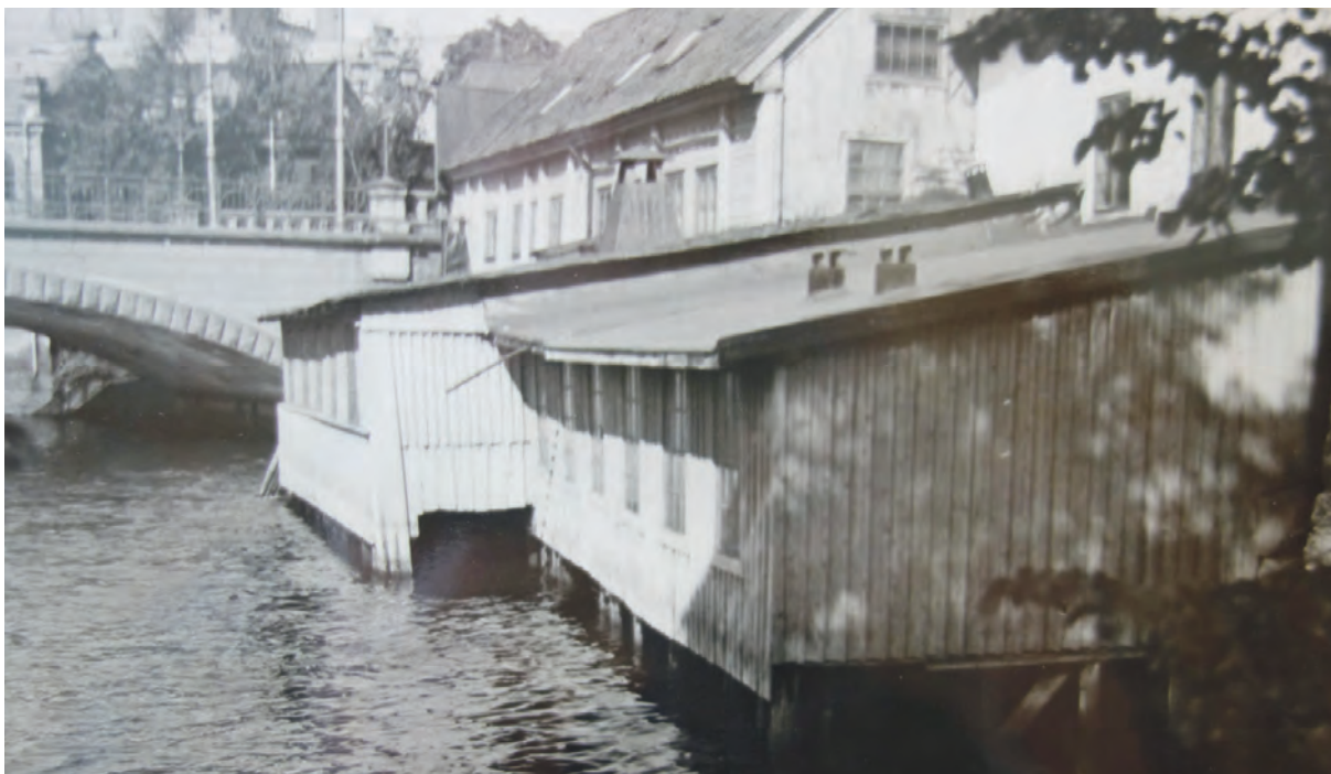
Färgeribygnaderna som låg ut över strömmen där nuvarande Kärleksparken ligger. Byggnaderna hade viss överhängande yta som stod på pålar i vattnet. Foto av Kurt von Schmalensee 1932. Hämtat ur Norrköpings stadsarkiv.
