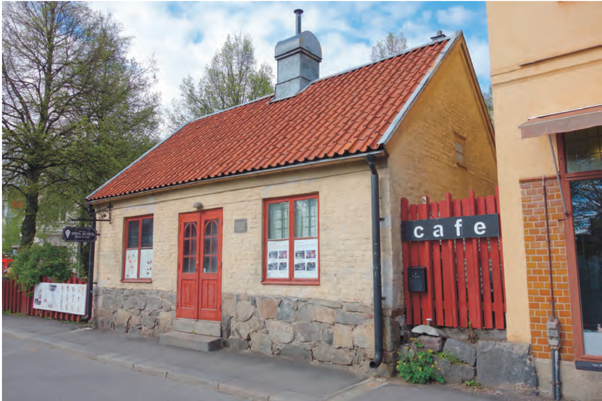
Byggnaden på Mjölharen 14, "Sista supen" sedd från Västgötegatan. Hög naturstensgrund. Tunt putsad fasad. Rödmålade fönster och dörrar. Tegeltäckt tak.
