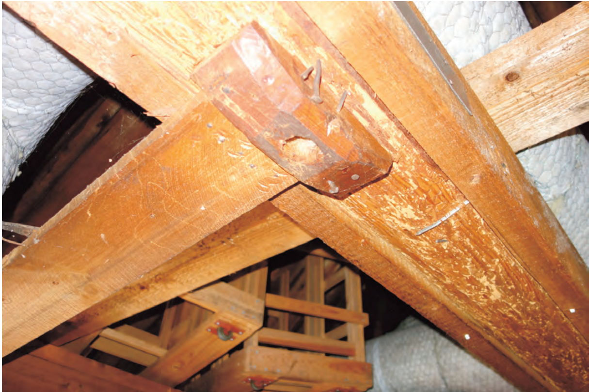
En kloss infäst i en takbjälke framför fönster mot öst. Troligen har denna kompletterats med en motsvarande kloss på golv och en enkel vansch kan ha funnits på vinden för in- och utlastning till vinden. Liknande detaljer förekommer ofta i äldre magasin och kyrkvindar.
