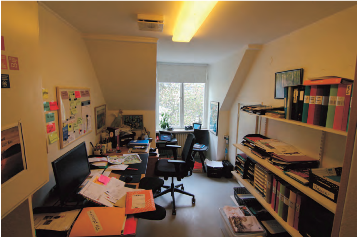
Ett av de två södra kontoren. Rummet har ett fönster med spanjolett, troligen bytt vid renovering 1932, oklart varför dessa givits avvikande utformning.
