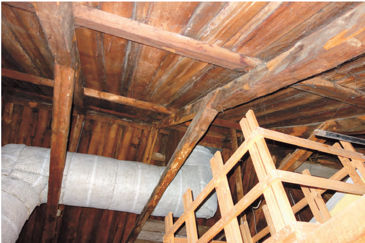
Äldre faltak är bevarat på byggnaden. Takstolarna är enkla och byggna i ganska klena dimensioner.
