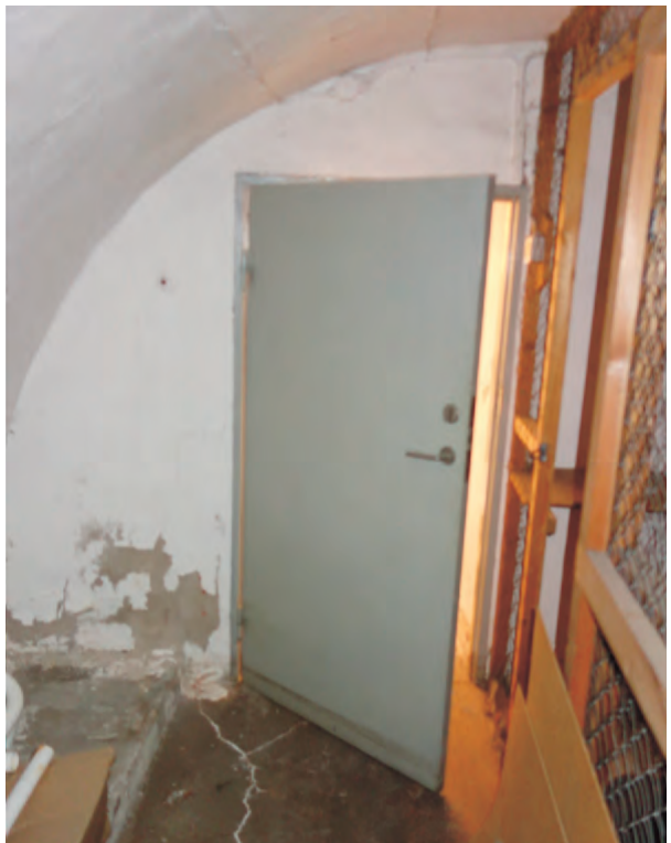
Entrédörr i den äldre källaren. Golvet är belagt med cement. Taket är tunnvävt.
