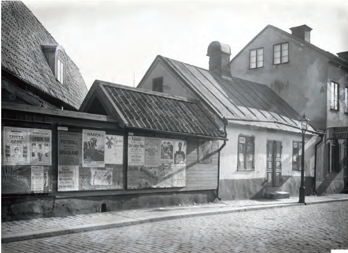
Fotografi av den tidigare laboratoriebyggnaden "Sista supen", troligen från 1890-tal. Byggnaden som tidigare använts som laboratorium hade vid denna tid troligen ett papptak och slätputsade fasader samt en ålderdomlig prägel i snickerier. Till vänster syns den täta stadsbebyggelsen av trä som senare rivits. Foto av Wilhelm Wibergh, hämtat från Norrköpings stadsmuseum.
