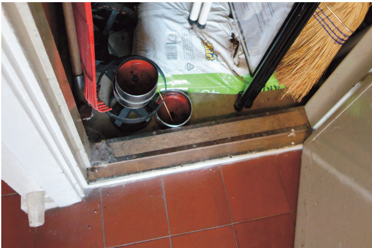
Dörrens träkarm är stålsockd. Möjligen en bitflyttad garderobsdörr från tiden innan 1932.
