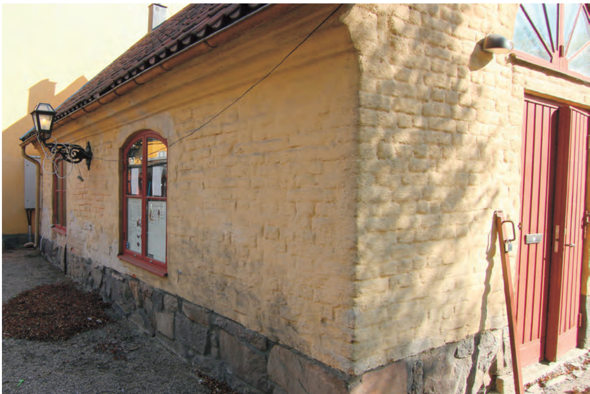
Byggnadens nordvästra hörn mot innergården. Samtliga snickerier bytta 1971 och även tak utbytt. Fasaden putsades om i samband med denna ombyggnation.
