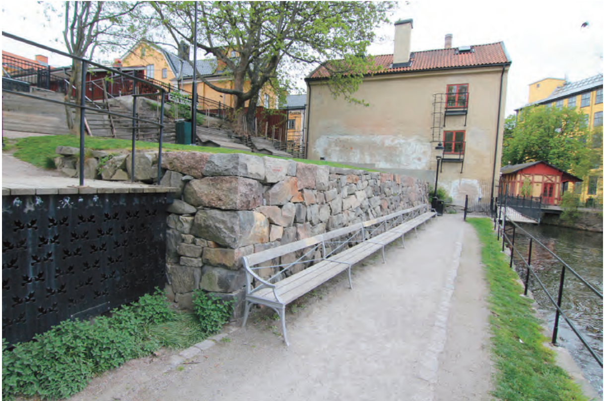
Den höga stenmuren mot öst som avdelar parkens två nivåer. Marknivån uppböjdes 1990 och breddades mot vattnet. Gatstenskanten indikerar ungefär bredden av gången innan ombyggnation 1990. Den grusbelagda vägen leder bort mot parkens sydöstra entré. Till vänster syns trappans plåtsida med utskurna dvor.
