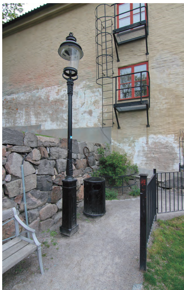
Äldre gaslykta, anpassad till elbelysning, vid entrén i parkens sydöstra hörn på nedre nivån.
