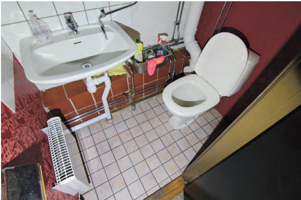
Byggnadens wc, installerades vid renovering på 1970-talet. Den låga kaklade sockeln är lagd på en murad sockel som troligen varit synlig invändigt tidigare.
