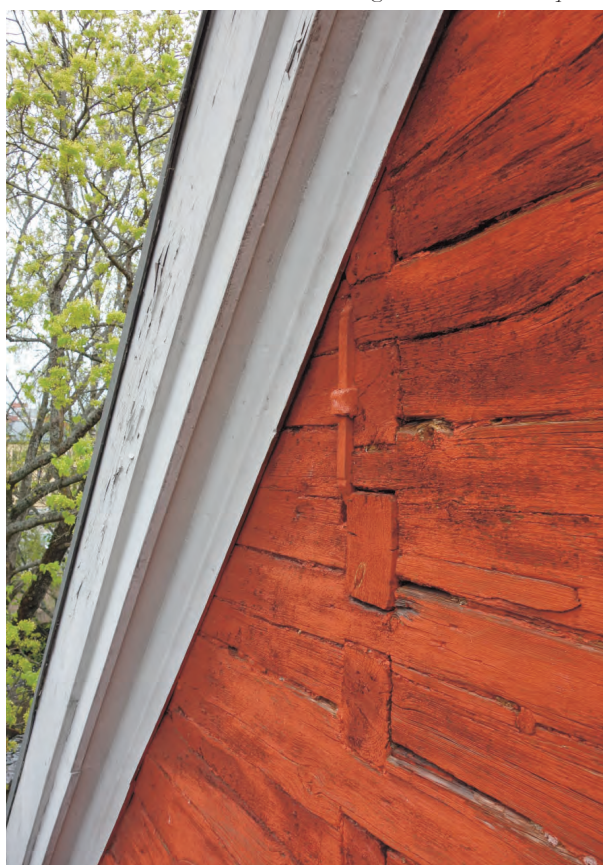
Längs gavelsidornas takfot löper en bred profilerad bräda, troligen av hög ålder. Denna har kompletterats med nyare vindskivor. Notera även ankarlut i timret.
