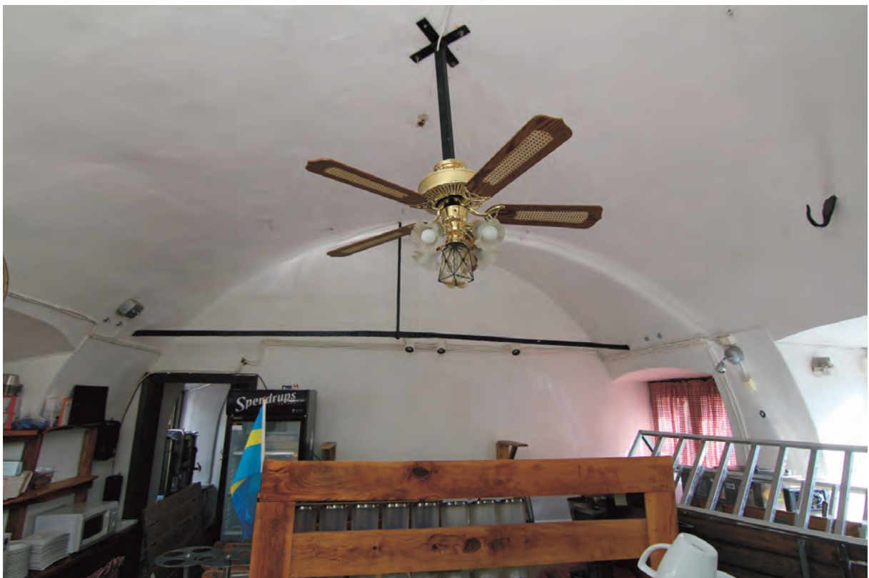
Det västra rummet. Tunnväht tak, vitputsat med dragjärn mellan väggarna synligt i bakgrunden. Till höger syns även smidd krok som är inmurad i taket. Till höger är entrén mot Västgötegatan, till vänster dörren mot byggnadens östra del.
