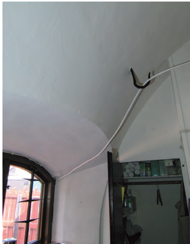
Krok monterad i tak i östra delen av byggnaden. Här har fönster en rundad överdel.
