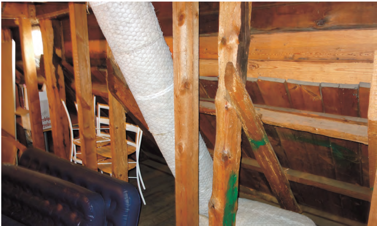
Timmerstomme är angripen och därefter "renbuggen" vid sanering, troligen 1971 eller senare. Äldre timmerstycken är därför ofta mycket klena och kompletterade med stöttor och nya stolpar.
