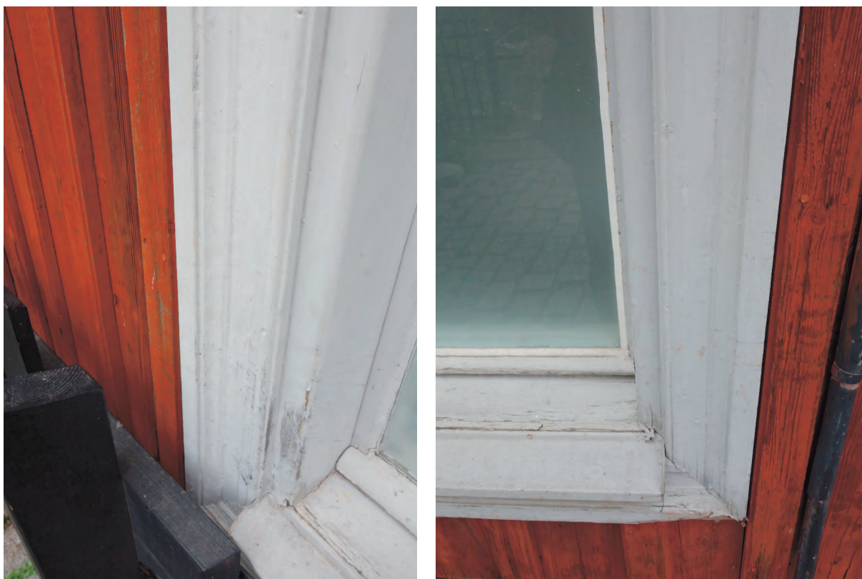
Fönsteromfattningar uppvisar vissa tecken på hög ålder, med bland annat flera färglager. Utformningen ser ut att överensstämma med foton från tidigt 1900-tal.
