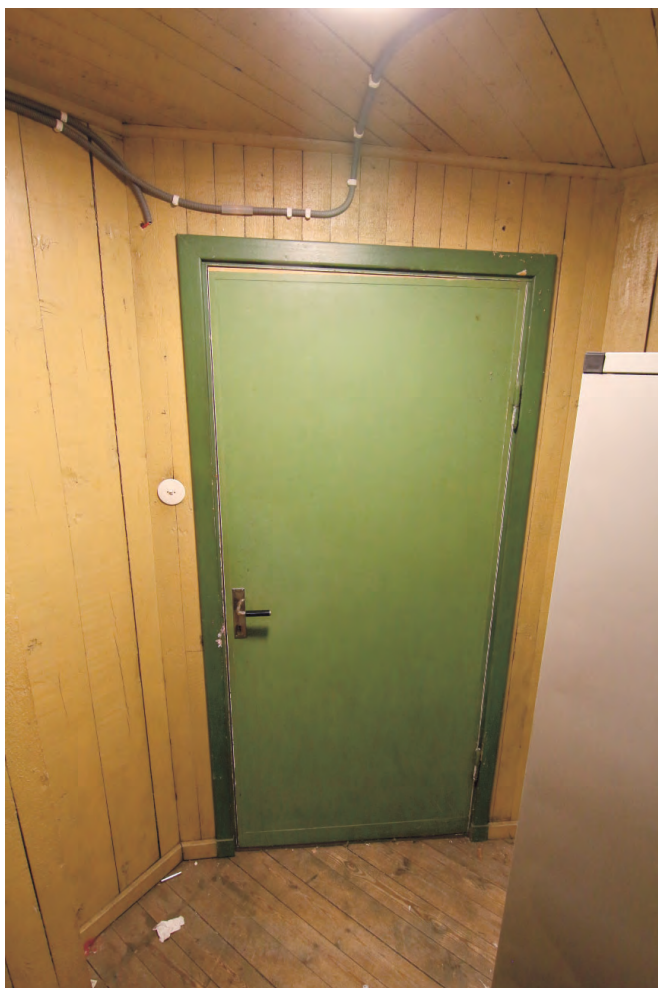
Dörren på plan två till det kallställda utrymmet med trappan till vinden. Både väggar och golv består av enkel träpanel, väggarna är målade i en gul kulör. Uppfört vid ändringen av byggnaden 1932.
