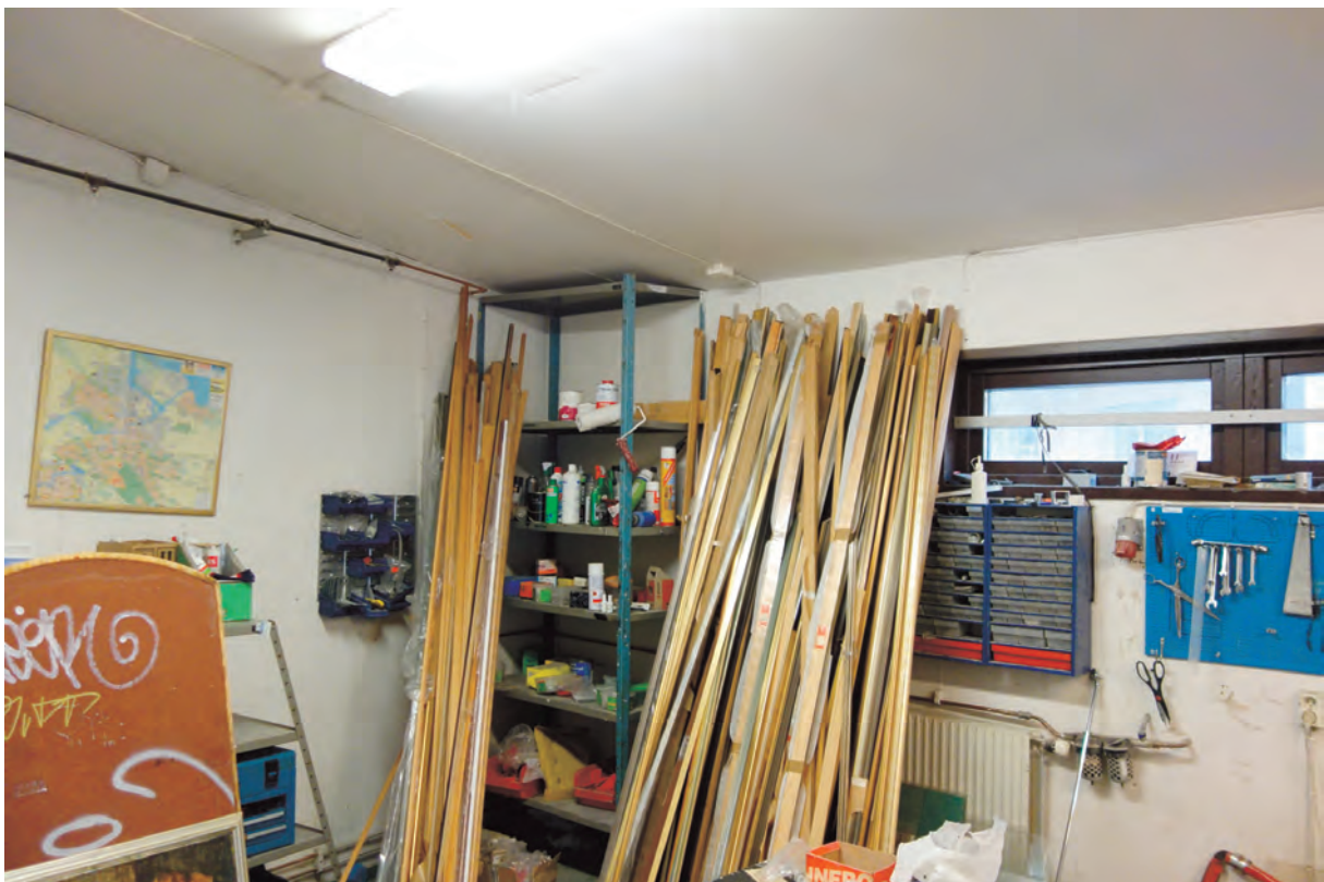
Södra verkstadsdelen sedd mot sydöst. Tak och väggar är klädda med gips.
