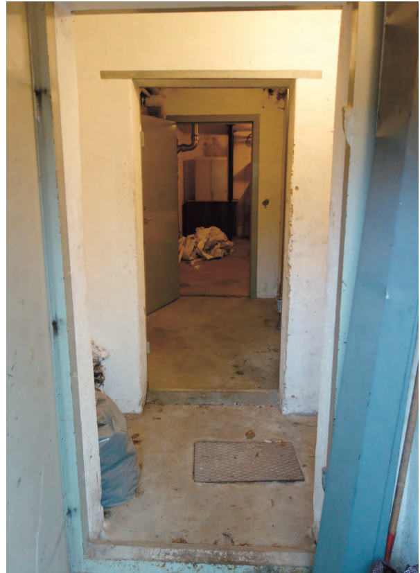
Foto från källarens entré. Rum ligger efter varandra. Den äldre källardelen är placerad direkt till böger.
