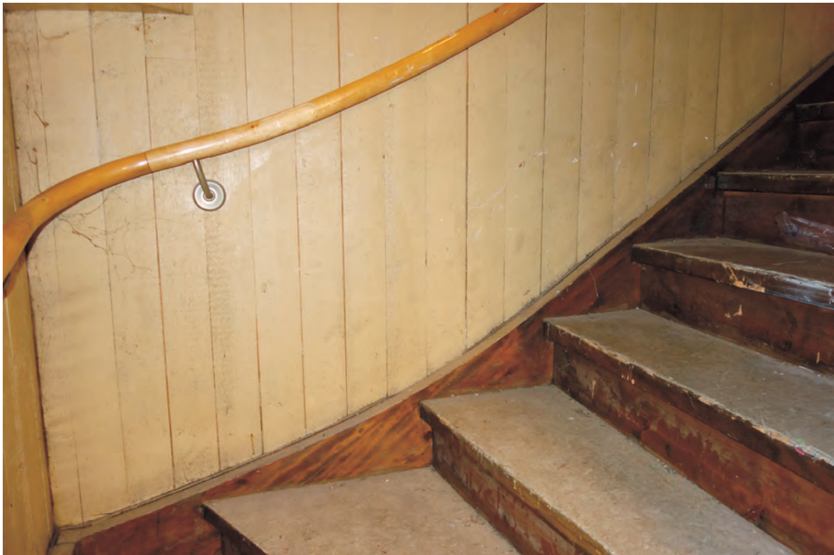
Handledare har samma utformning som trappan till övre plan. Vångstycke och steg är enklare och målade för att efterlikna ek. Vägg består av enkel panel.
