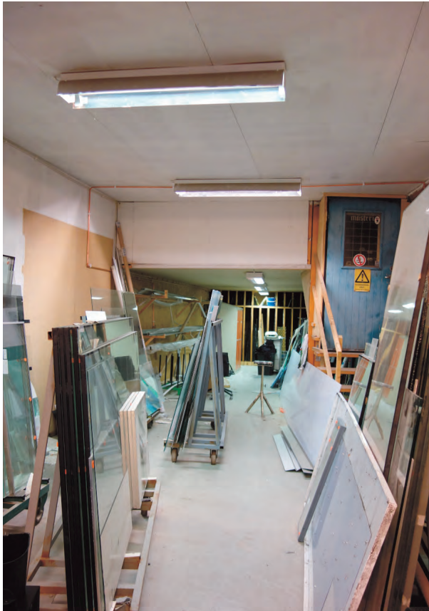
Verkstadsbyggnad sedd mot norr. Det avlånga rummet är invändigt klätt med gips och har betonggolv. Används fortsatt som verkstad/ förråd.
