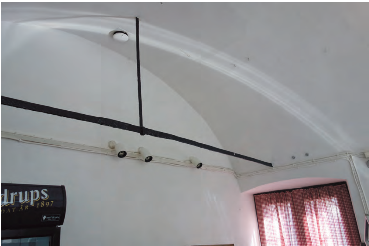
Byggnadens välvda tak med smidda stag som fungerar som dragstag för att hålla byggnaden samman. Detaljen syns i många äldre murade konstruktioner från 1700-talet och ännu tidigare. Inga ankarslut syns dock utvändigt.
