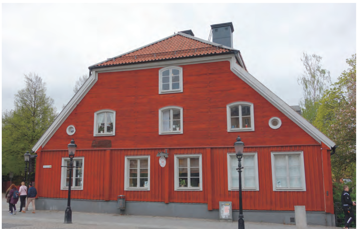
Bergslagsgårdens västra gavelsida med rektangulära fönster i bottenvåning och fönster med välvd överdel på plan två. Vindsfönstret är från 1700-tal och har en avvikande spröjsindelning.
