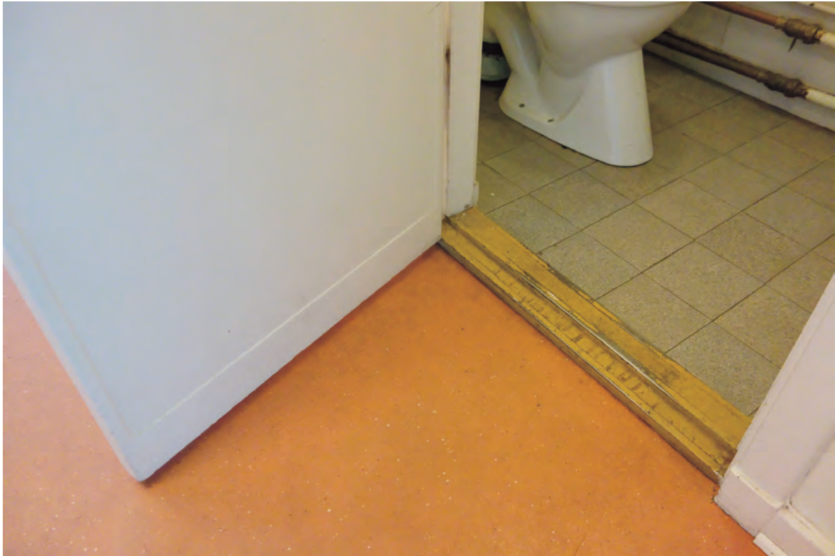
Wc-dörr i byggnadens sydöstra del, även denna tröskel är stålskodad och av samma utformning som garderobsdörren, fast något bredare. Även denna kan vara flyttad och återvänd inom byggnaden.
