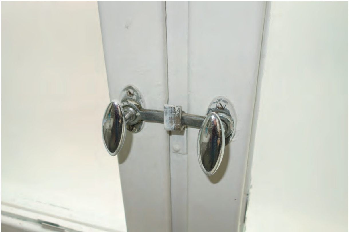
Invändiga fönstervred i inåtgående fönster. Dessa byttes av allt att döma under renoveringen 1932.
