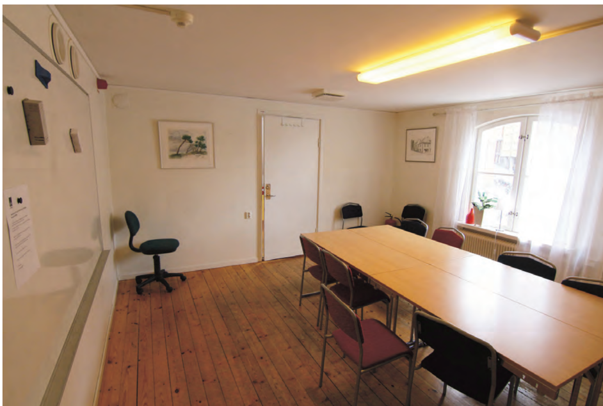
Rum på plan två mot väst. Träggolv från ombyggnaden 1932 finns i rummet, dock har de troligen inte varit tänkta att synas utan är lagt som undergolv. Äldre linoleum från ombyggnationen förekommer i kattvindar och garderober.
