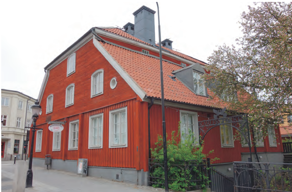
Foto från sydväst. Utvärdig utformning med panel, knutlådor längs gavelsidan och fönstersättning. Takets skorstenar och avluftningar syns tydligt här.
