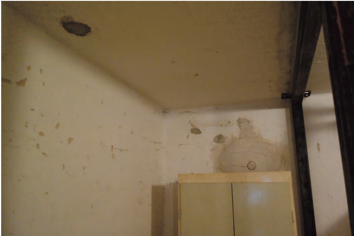
Det stora förrådsrummet har en putsad, rundad övergång mellan vägg och tak, typiskt för 1900-talets första hälft. Senare ombyggnationer och lagningar har utförts och sedan ej målats.
