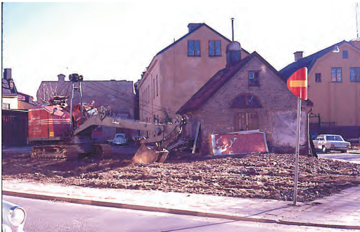
Tomten som idag heter Mjölaren 14, fotograferad 1971 efter rivningen av den äldre stadsgården, tidigare apotek och livsmedelbutik. Kvar på platsen står endast den gamla laboratoriebyggnaden. Notera att denna ej är putsad. Till vänster bakom grävmaskinen kan skimras även befintliga förrådsbyggnader som står på platsen. Foto från Norrköpings stadsmuseum.
