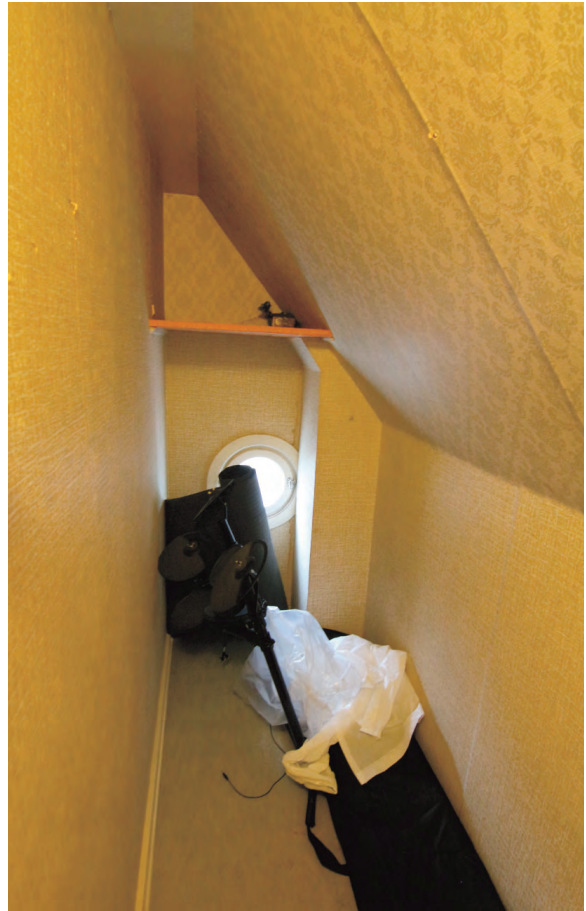
Kattvind mot sydöst. Rumsform troligen bevarad från 1740-tal, modernare ytskikt.
