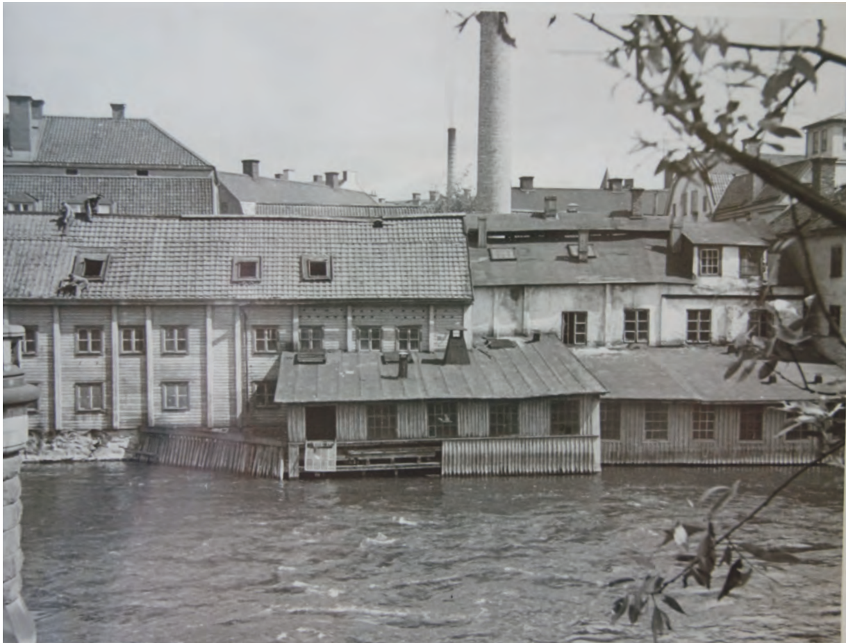
Foto från rivningen av färgeriet på Bergsbron 7, tagna av Kurt von Schmalensee 1932. Här syns färgeribyggnaderna i sin helhet, liggandes i flera etage. Stenskoningen längs vattnet skymtar till vänster. Foto från Norrköpings stadsarkiv.
