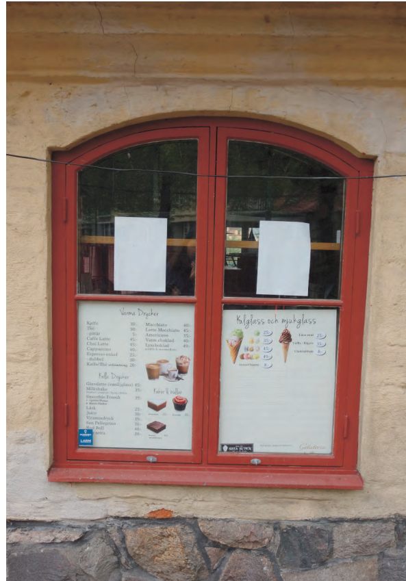
Fönster mot norr har samma utformning som flera fönster på Bergslagsgården, detta fönster är dock även det bytt på 1970-tal.
