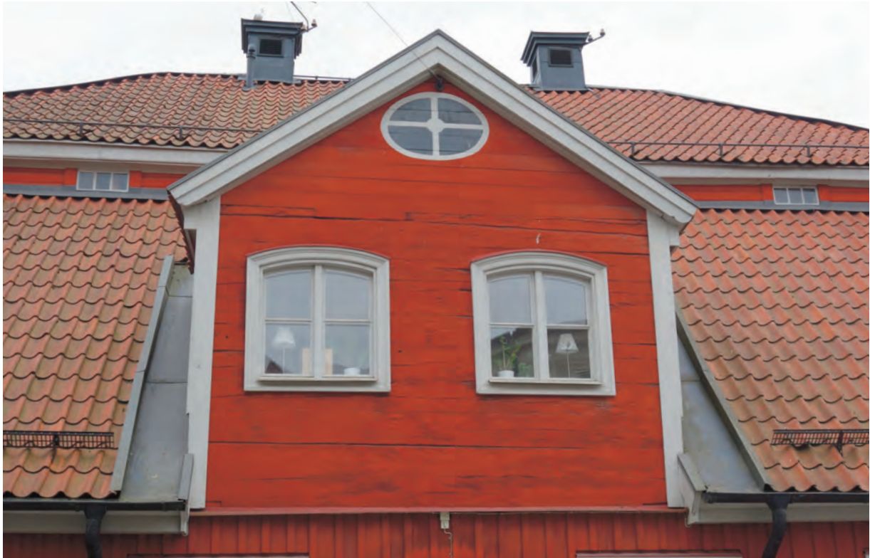
Takkupa mot norr med två välvda fönster. Enligt uppgift ska spår efter ett fönster i gaveln återfunnits 1971, idag målat i gavelspetsen, men dessa stockar byttes vid renoveringen 1971 så inga spår efter denna öppning finns bevarade.
