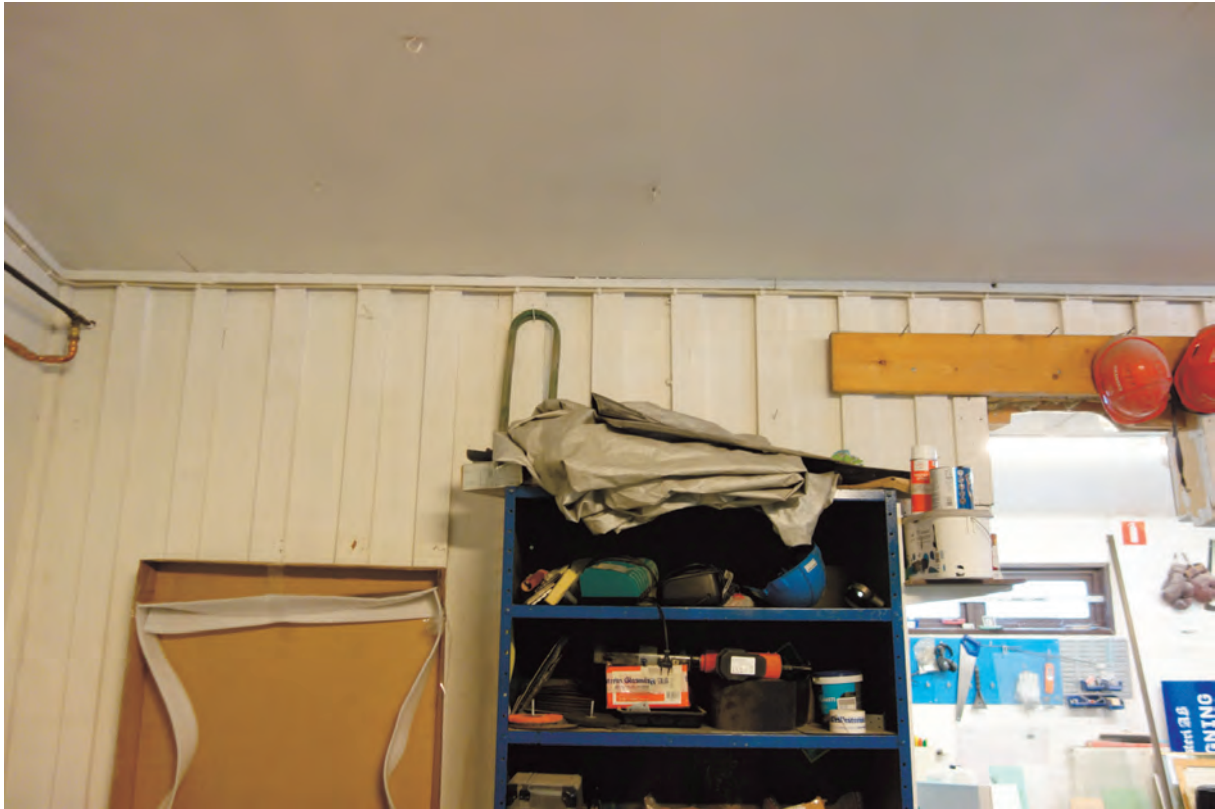
Vid tillbyggnaden har en panelklädd vägg lämnats synlig inåt, denna är däremot del av boden som bör ha satts upp 1971 och borde inte ha utsidan vänd mot byggnadens insida. Möjligen är detta en äldre träpanel från bodbyggnaderna som tidigare stått på tomten.
