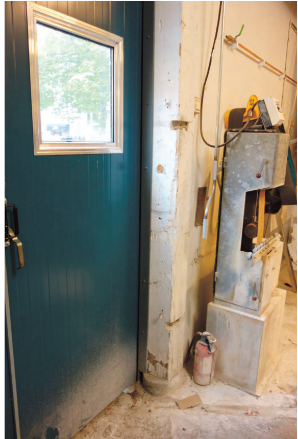
Stolpe vid förrådets entré är troligen återanvänd från äldre bodbyggnader på platsen.
