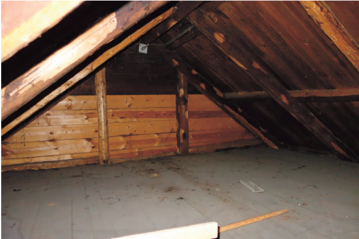
Takkupa mot norr på vinden. Där det uppges att man hittat spår efter ett runt fönster har timret bytts och äldre spår saknas.
