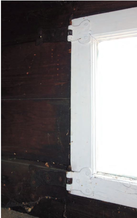
Fönster i italian mot norr. Gångjärnen har här målats i kulör som bäge och vägg.
