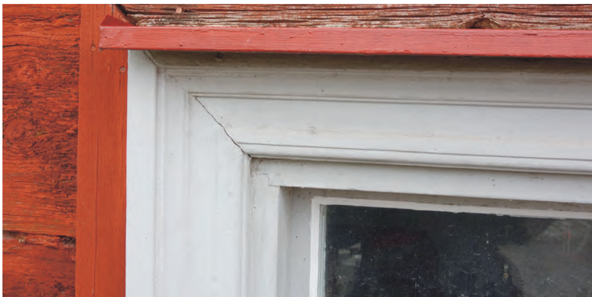
Fönsteromfattningen har en utformning som är typisk för 1700-talets slut. Om dessa omfattningar är av så hög ålder är ej fastställt.
