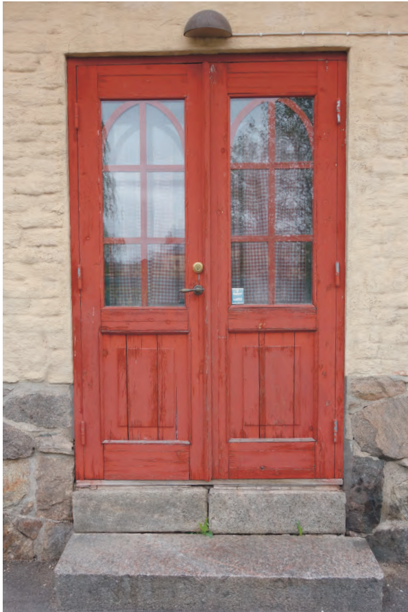
Entréddörr av ramverkskonstruktion. Återskapad efter äldre förlaga på 1970-tal.
