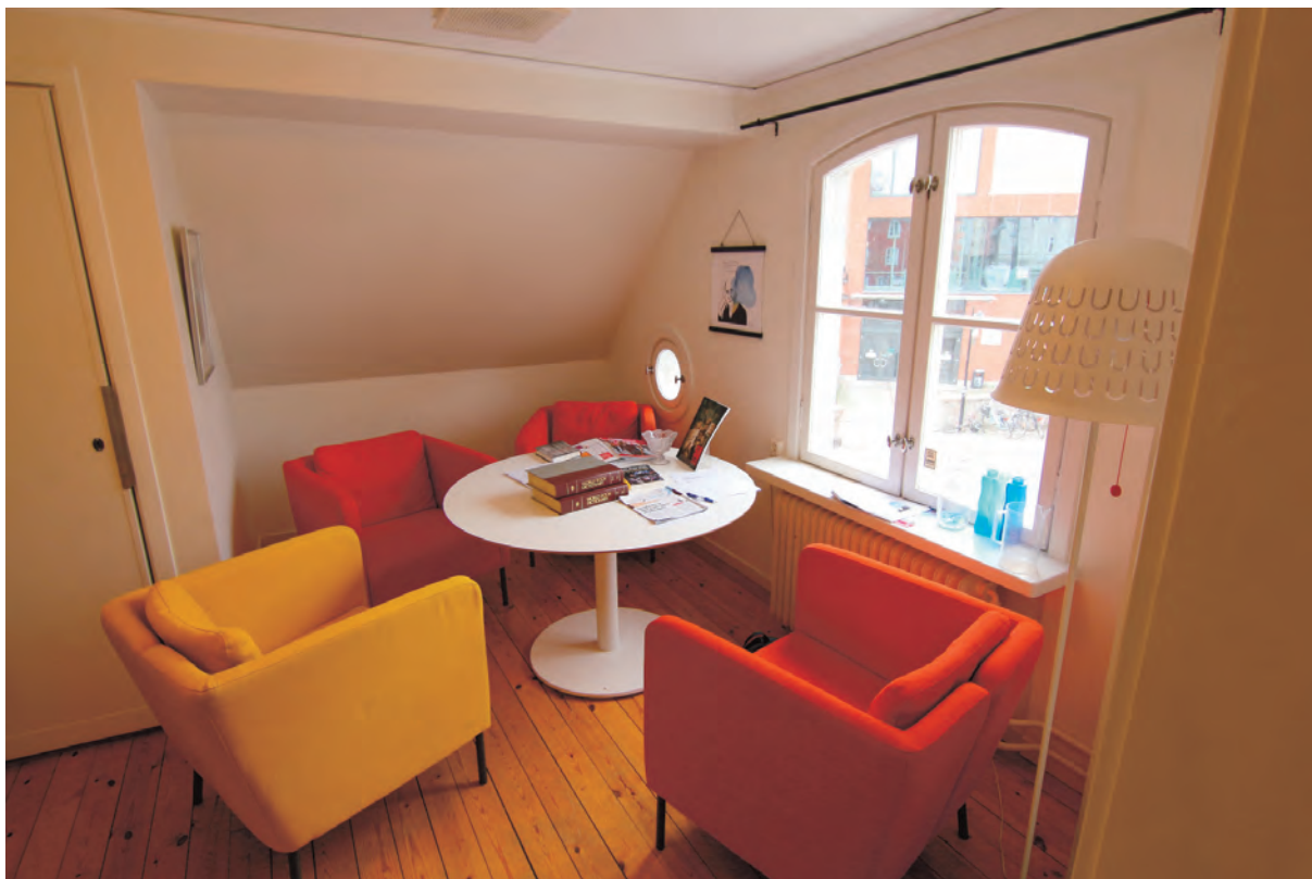
Rum mot sydväst, även här finns undergolvet frilagt. Kattvinden är ombyggd och blev del av rumsligheten 1932.
