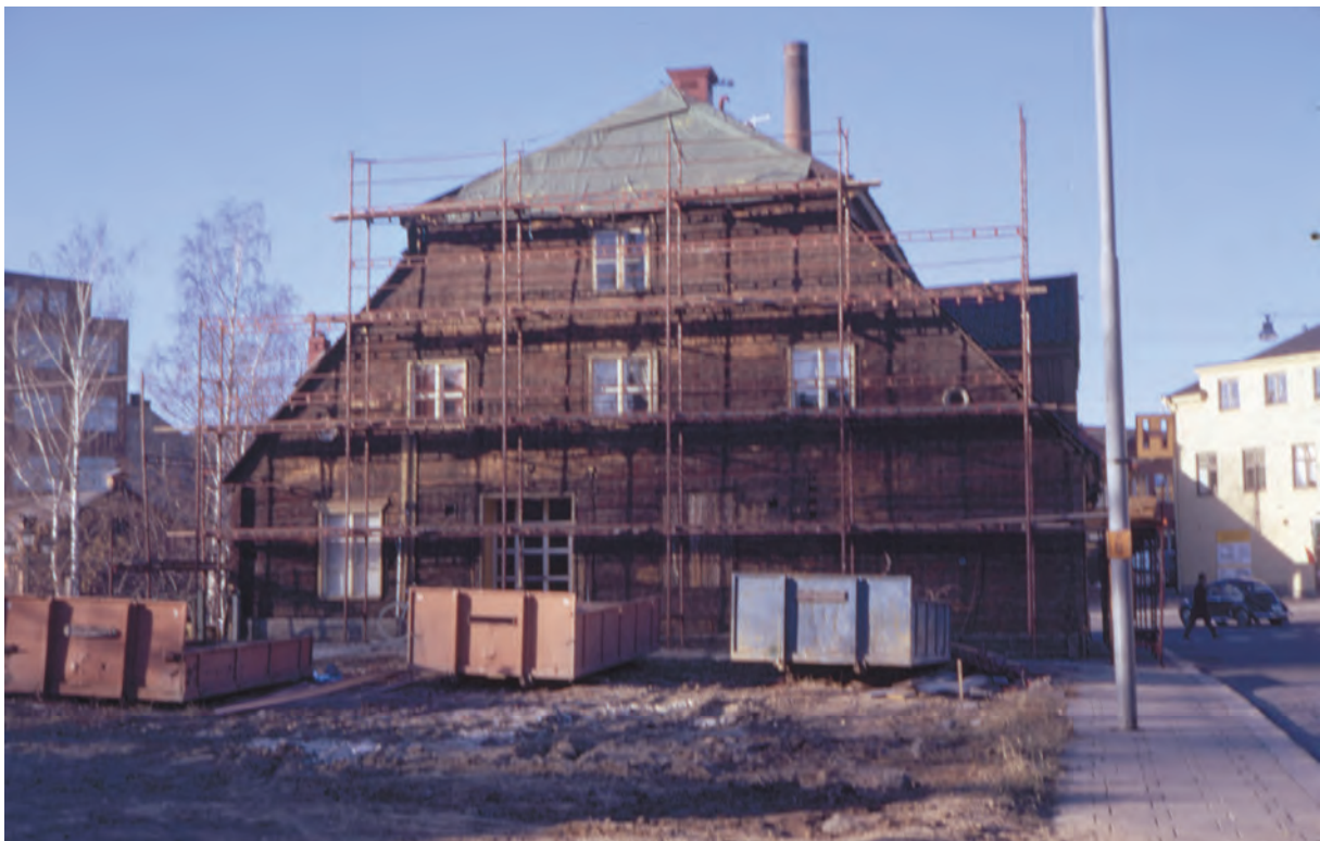
Foto från renoveringen 1971, Bergslagsgårdens östra gavelsida avtäckt från panel. Sidan visar timmerstommen som likaså varit rödfärgad tidigare. Bakom byggställningen, böjer om dörren kan man skönja ett äldre igensatt fönster. Hämtad från Norrköpings stadsmuseum.
