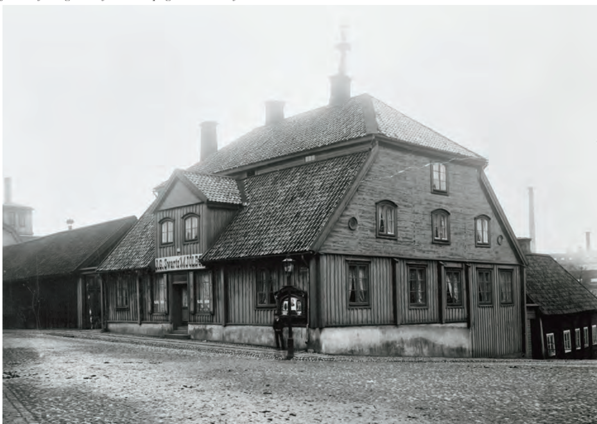
Bergslagsgården fotograferad omkring 1890 då J.G. Swartz mjölbod låg i byggnaden. Notera att Bergsbron från 1901 ännu inte finns och att slutningen mot strömmen är avsenärd mot syd (böger i bild). Byggnadens grund är av betydande höjd och färgeribyggnaden nedan har en rad fönster mot Kungsgatan och dåvarande bro. Foto från Norrköpings stadsmuseums arkiv.
