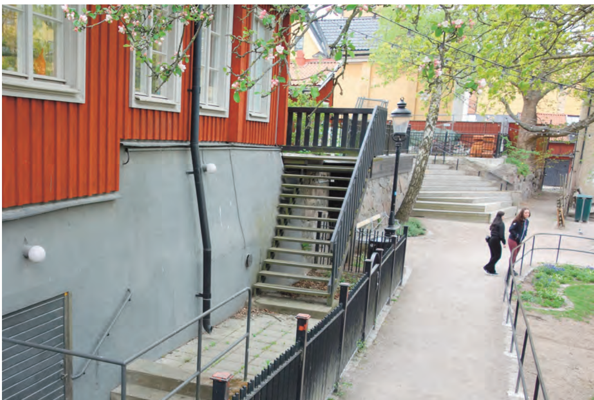
Trappa av stålkonstruktion med trästeg ned från fastighetens övre nivå ned till Kärleksparken eller byggnadens källare.
