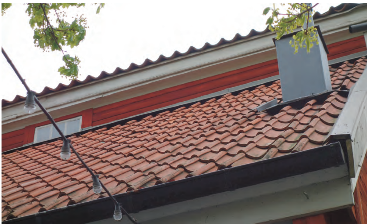
Italianens liggande panel med profilhyvlade sidor och takfotsläda. Fönstren är bland byggnadens äldsta.
