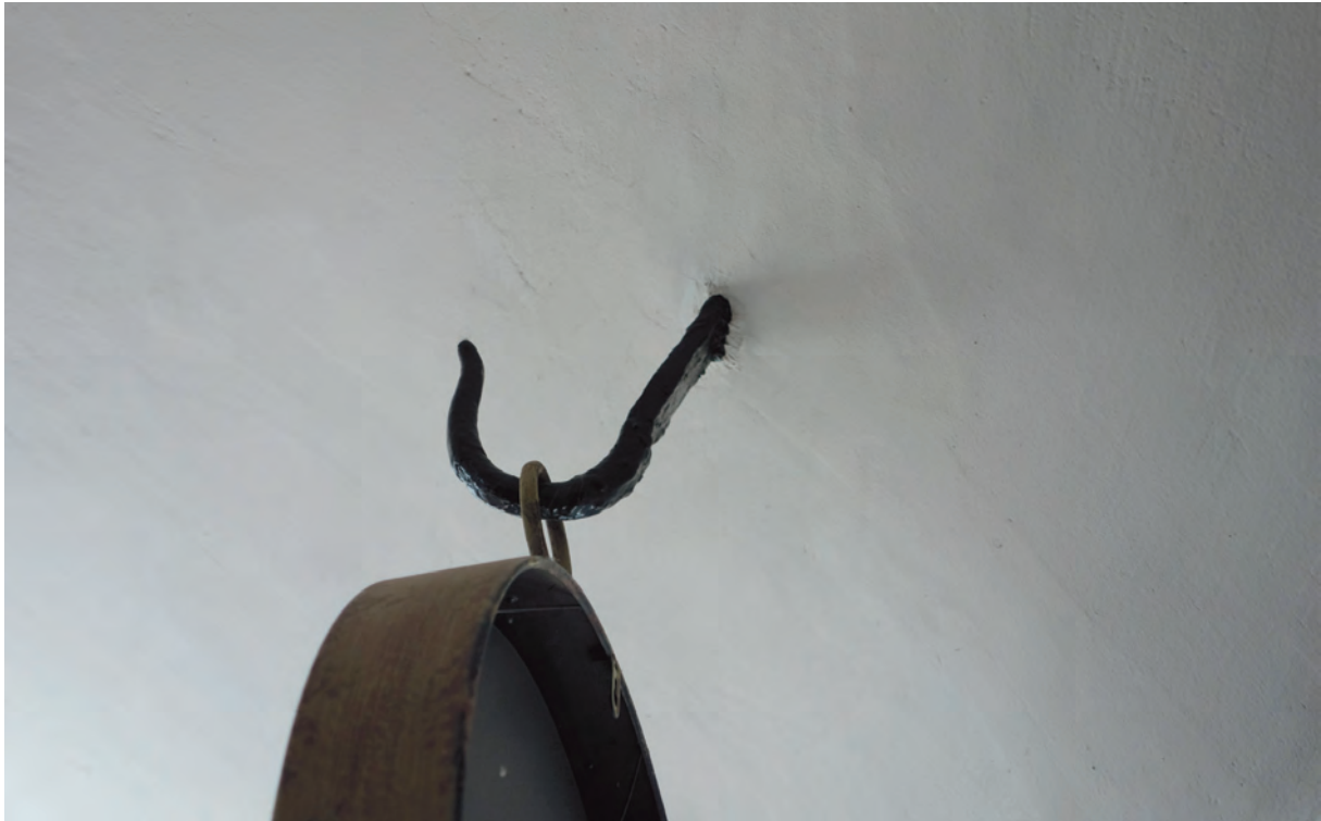
De smidda krokarna som förekommer i båda rummen är av betydande ålder, troligen från byggnadens uppförandetid. Två krokar finns i östra rummet, och två i det västra. De har sinsemellan korresponderande placering, vilket skulle kunna tyda på att den rumsindelning väggen är sekundär.
