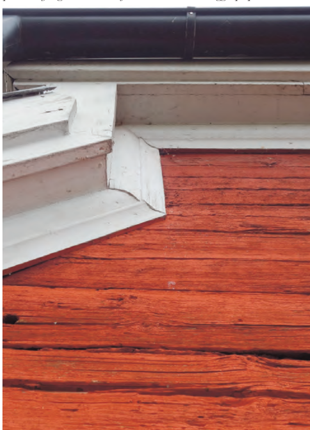
Längs gavelsidornas takfot löper en bred profilerad bräda, troligen av hög ålder. Denna har kompletterats med nyare vindskivor. Notera även ankarlut i timret.
