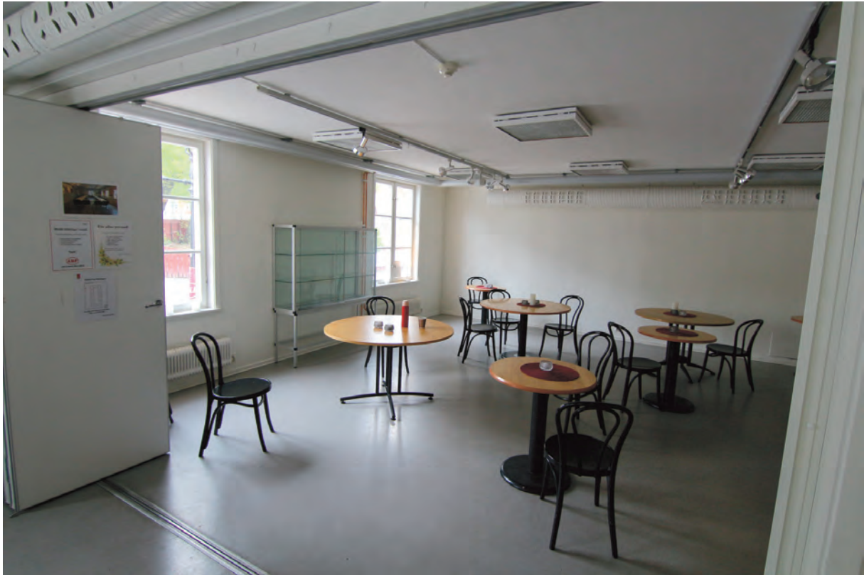
Samlingssal mot norr, modern ventilation och dragvägg installerad.
