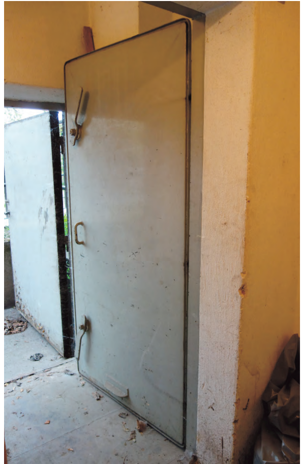
I källarutrymmet finns innanförvarande pansardörrar från skyddsrummsuppförande under 1940-tal.
