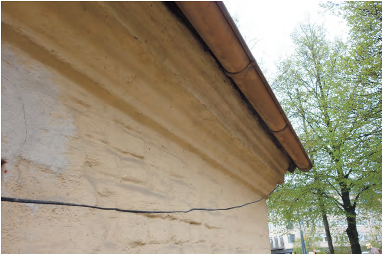
Gesims mot takfoten på norra långsidan mot innergården. Denna listdragning saknas mot Västgötegatan.
