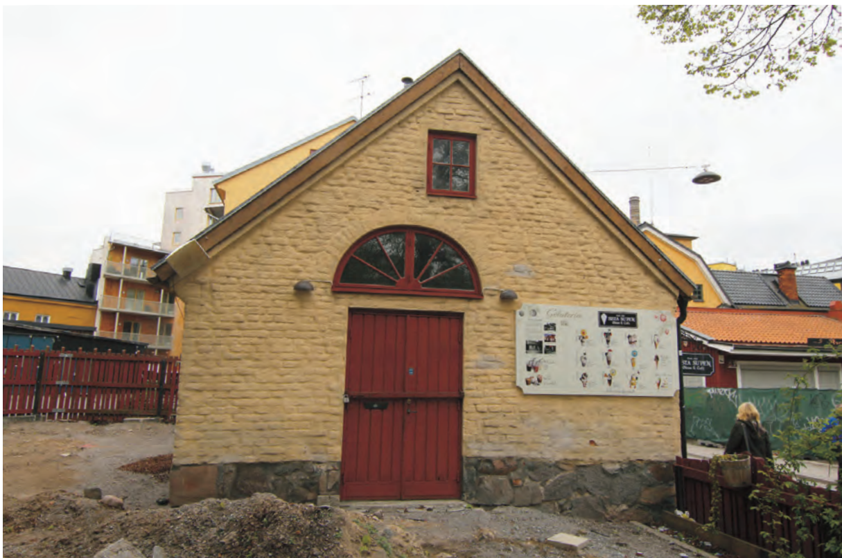
Gavelfasad mot väst. Sidoentré med stort lunettfönster och mindre fönster på vindsutrymmet. Byggnadens murverk under den tunna putsen är mycket tydligt på denna sida.
