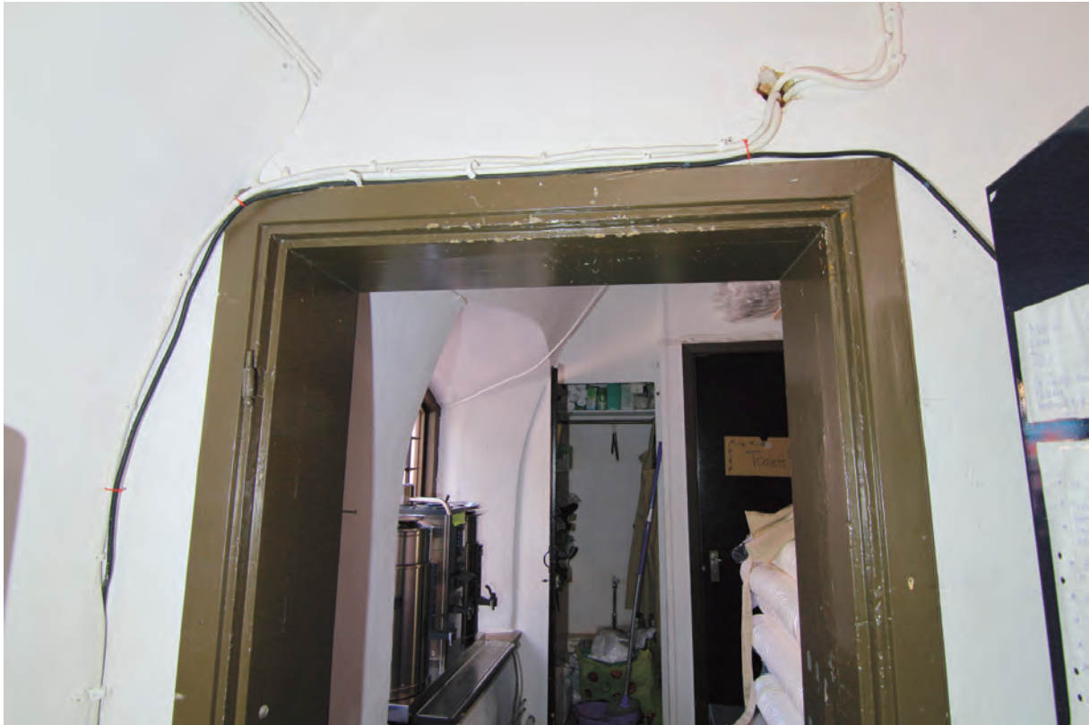
Äldre dörrkarm mellan östra och västra rummet. Gångjärn av betydande ålder finns kvar, men dörren har avlägsnats.
