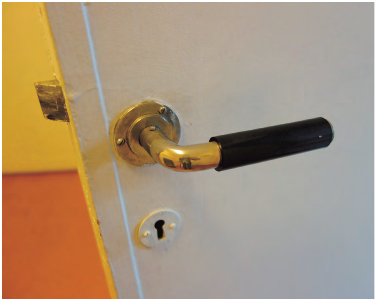
Dörr och trycke från ombyggnation 1932. Dessa dörrar finns på flera platser i byggnaden.
