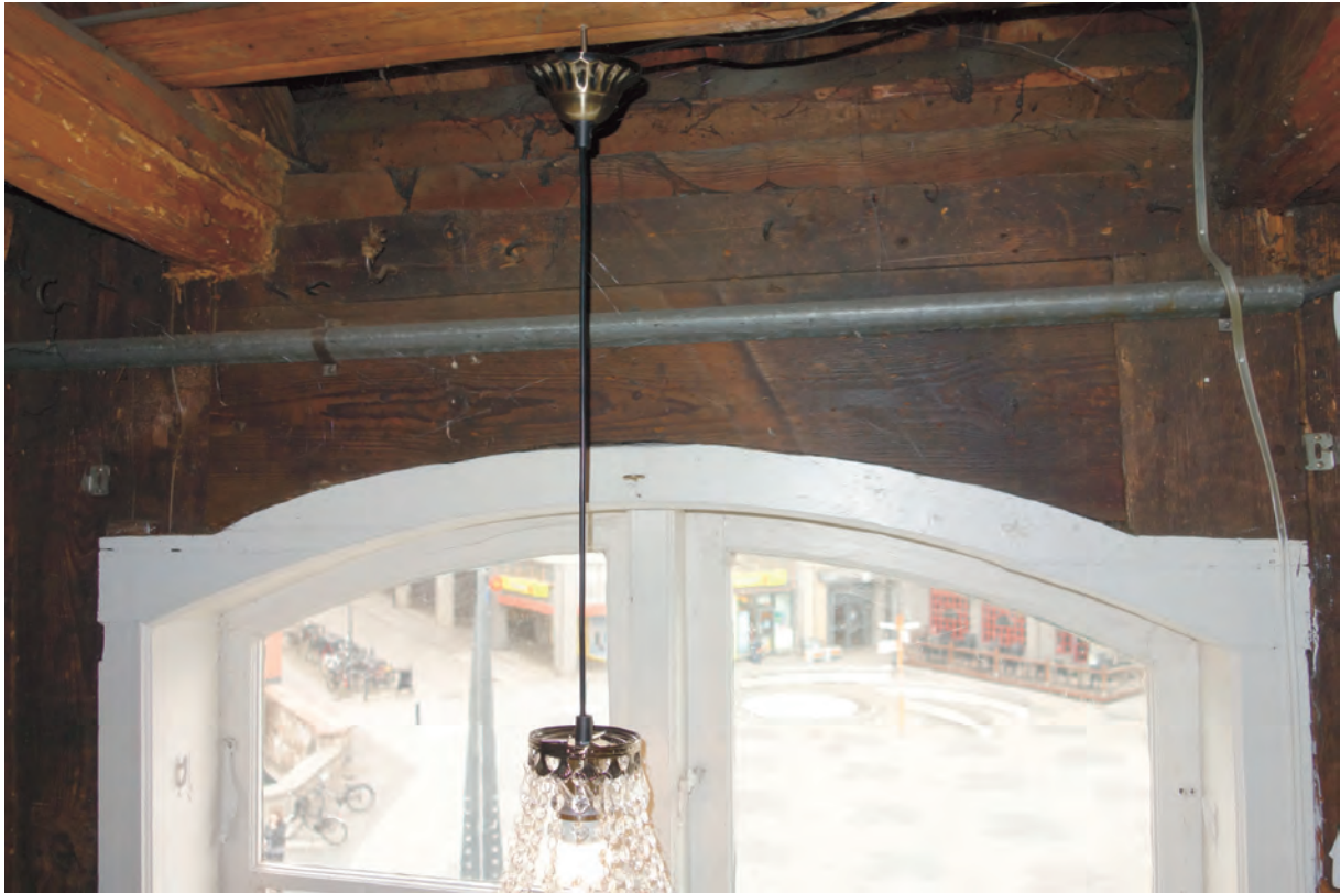
Fönster mot väst med vitmålad omfattning. Karm och båge samt beslag. Fönster är av allt att döma från 1700-talet.
