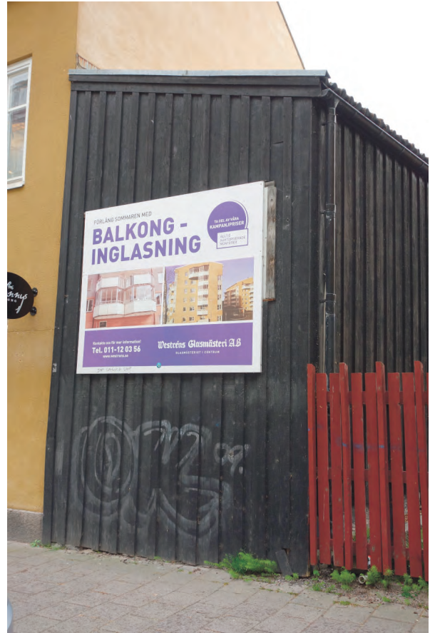
Byggnadens fasad mot bredgatan. Till höger om skylten syns en fönsteromfattning. Ett fönster sitter bakom skylten.
