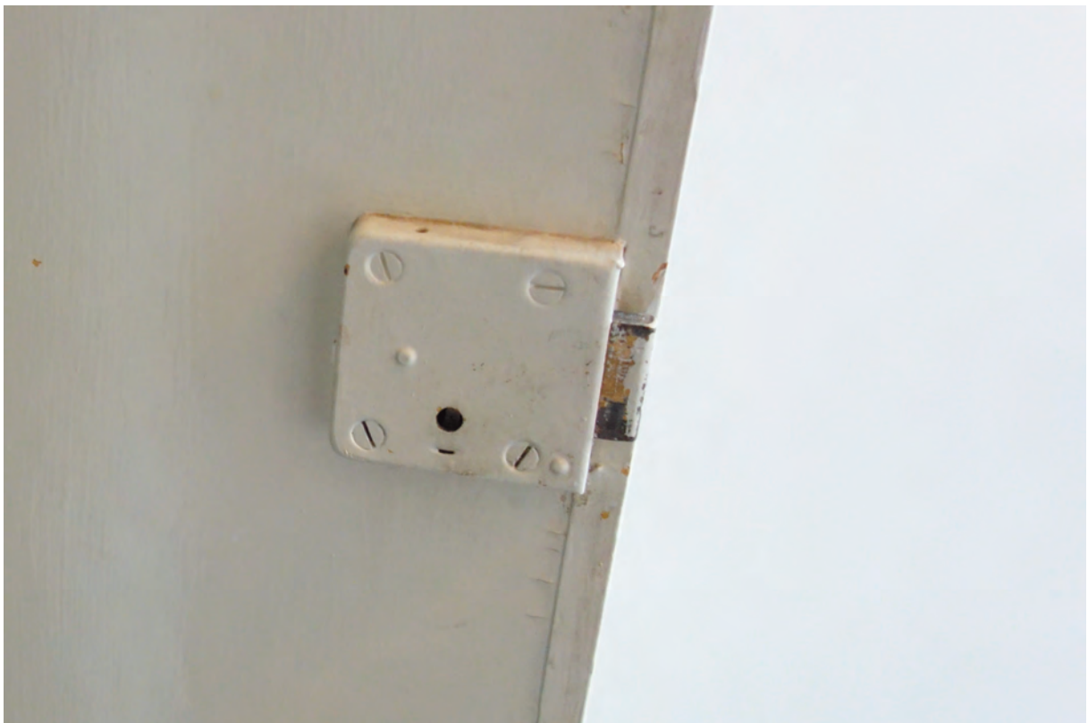
Trapphallen med ursprunglig trappplacering men ombyggd form. Till höger finns en smal dörr som är från tidigt 1900-tal. Bilden till höger visar nyckelskyften och bilden nedan visar kammarlås av tidig 1900-talsmodell, fabriktillverkad, kvadratisk, men saknar vred.
