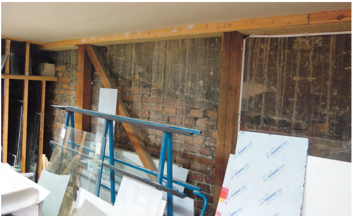
Bottenvåningens nordligaste del, här syns motstående byggnads puts samt avsaknad av puts med lutande plan, där en äldre bodbyggnad stått tidigare. Stolpar mot muren är troligen återanvända från tidigare bodbyggnader på platsen.
