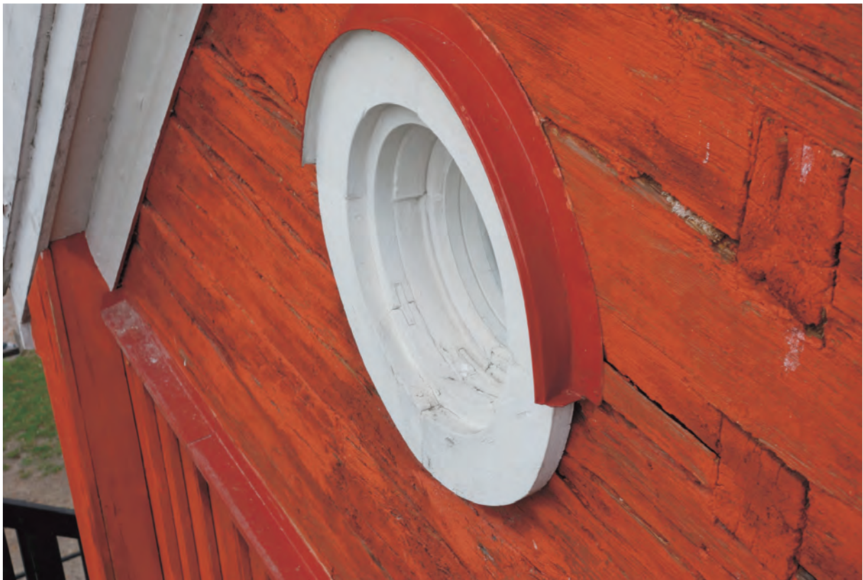
Oxögon i gavelsidan mot väst. Bågen har tidigare varit utåtgående. De synliga lötade karmdelarna är troligen av hög ålder. Notera även övergången mellan panelad nedervåning och frilagt timmer på övervåningen, dessa andelas med en plåtlist.
