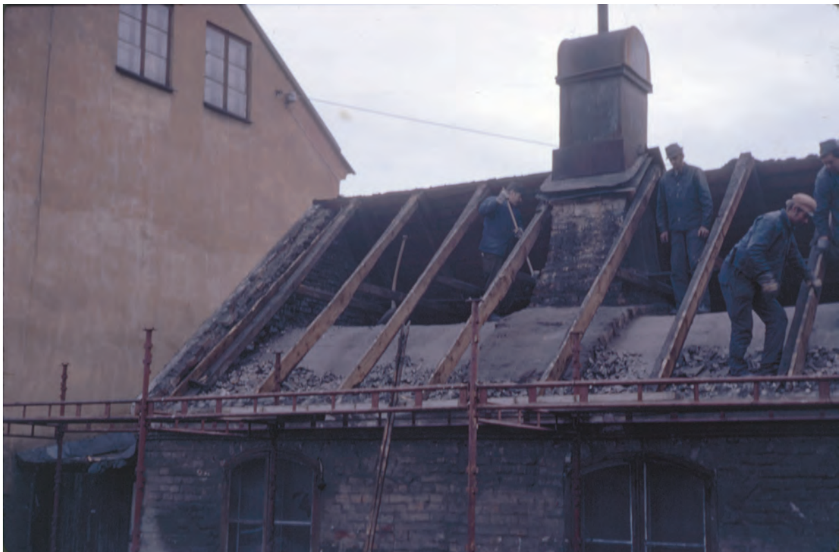
”Sista supen”, den gamla laboratoriebyggnaden, genomgår renovering. Byggnadens yttertak revs och lades om. Här syns byggnadens tunnvälvda innertak samt förstärkning vid murstocken ovanifrån. Foto från 1971, Norrköpings stadsmuseum.
