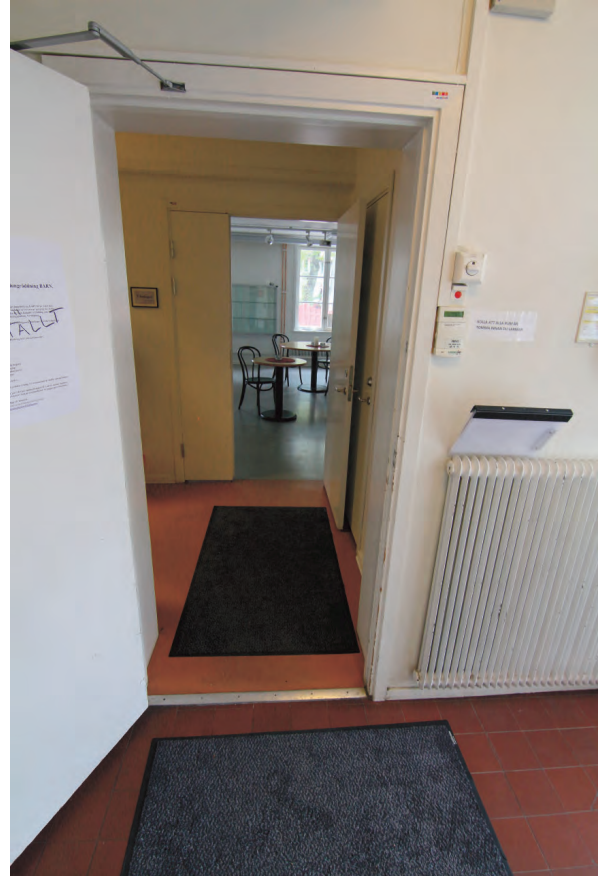
Foto från entréhallen mot norr och ABF:s öppna möteslokaler. Klinkergolv i hallen, plastmatta i övriga rum.
