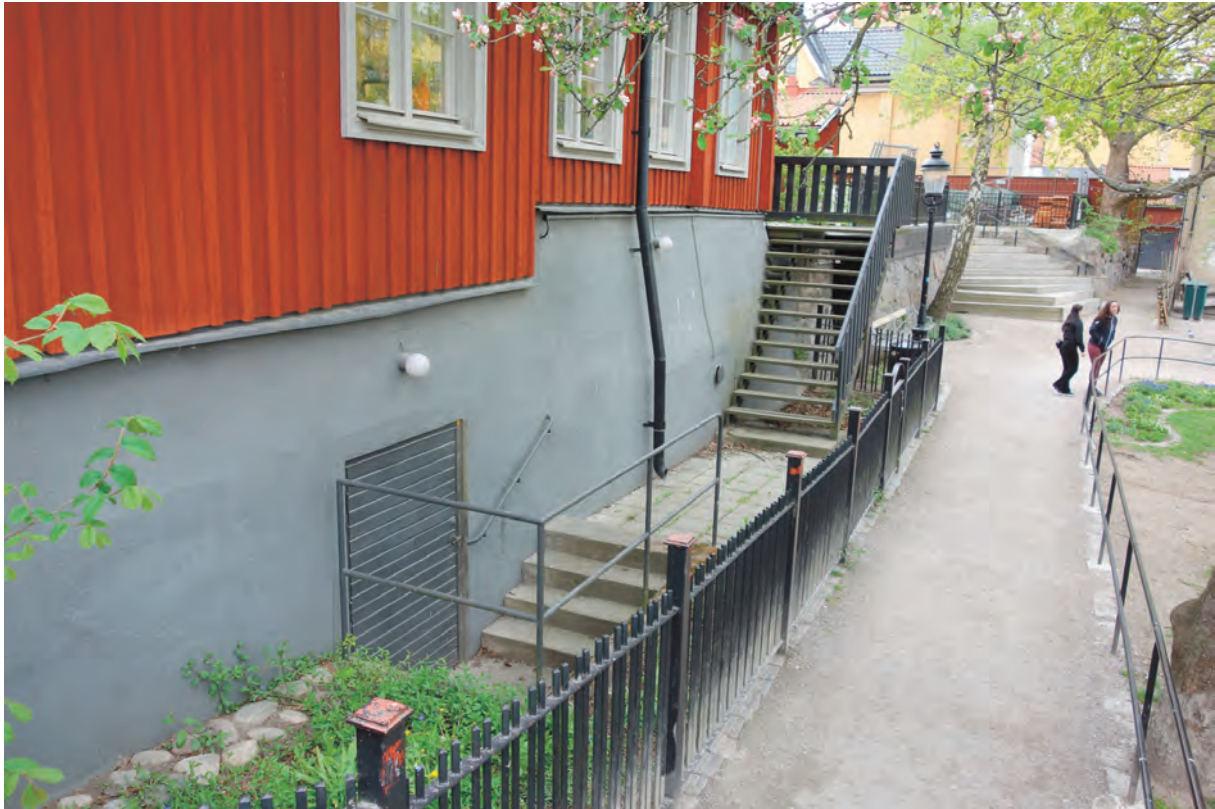
Byggnadens höga grund mot Kärleksparken i söder. Denna är putsad, torligtvis med cementhaltigt bruk och gråmålad. Utformningen återskapades 1971.
