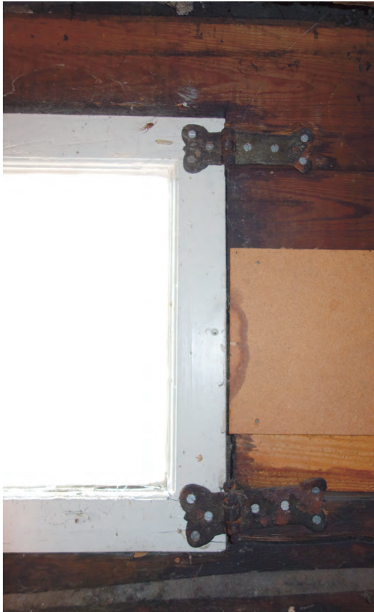
Gångjärnsinfästning i fönsterbågar. Fönster är inåtgående. Gångjärn från 1700-talet, fönsterbågar möjligen bytta under 1800-talet, infästningen med skruv troligen ändrad 1971.
