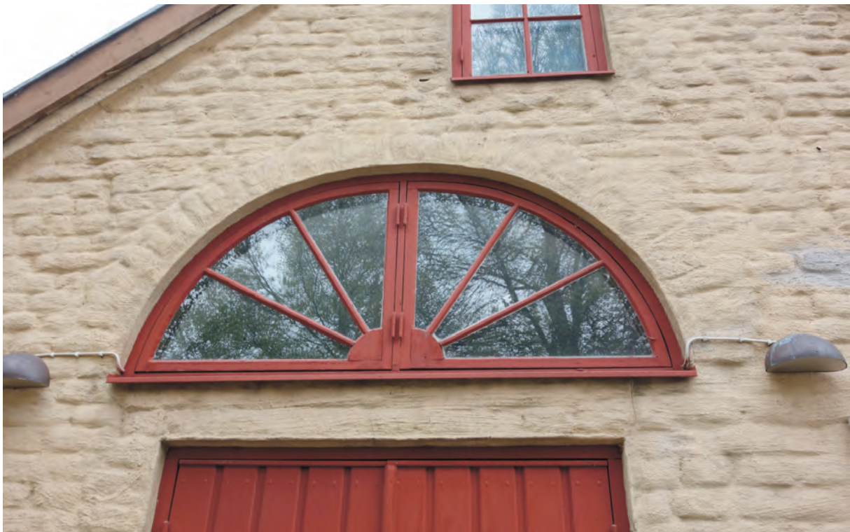
Stort lunettfönster mot väst. Både karm och båge är utbytt på 1970-tal.
