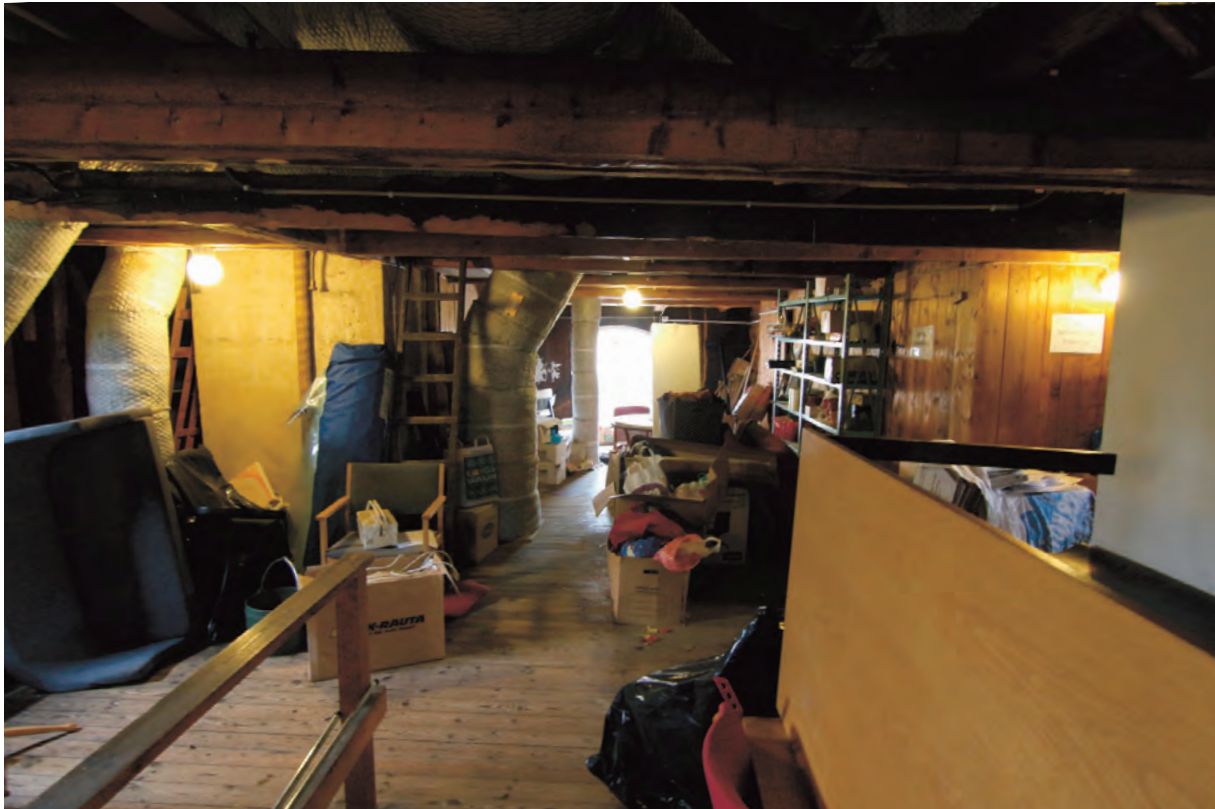
Vinden har frilagda takstolar och stomme. Till vänster finns en murstock, till höger finns förrådsrum och rakt fram finns troligen byggnadens äldsta fönster i gaveln mot väst.
