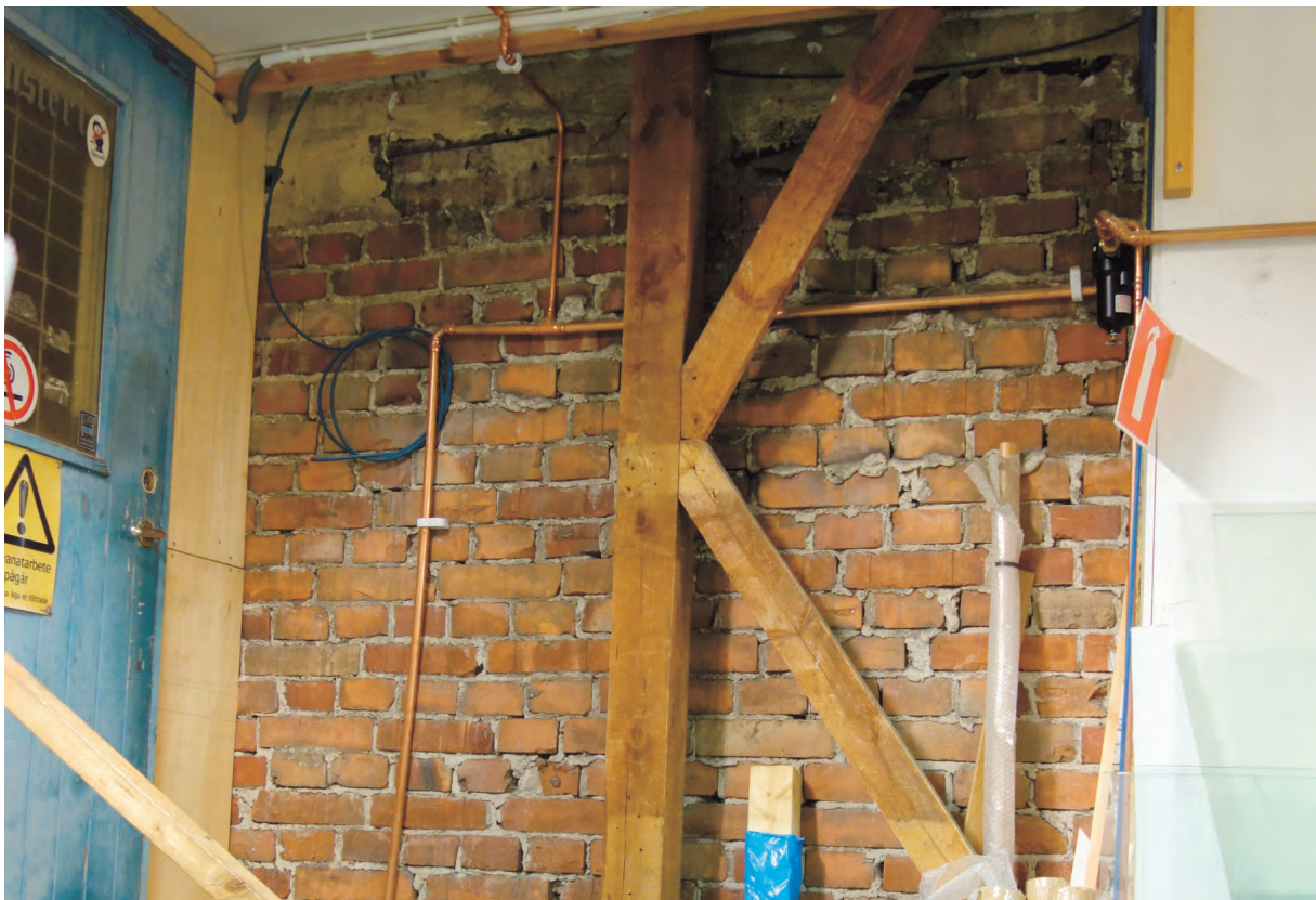
Opsad tegelmur centralt i byggnaden mot öst. Här syns tydligt var en byggnad stått innan 1971.
