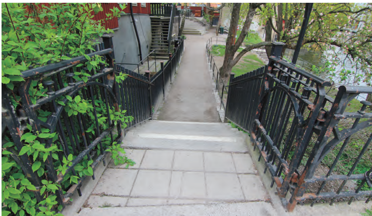
Trå grindar leder ned till parken, därefter en trappa med granitsteg. Staketet till vänster är något äldre, räcke till höger är nyuppfört omkring 2019.
