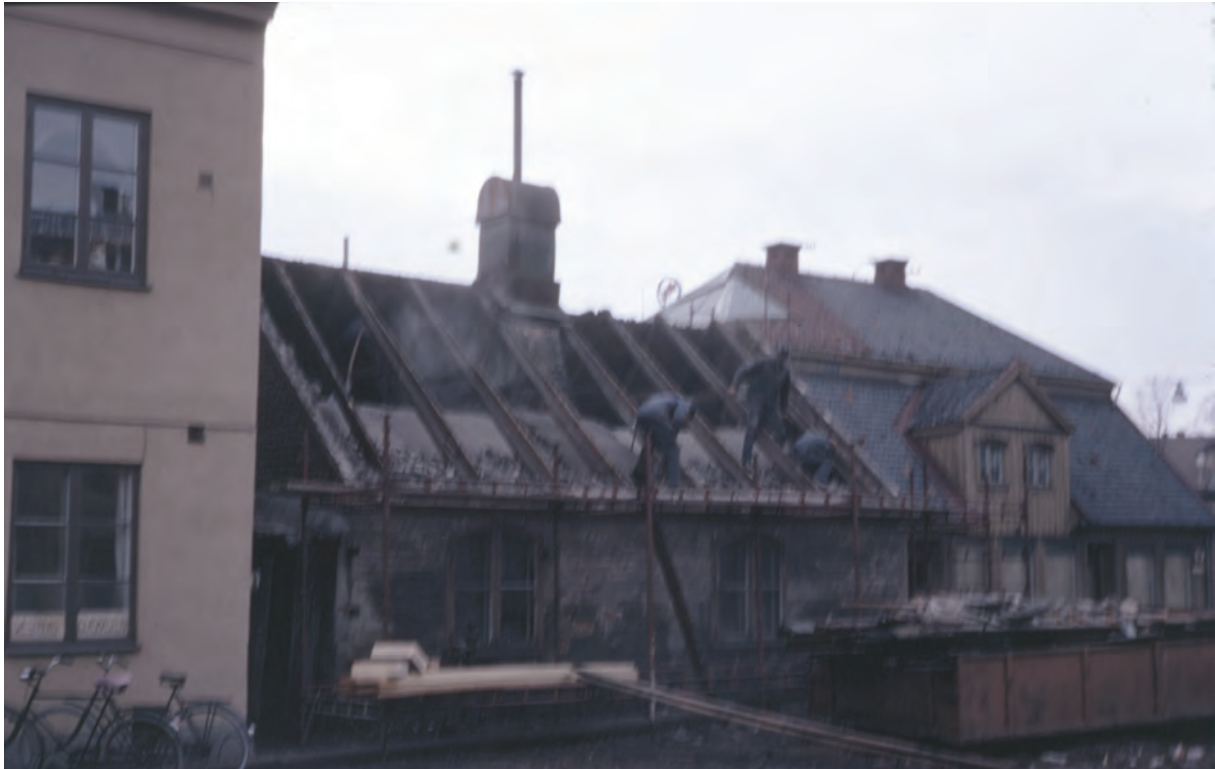
"Sista supen", den gamla laboratoriebyggnaden, genomgår renovering. Byggnadens tak revs och snickerier byttes ut. Foto från 1971, Norrköpings stadsmuseum.
