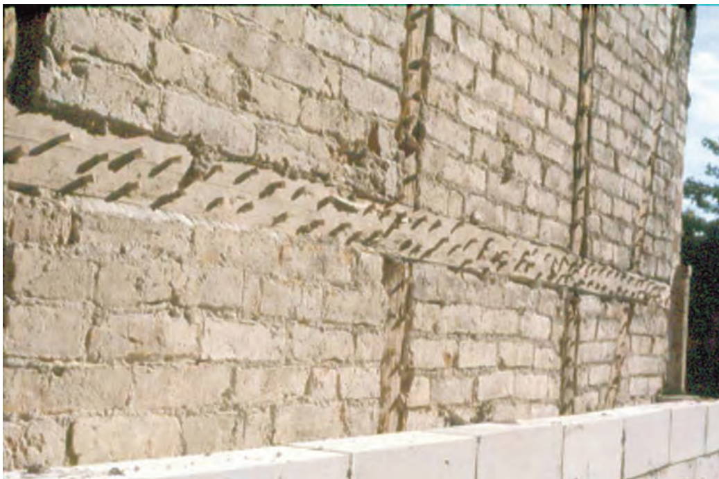
Gavelsidan mellan Sista supen och bostadsbuset på Västgötegatan 28 tilläggsisolerar med lättbetongstenar 1979. Byggnadens fasad avtäcktes helt inför ombyggnationen. I förgrunden syns sista supen. Foto från Norrköpings stadsmuseum.
