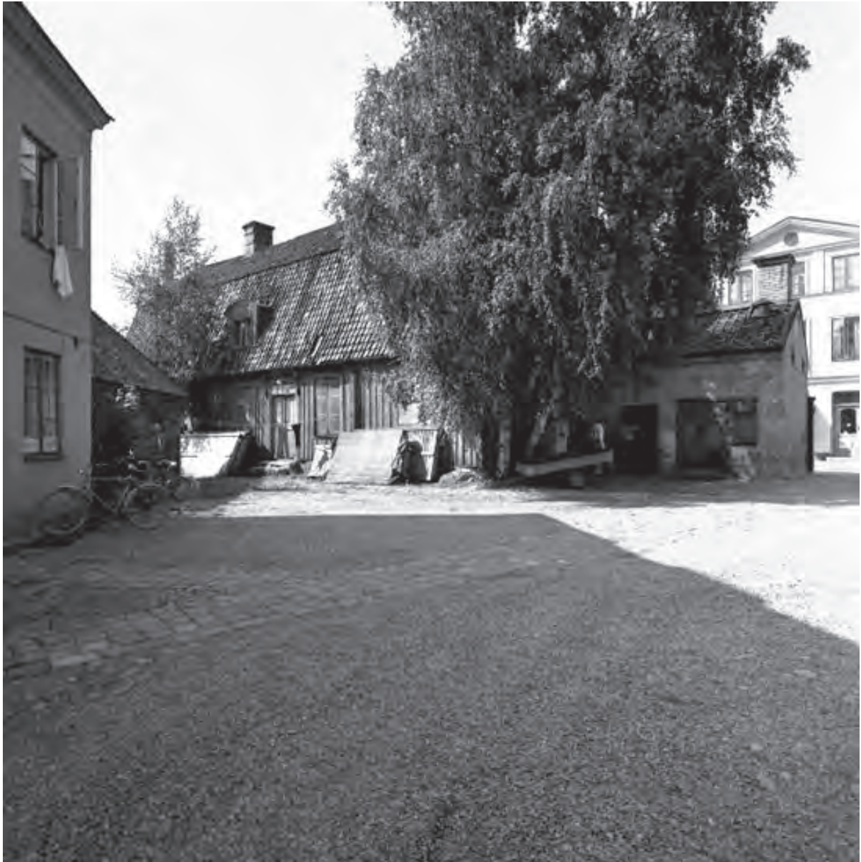
Foto av innergården på Mjölaren 14, taget innan rivningarna 1971. De stora ytorna är belagda med grus och inom området finns gatstensbelagda gångar. Viss växtlighet har tillåtits stå kvar nära byggnaderna. Foto från Norrköpings stadsmuseum.
