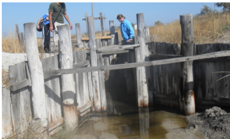
Рис. 7. – Шлюзи, які регулюють надходження морської води до озер Геройського солепромислу. Світлина 2016 р.
