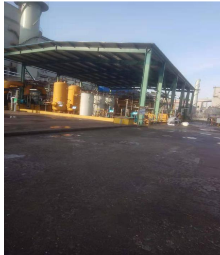
液氨罐区地面
