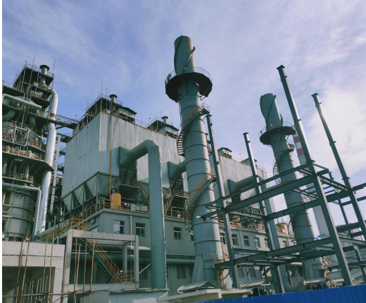
石灰窑燃烧废气（排气筒）
