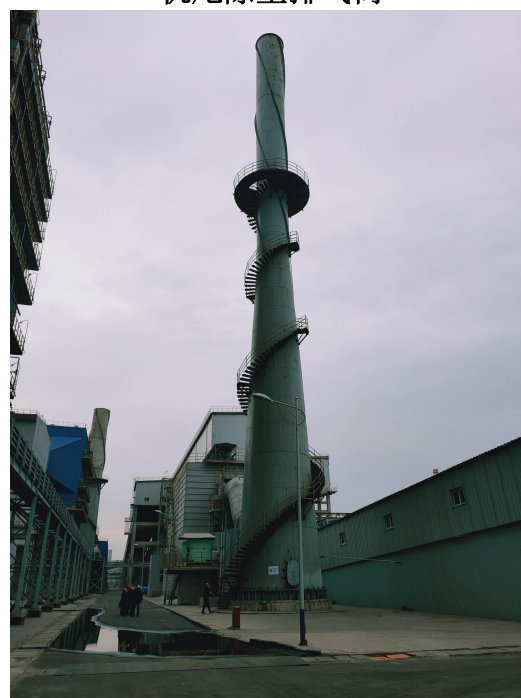
整理筛分和成品除尘排气筒
