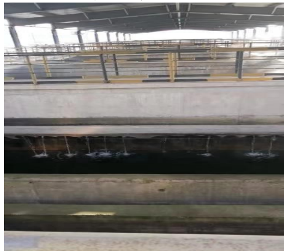
污水处理站均质滤料池
