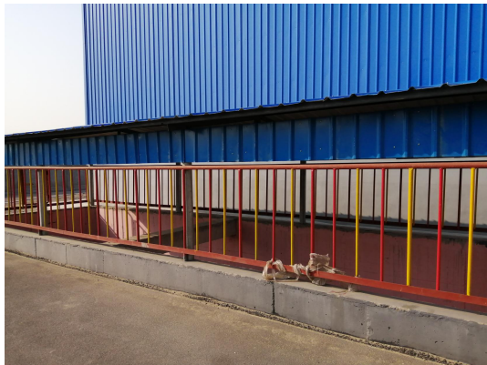
危废区事故水池
