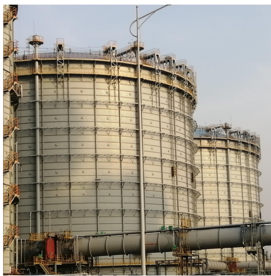
转炉煤气柜及周边围墙
