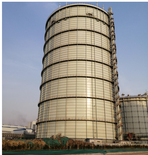
高炉煤气柜及周边围墙
