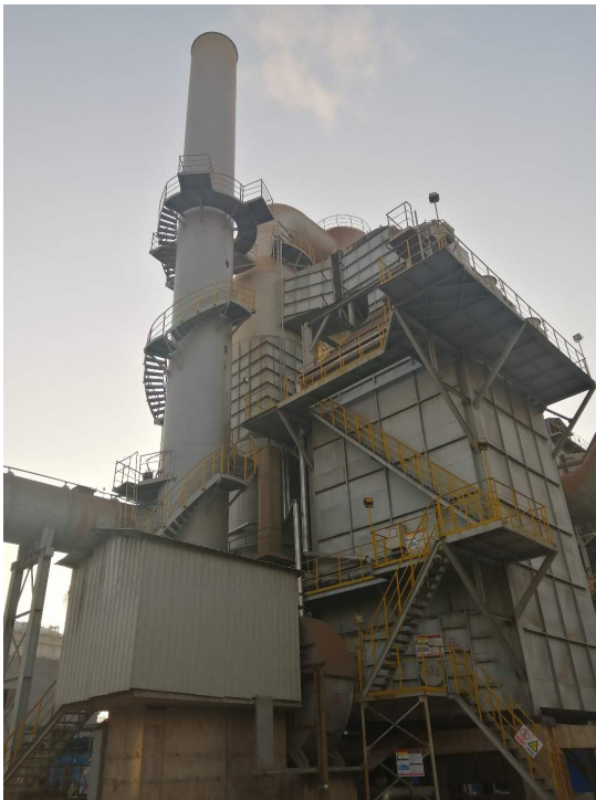
2#钢渣处理一次除尘系统（排气筒）
