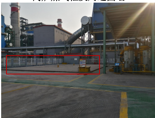
氨区地下事故池
