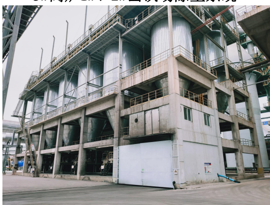
高炉煤气袋式除尘
