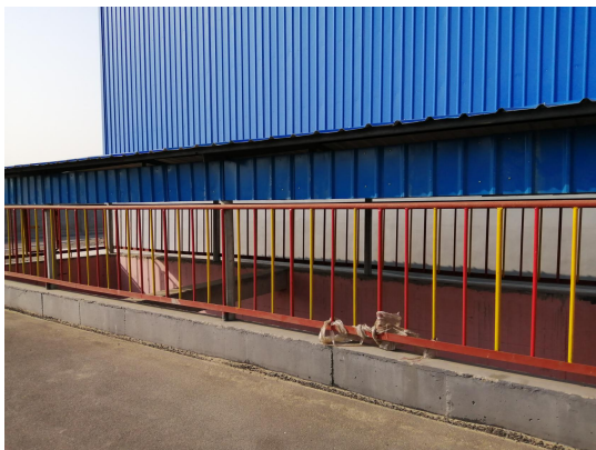
危废区事故水池
