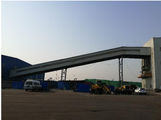
封闭转运连廊
