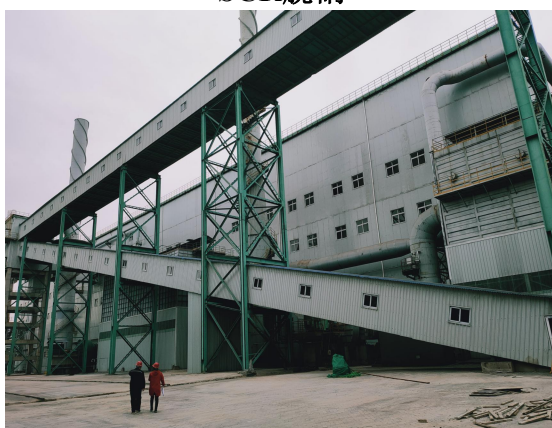
燃破和配料仓排气筒
