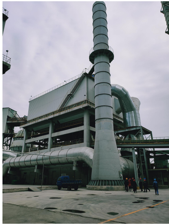
3#矿渣微粉生产线除尘系统（排气筒）
