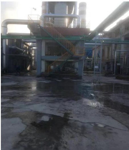
浓硫酸储罐区地面
