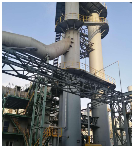
转炉二次烟气（排气筒）
