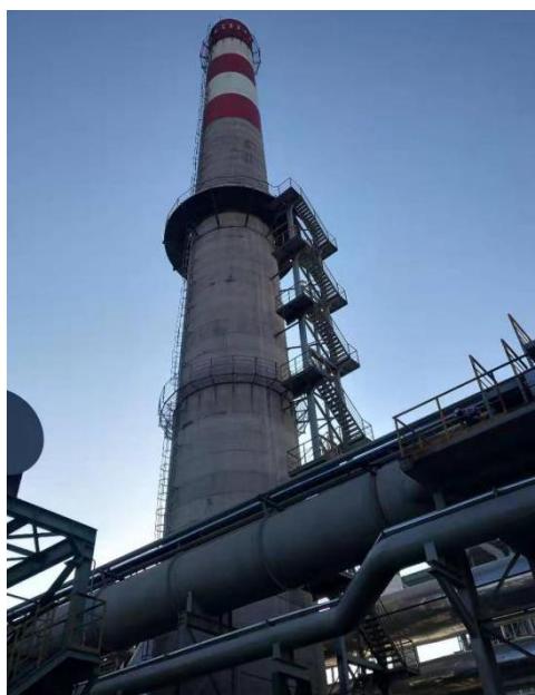
2#热风炉排气筒
