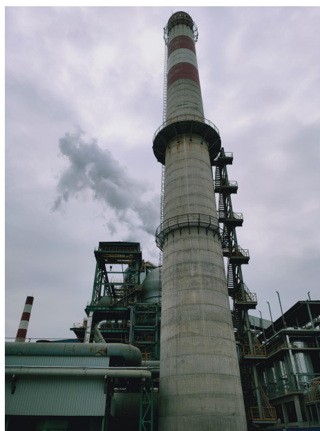
3#热风炉排气筒
