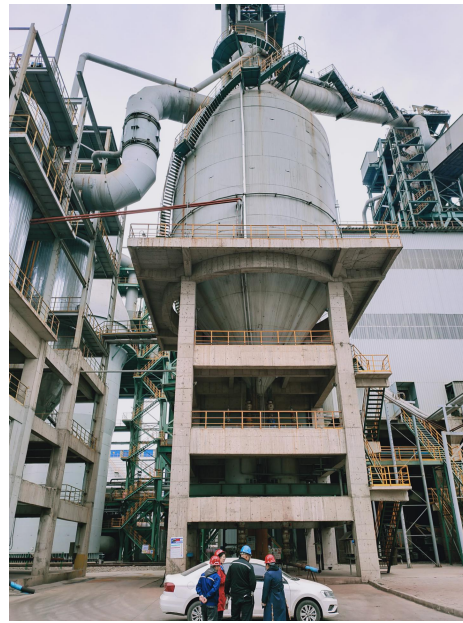
高炉煤气重力除尘系统
